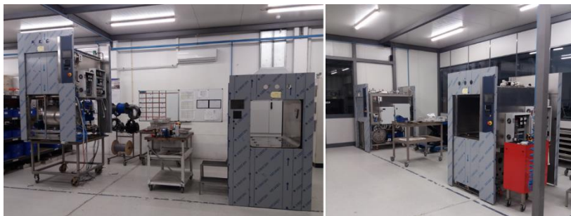
Figura 19 - Secção de Montagem Elétrica e Pneumática (Elaboração Própria)
