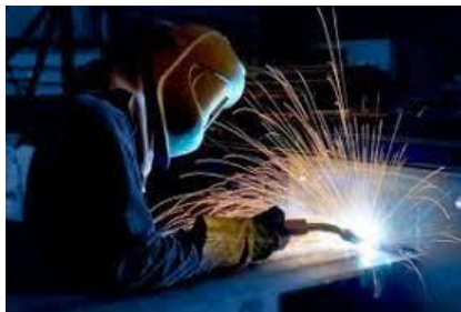
Figura 12 – Exemplo de soldadura oxiacetilénica.
