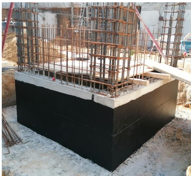
Figura 4-23 – Sapata com emulsão betuminosa (Extraído de: Telhabel, 2023b)
