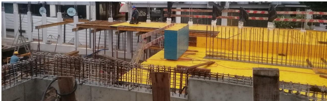
Figura 4-15 – Colocação do escoramento e cofragem de uma laje fungiforme aligeirada com moldes perdidos (Extraído de: Telhabel, 2023b)
