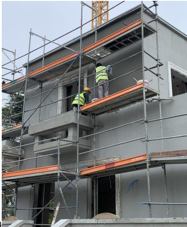
Figura 4-50 – Aplicação da 2.ª camada de “Webertherm Pro”
