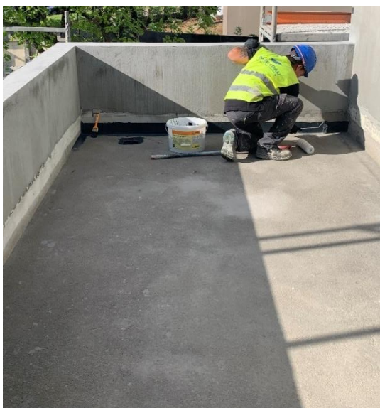
Figura 4-25 – Aplicação de “Primer Wet”
