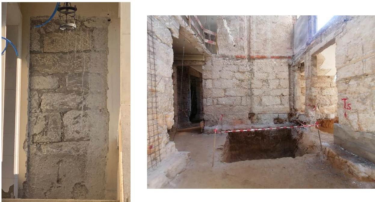
Figura 3-10 – Parede de enxilharia (Extraído de: Telhabel, 2023b)
