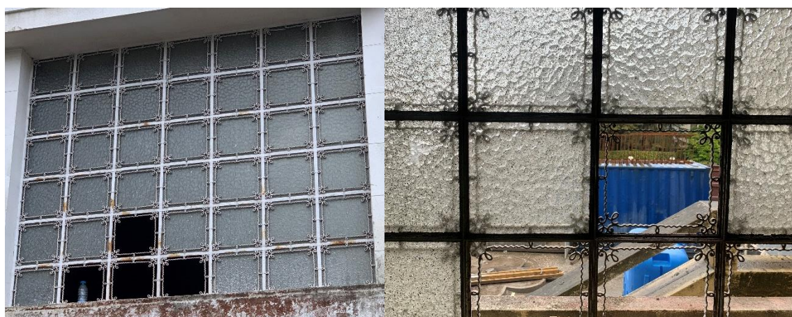
Figura 1-3 – Pormenor arquitetónico de uma janela
