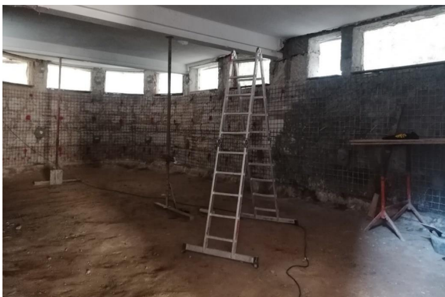
Figura 4-35 – Aplicação de betão projetado (Extraído de: Telhabel, 2023b)
