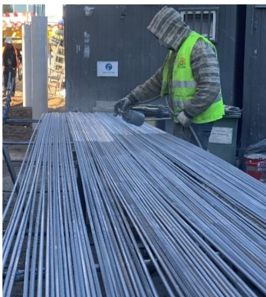
Figura 4-3 – Pintura das armaduras
