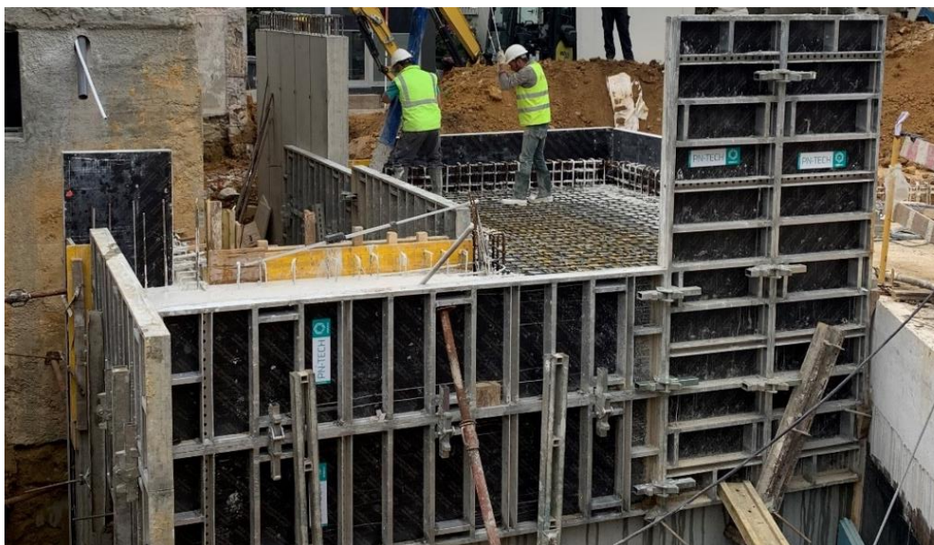
Figura 4-7 – Cofragem metálica com revestimento de contraplacado marítimo
