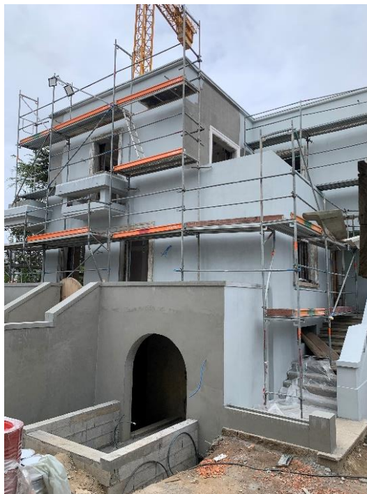
Figura 4-51 – Aplicação do primário “Weberprim Regulador”
