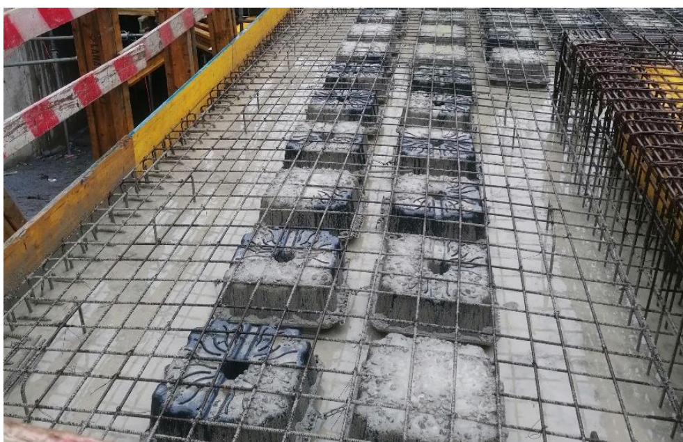
Figura 4-20 – Tempo de espera entre fases de betonagem de uma laje fungiforme aligeirada com moldes perdidos (Extraído de: Telhabel, 2023b)
