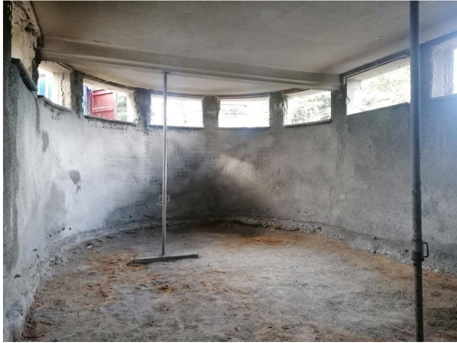
Figura 4-36 – Parede com betão projetado (Extraído de: Telhabel, 2023b)
