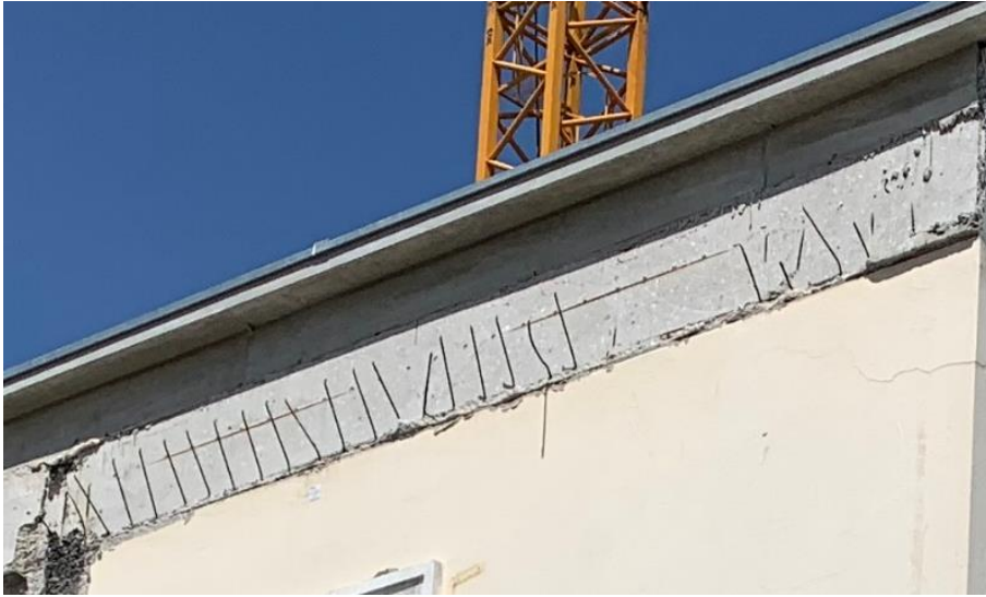
Figura 4-39 – Viga exposta antes da aplicação do microbetão
