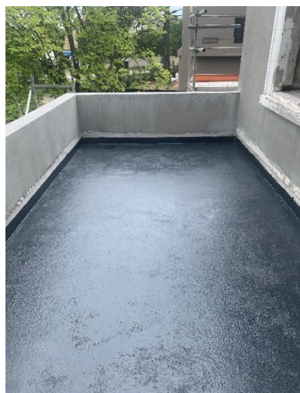
Figura 4-26 – Aspeto final da aplicação do primário “Primer Wet”
