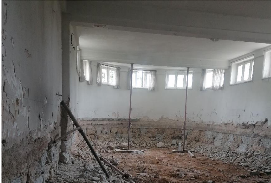
Figura 4-32 – Parede antes de começar o processo de reparação (Extraído de: Telhabel, 2023b)
