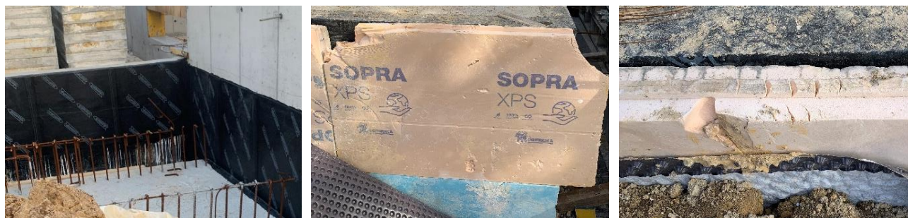
a) Aplicação de membrana de betume
