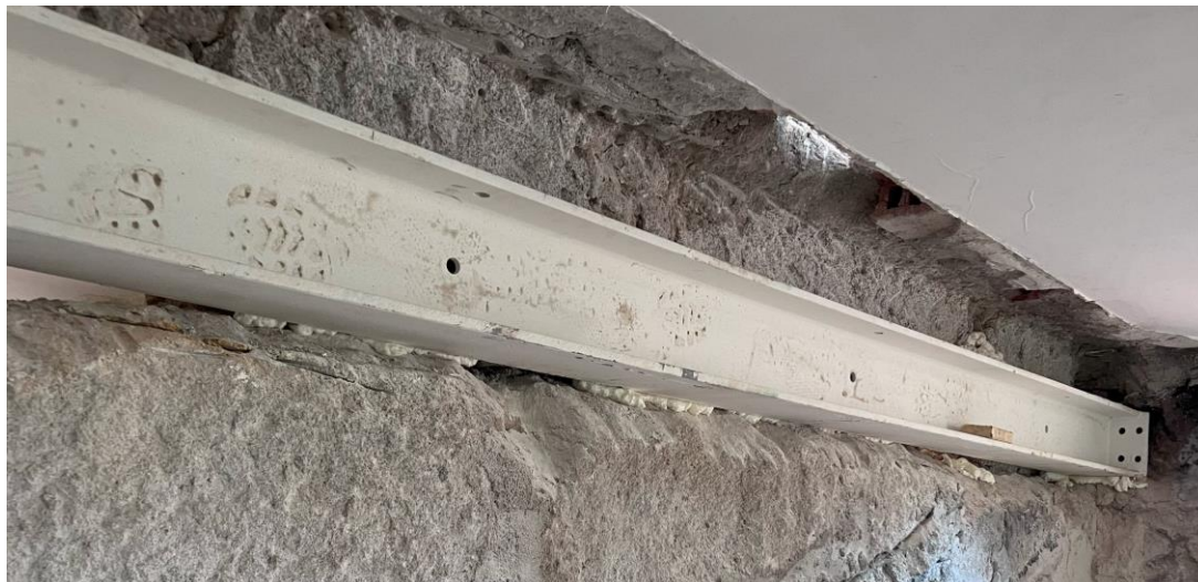
Figura 4-45 – Introdução de uma viga metálica na estrutura (Extraído de: Telhabel, 2023b)
