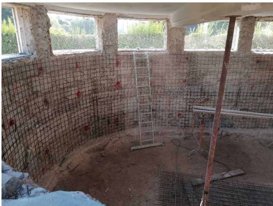
Figura 4-34 – Aplicação das armaduras nas paredes (Extraído de: Telhabel, 2023b)
