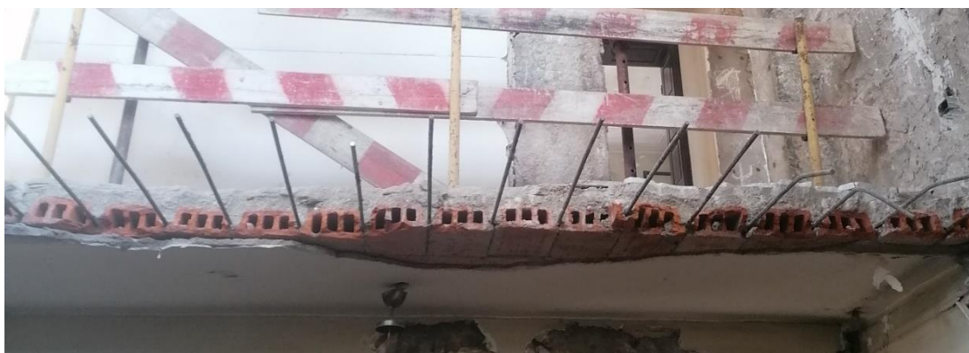
Figura 3-11 – Elementos constituintes de uma “placa de tijolo armado” (Extraído de: Telhabel, 2023b)
