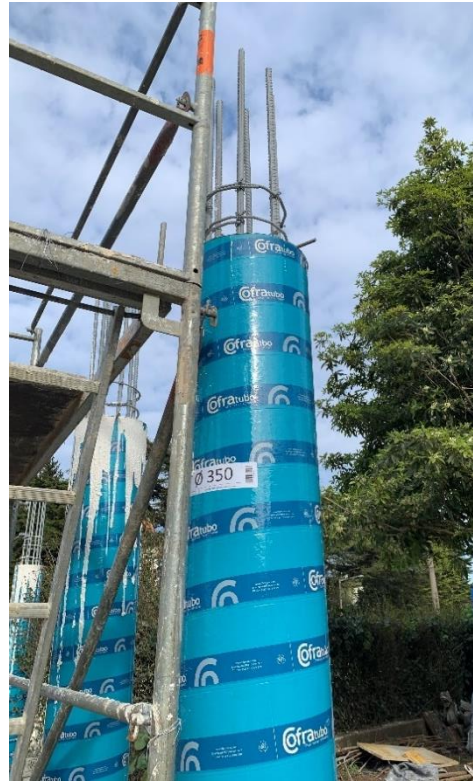
Figura 4-9 – Cofragem de cartão
