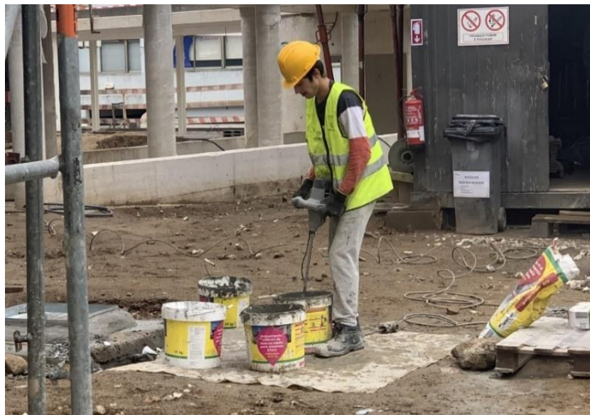
Figura 4-46 – Mistura do produto “Webertherm Pro” com água
