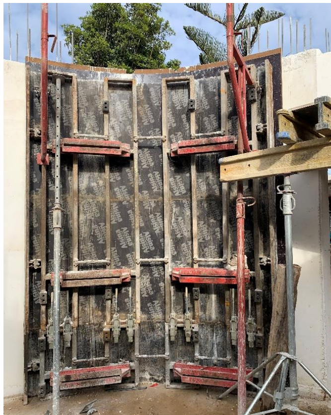
Figura 4-10 – Cofragem utilizada em zonas redondas
