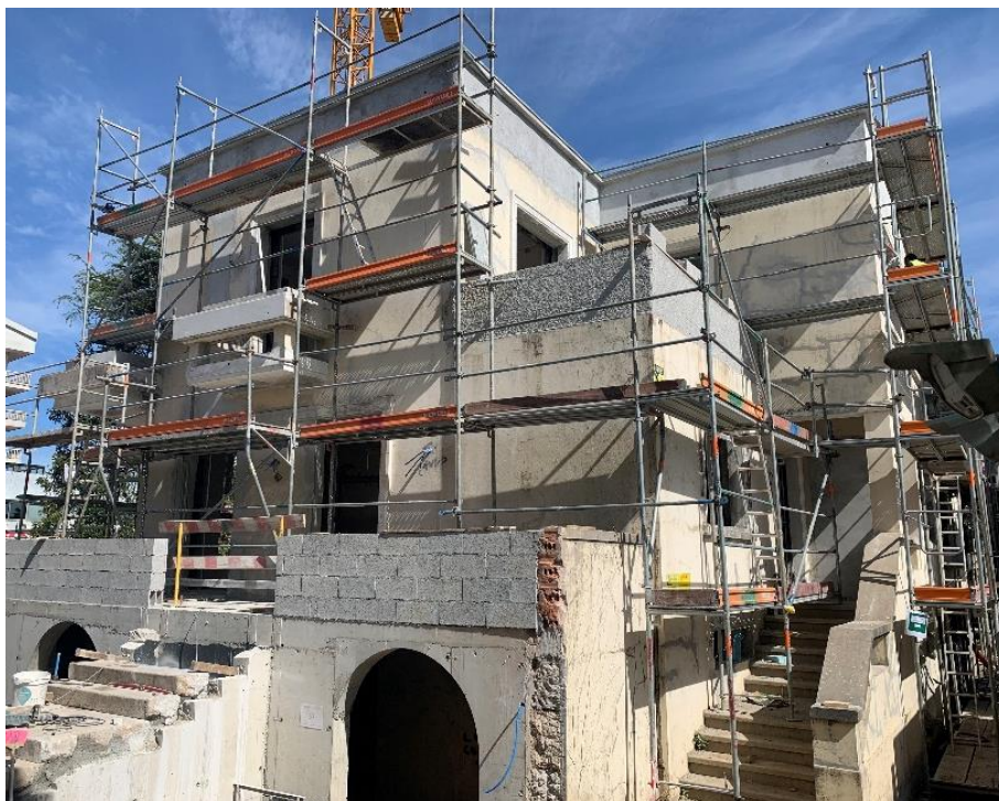
Figura 4-44 – Fachada depois do preenchimento das fissuras
