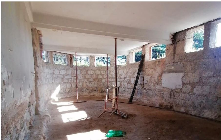
Figura 4-33 – Parede com os revestimentos retirados (Extraído de: Telhabel, 2023b)
