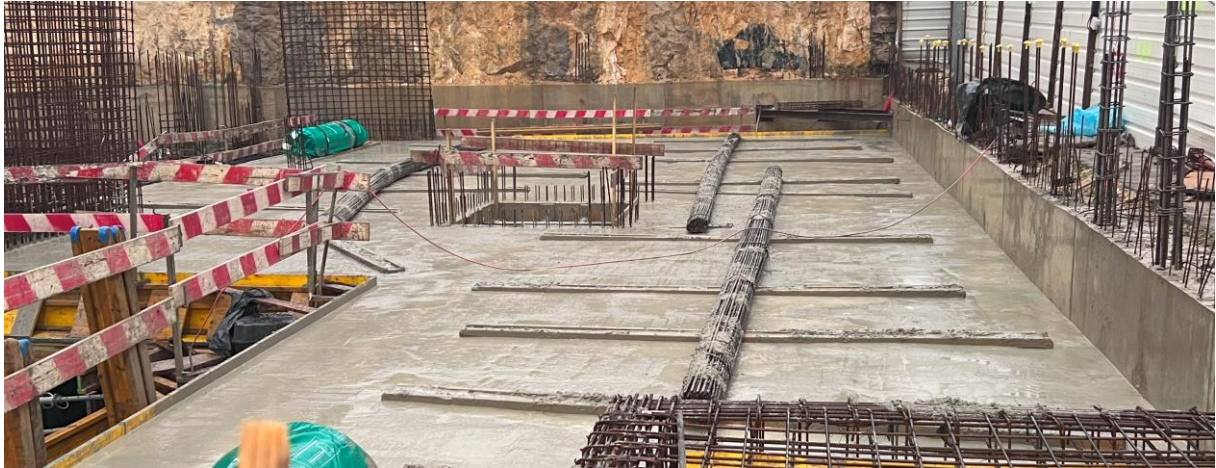
Figura 4-21 – Betonagem da 2.ª fase de uma laje fungiforme aligeirada com moldes perdidos (Extraído de: Telhabel, 2023b)
