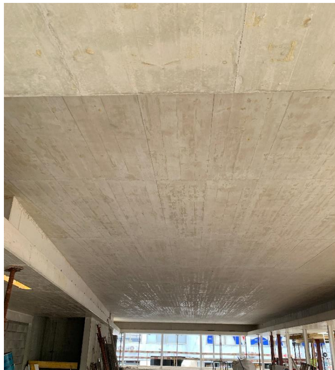
Figura 4-22 – Aspeto da face inferior de uma laje fungiforme aligeirada com moldes perdidos
