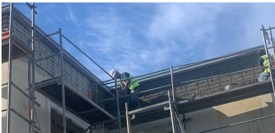
Figura 4-41 – Aplicação da primeira camada de microbetão
