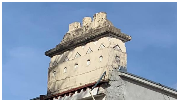
Figura 1-1 – Pormenor arquitetónico da chaminé
