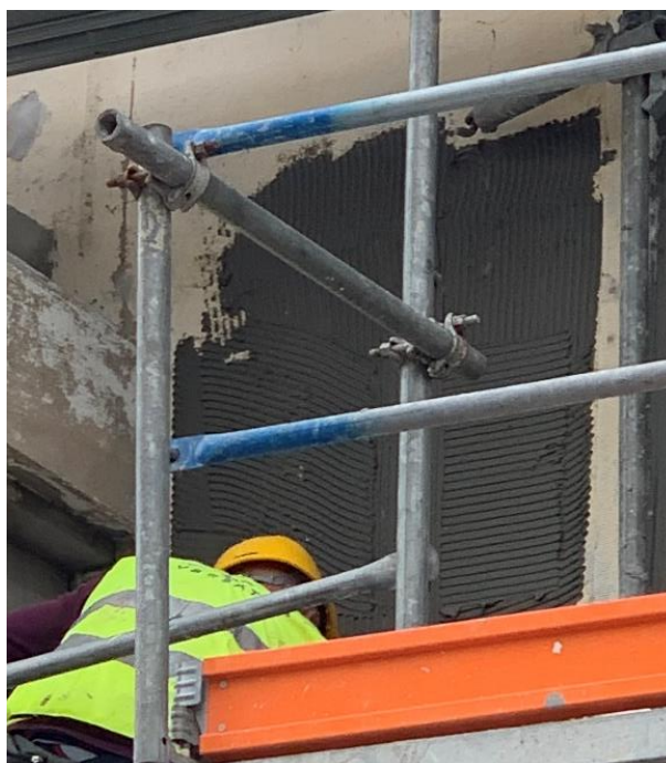
Figura 4-47 – Aplicação da 1.ª camada de argamassa “Webertherm Pro”
