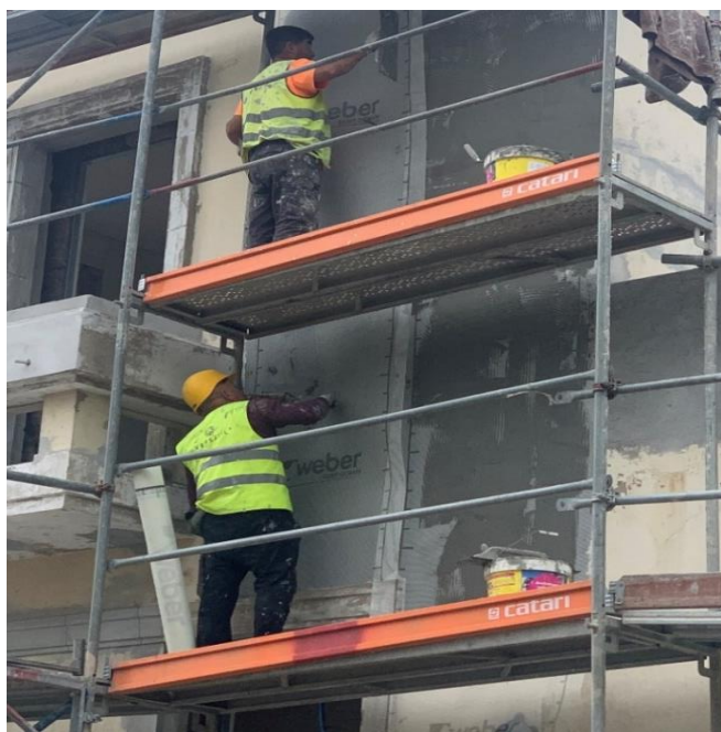
Figura 4-48 – Aplicação da rede sobre a 1.ª camada de argamassa “Webertherm Pro”
