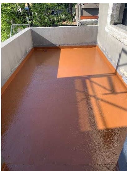
Figura 4-29 – “Tecnotop 2C” em varandas
