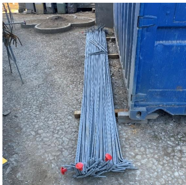
Figura 4-4 – Acondicionamento das armaduras pintadas
