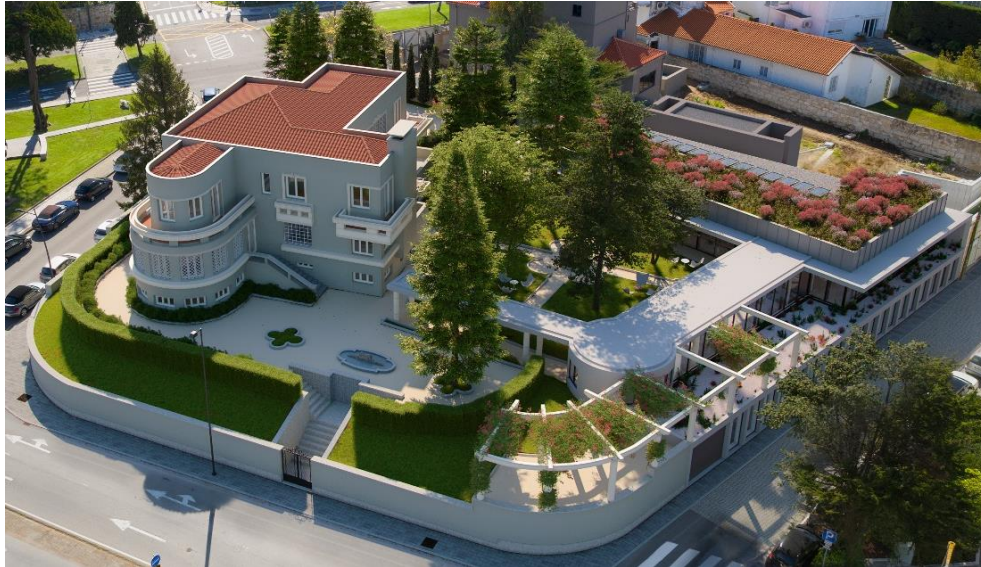
Figura 1-4 – Desenho isométrico 3D do exterior do Palacete Marechal 50 (Extraído de: Telhabel, 2023b)
