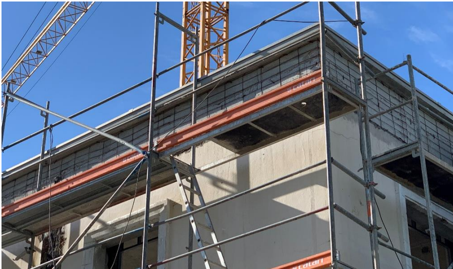
Figura 4-40 – Colocação de armadura na viga
