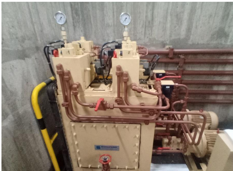
Figura 25 Unidade Energética Sorefame (Fonte: Navipa)
