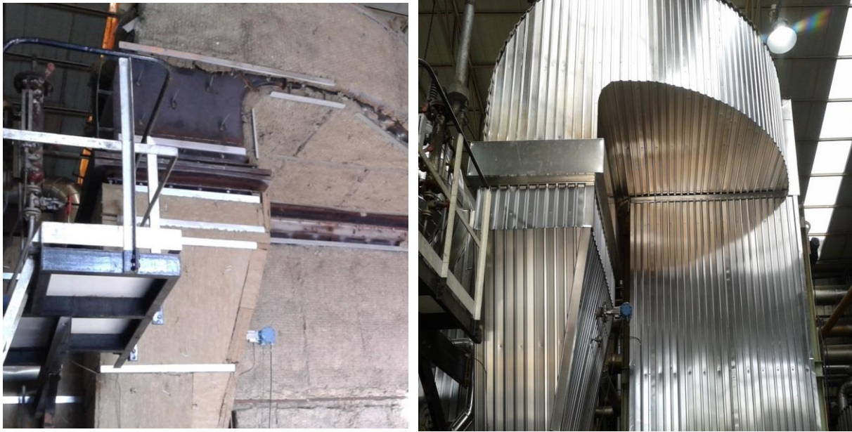
Figura 3.5 - Economizador antes e após a manutenção.
