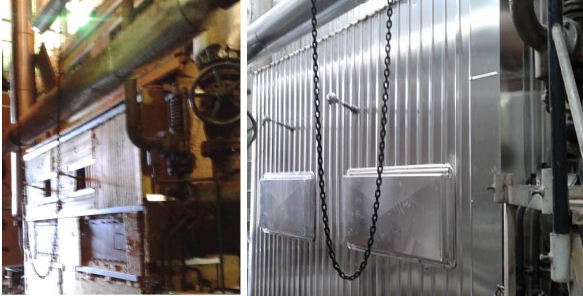
Figura 3.4 - Sobreaquecedor antes e após a manutenção.
