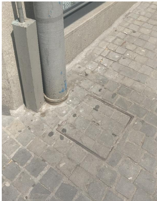
a) Correta execução de ligação de tubo de queda à câmara de águas pluviais.
