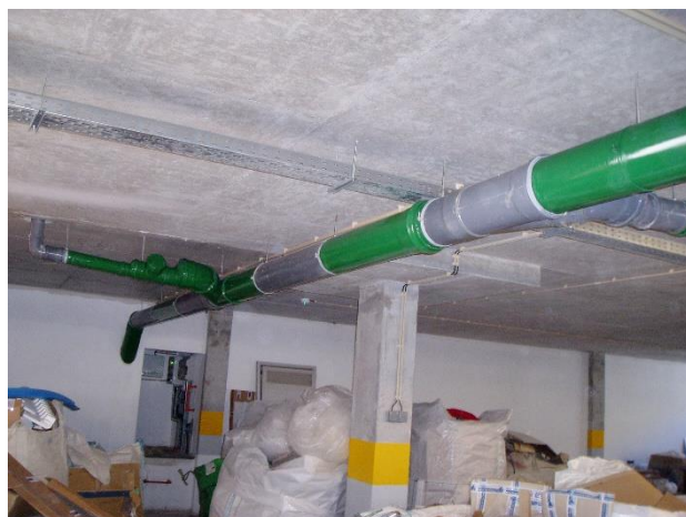
Figura 3.41– Canalização em conformidade com a NP 182 para águas residuais pluviais.
