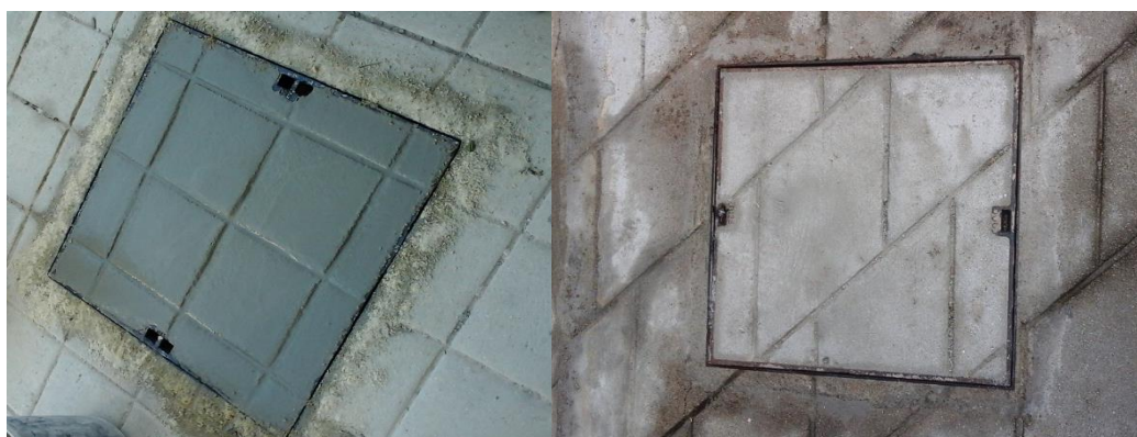
a) Imagem de uma tampa executada em fase inicial
