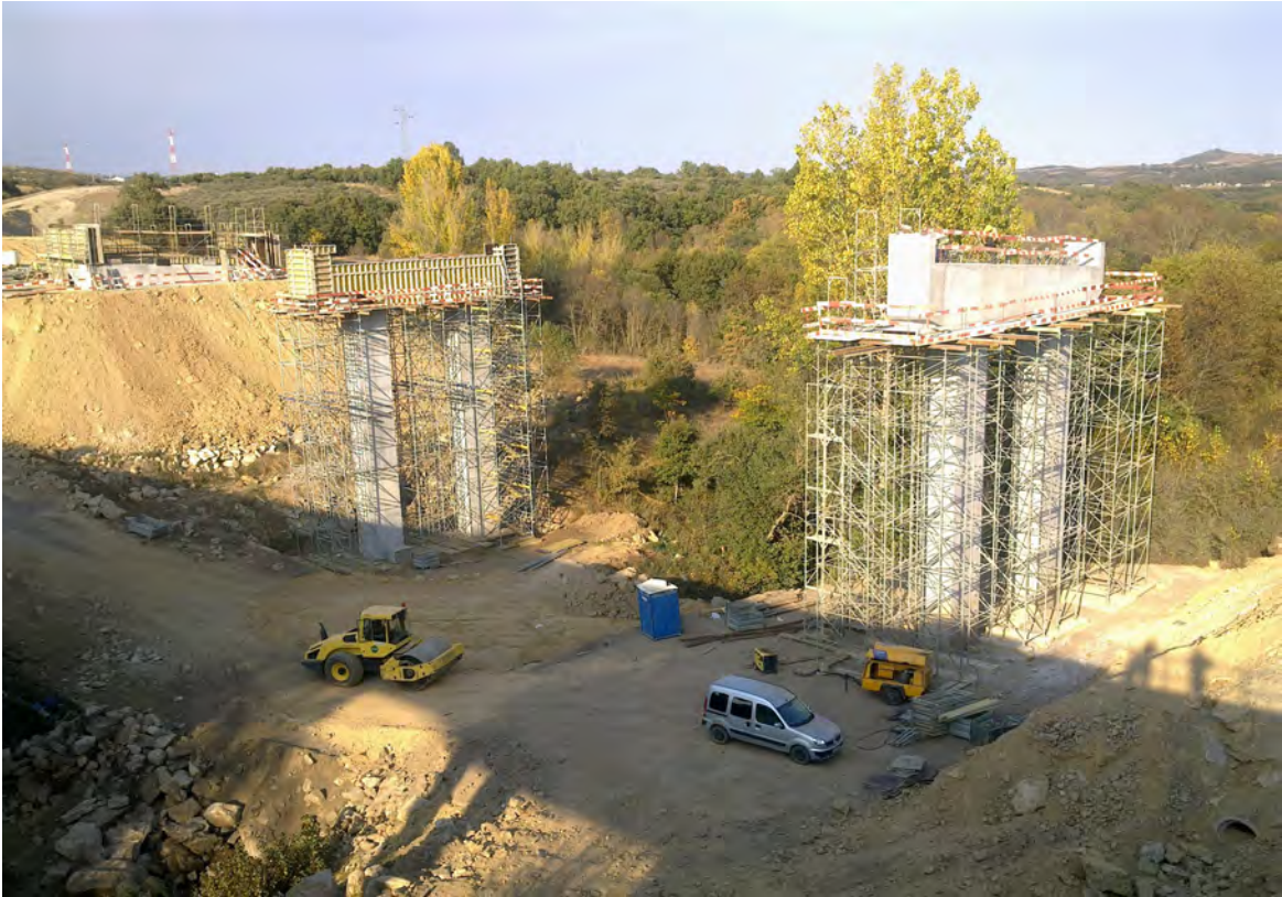
Figura 3.6 – Execução de vigas travessa na Ponte sobre a Ribeira de Santa Comba de Rossas
