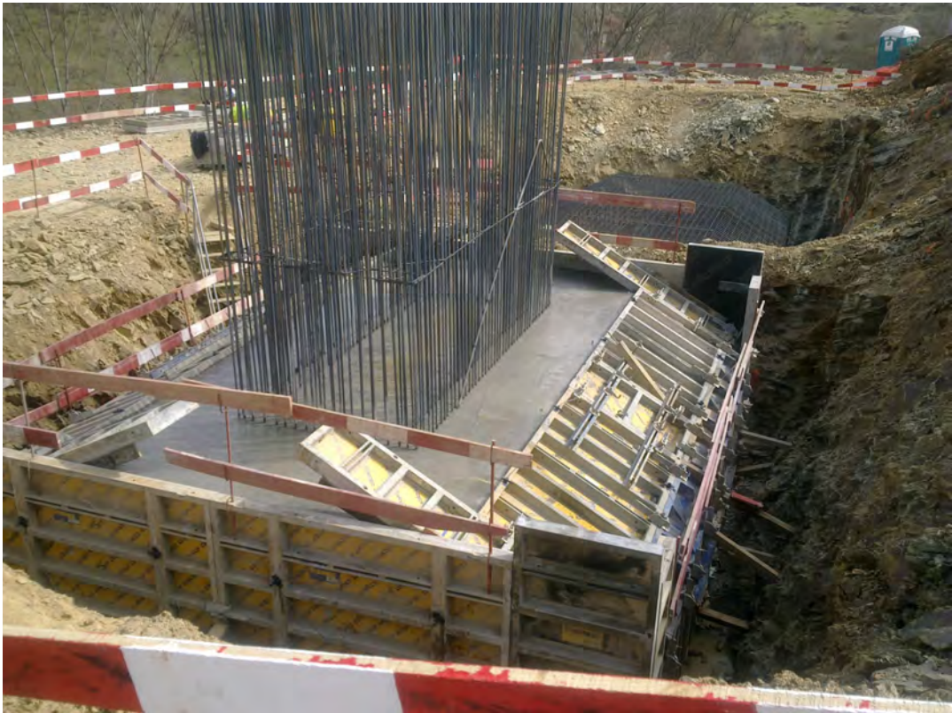
Figura 3.1 – Execução de sapatas.
