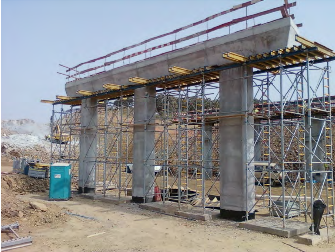
Figura 2.14 – Execução de vigas travessa
