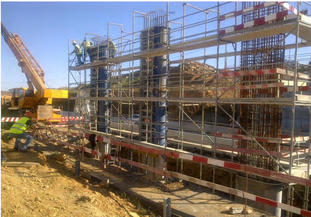
Figura 2.11 – Execução de pilares
