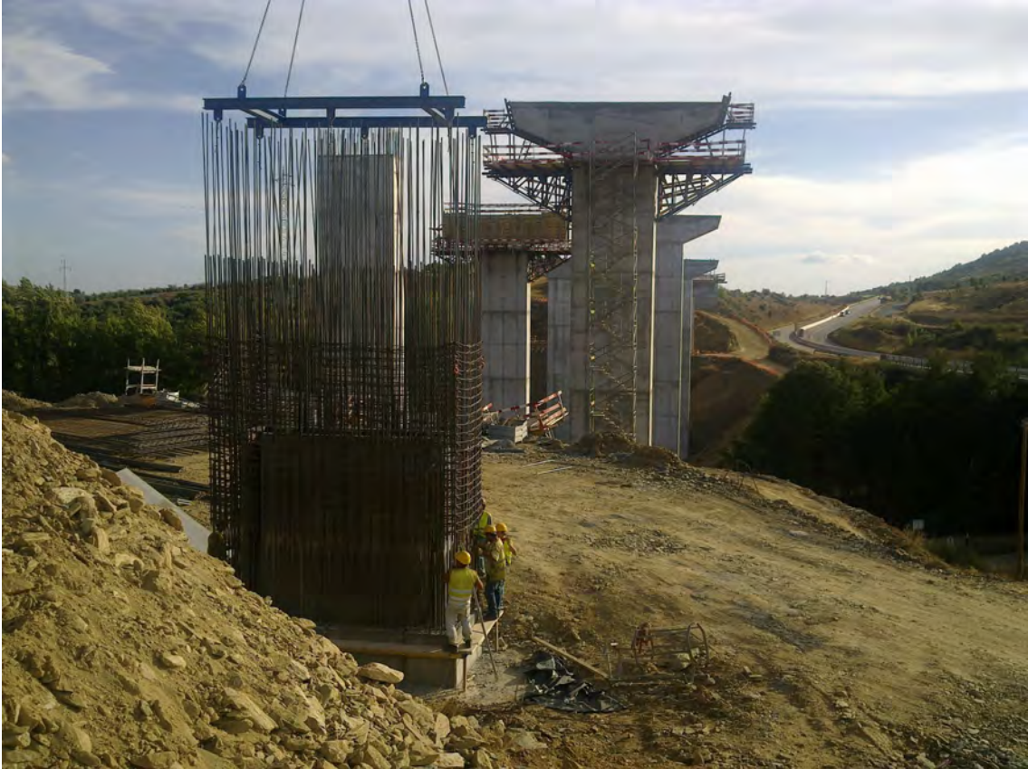
Figura 3.3 – Execução de pilares na Ponte sobre o Rio Azibo
