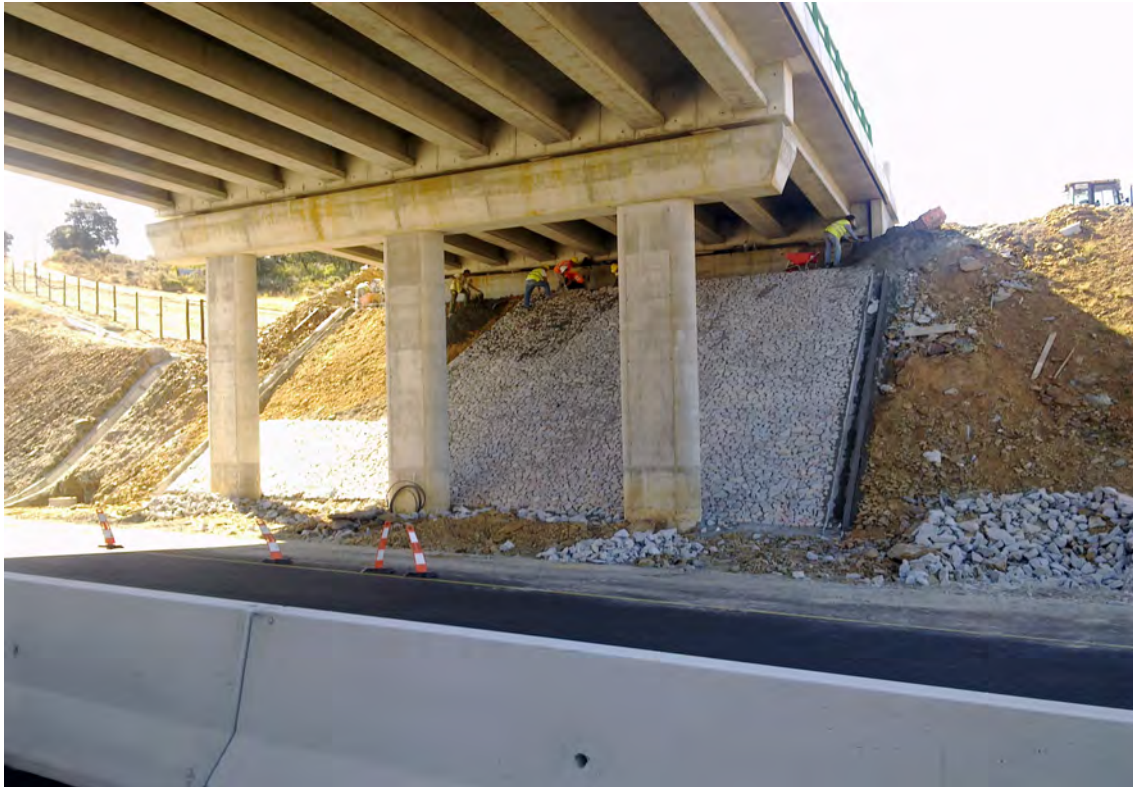
Figura 2.46 – Revestimento de taludes.
