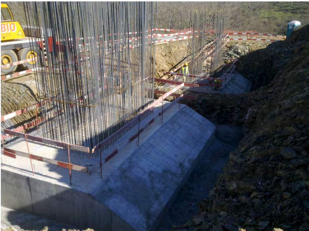
Figura 3.2 – Execução de recrava nas sapatas.
