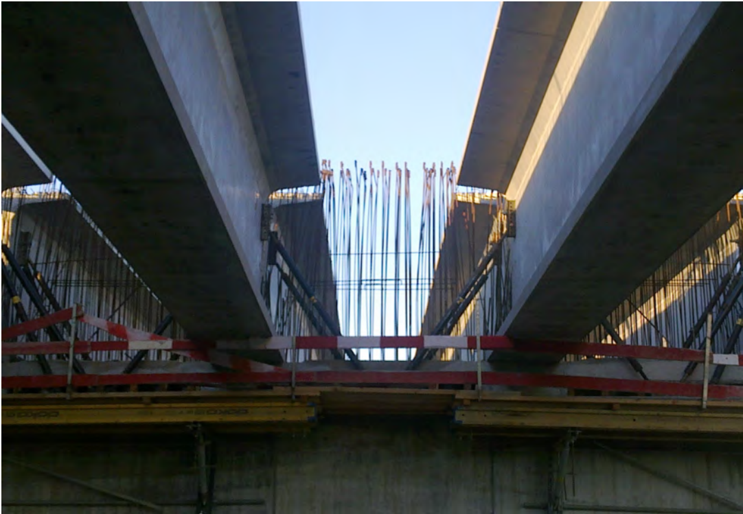
Figura 3.20 – Escoramento provisório das vigas na Ponte sobre o Rio Azibo.
