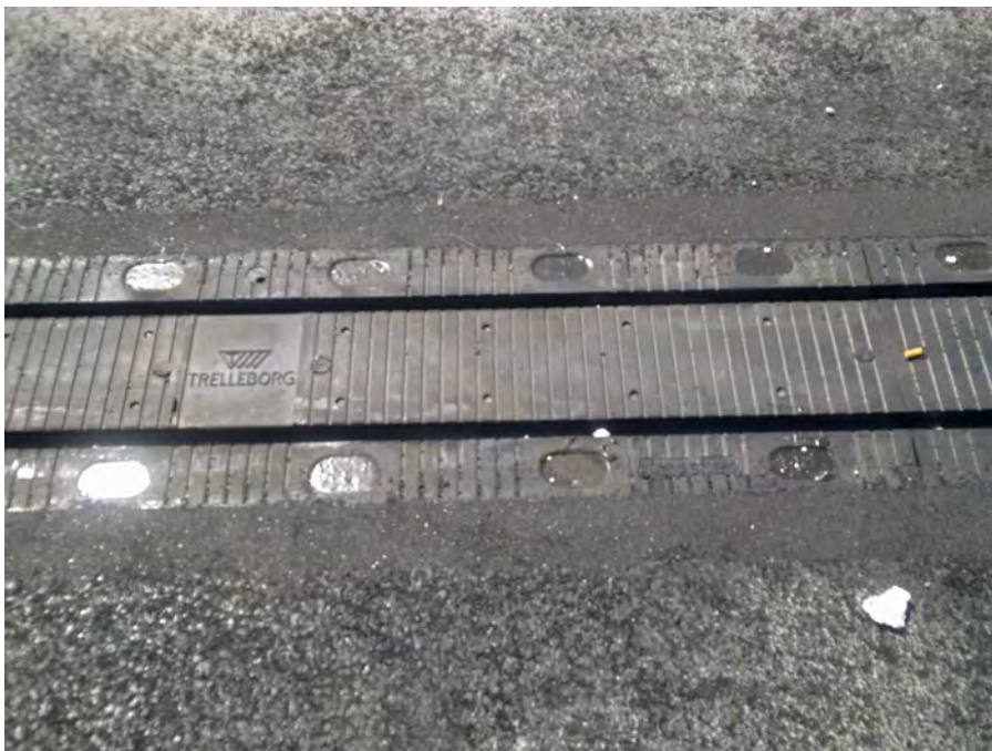
Figura 2.44 – Selagem dos elementos de aperto.
