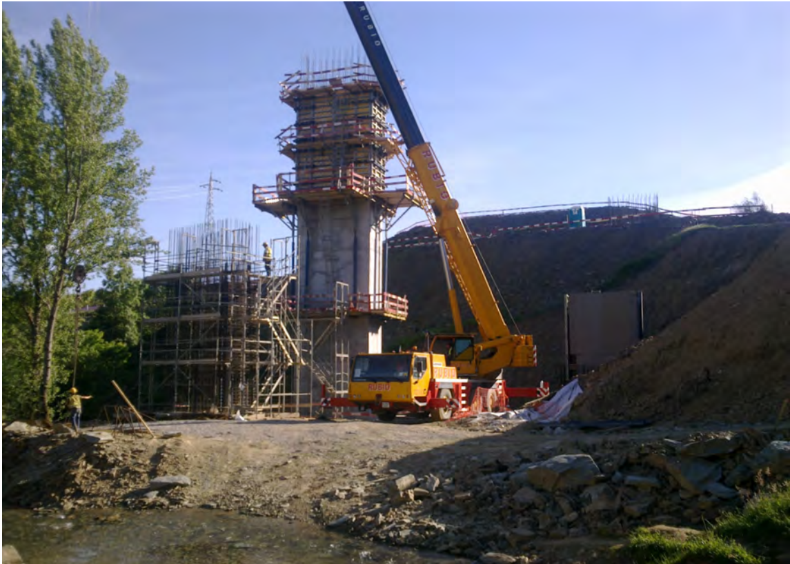
Figura 3.4 – Execução de pilares. Execução da armadura no exterior.
