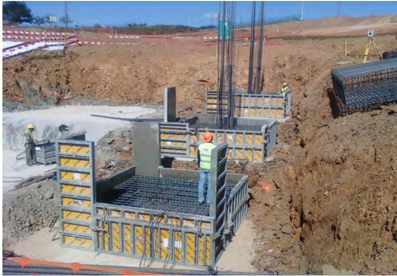
Figura 2.4 – Execução de sapatas.
