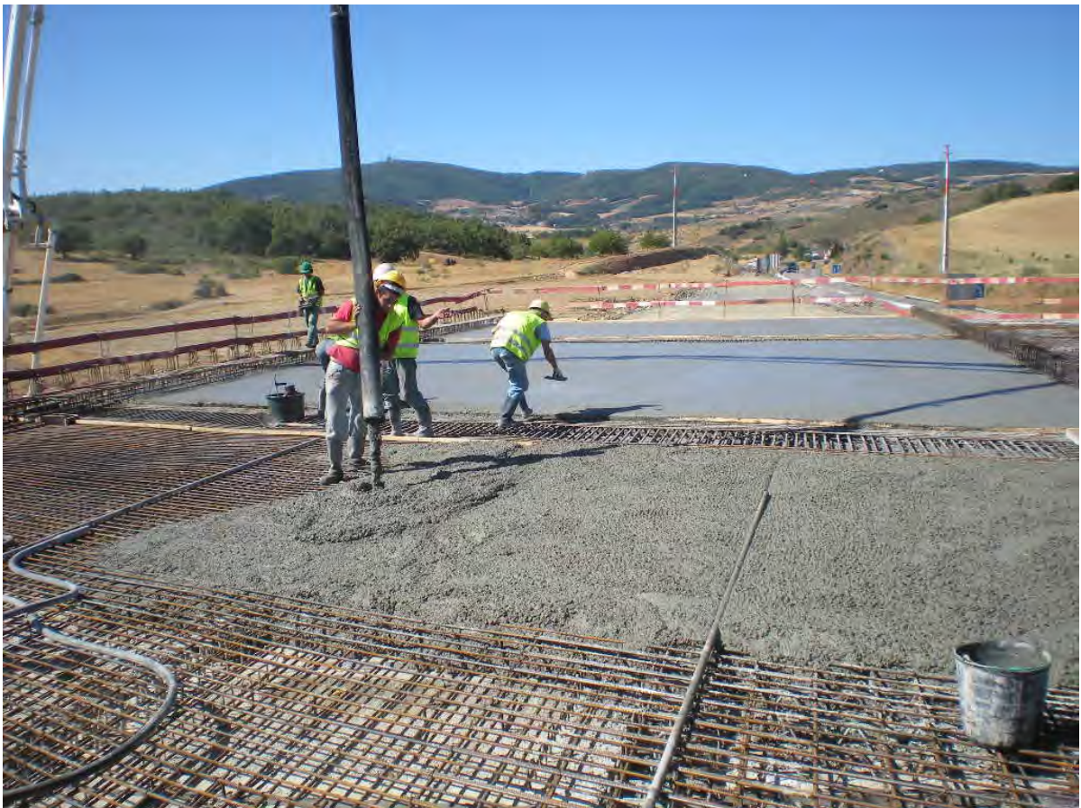
Figura 2.27 – Betonagem de tabuleiro sem pré-esforço
