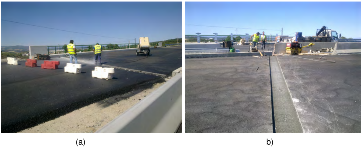
Figura 2.40 – Remoção do betuminoso (a) e preparação da base (b).
