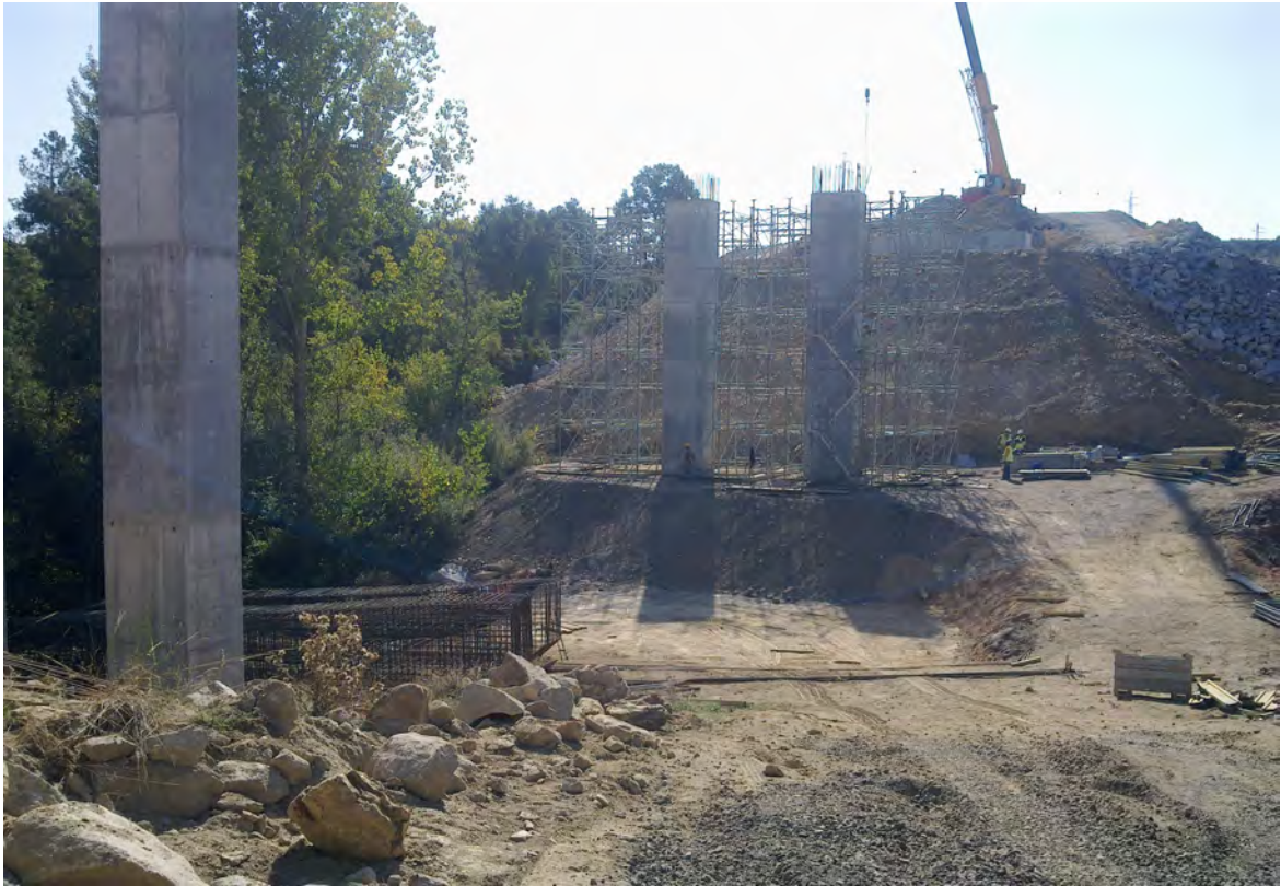
Figura 3.5 – Execução de vigas travessa na Ponte sobre a Ribeira de Santa Comba de Rossas
