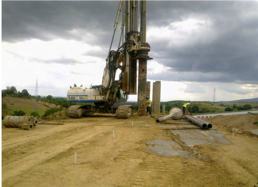
Figura 2.6 – Furação e introdução dos tubos.
