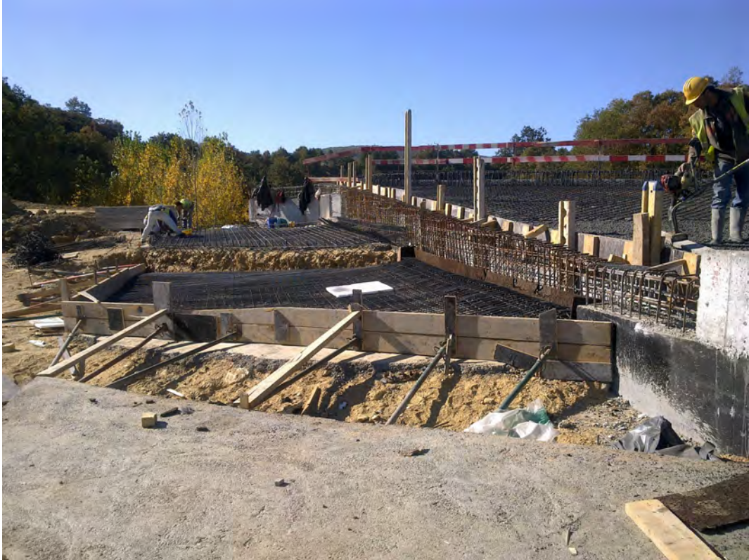
Figura 2.18 – Execução da laje de transição.
