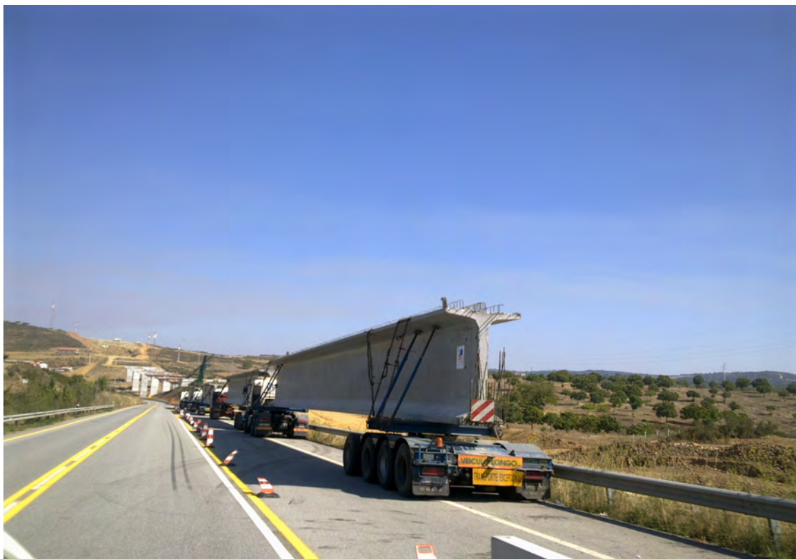
Figura 3.18 – Transporte das vigas pré-fabricadas para a Ponte sobre o Rio Azibo.
