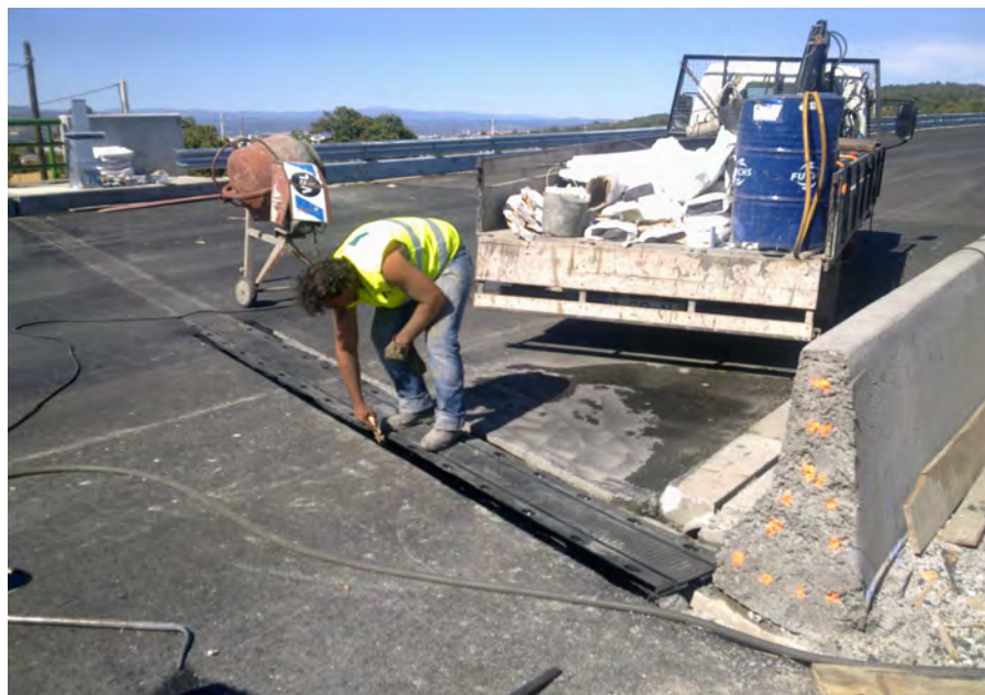
Figura 2.43 – Execução das bandas de transição.
