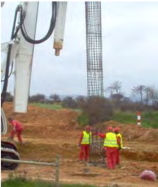
Figura 2.7 – Colocação da armadura
