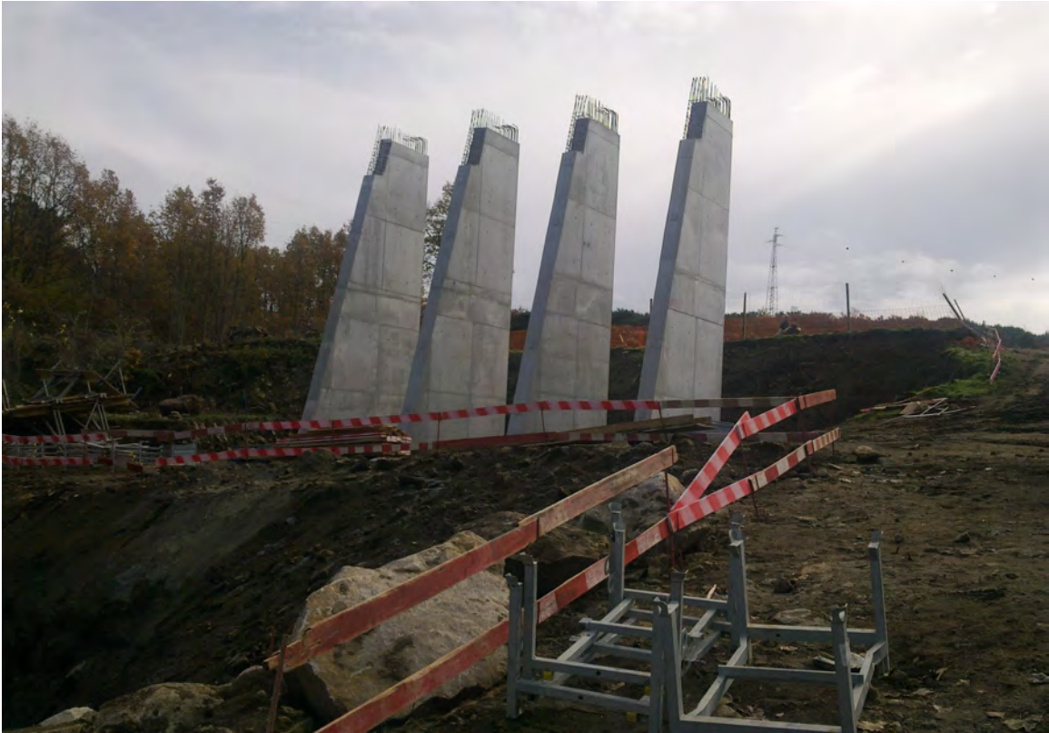
Figura 3.9 – Execução de encontros na Ponte sobre a Ribeira de Santa Comba de Rossas
