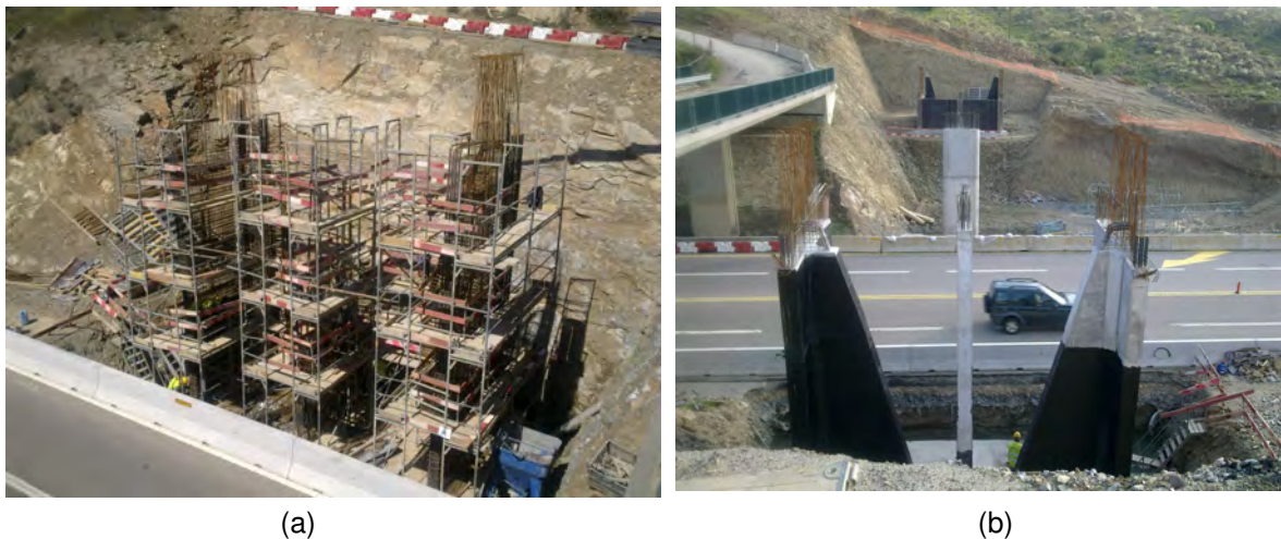
Figura 2.16 – Colocação da armadura em gigantes do encontro (a) e impermeabilização de gigantes do encontro (b).
