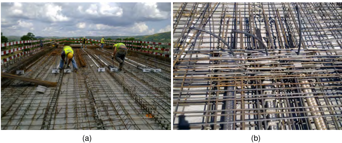
Figura 2.25 – Colocação das bainhas de pré-esforço, cabos de pré-esforço e ancoragens no tabuleiro (a) e armadura de reforço, ancoragens e purgas para a injeção (b).
