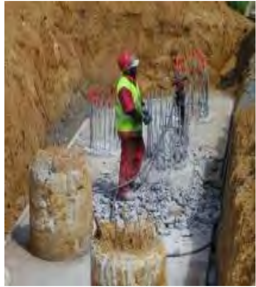
Figura 2.10 – Saneamento da cabeça da estaca
