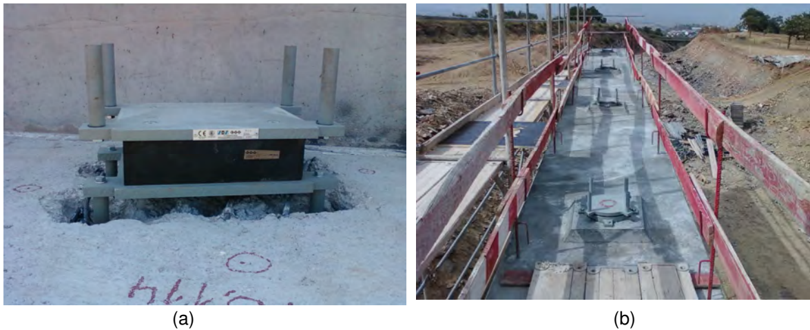
Figura 2.19 – Aparelho de apoio com pernos posicionado nos negativos (a) e aparelhos de apoio com plinto concluído (b).
