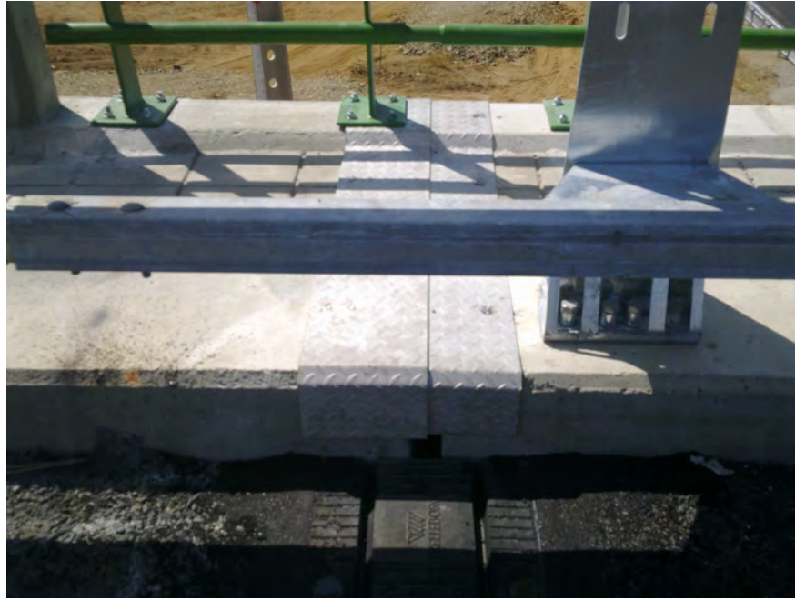
Figura 2.45 – Juntas de dilatação em passeios
