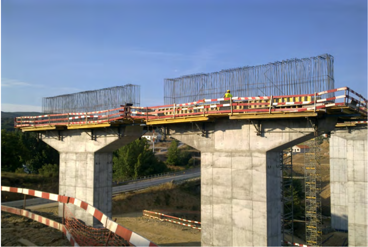
Figura 3.17 – Execução da 1.ª Fase da carlinga nos capitéis do pilar P1 Norte e Sul da Ponte sobre o Rio Azibo.
