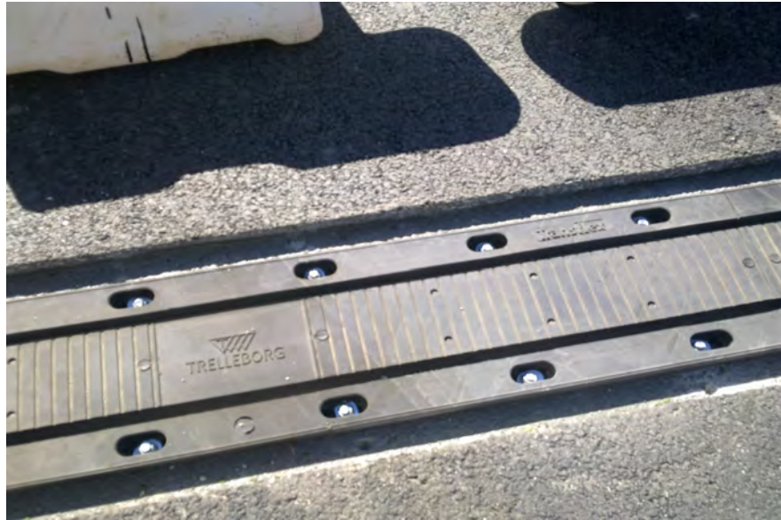
Figura 2.42 – Fixação da junta.
