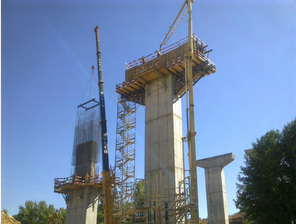
Figura 3.7 – Execução de pilar e capitel na Ponte sobre o Rio Azibo
