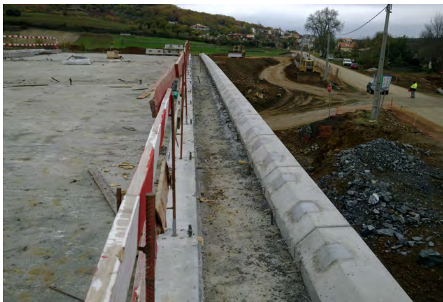
Figura 2.30 – Selagem dos negativos das vigas de bordadura
