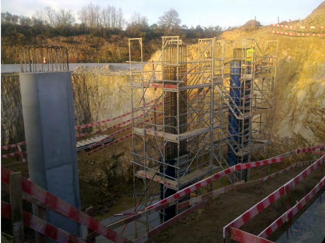
Figura 2.12 – Execução de pilares
