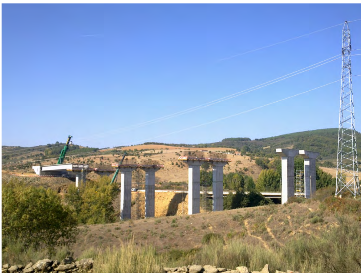
Figura 3.19 – Colocação das vigas pré-fabricadas na Ponte sobre o Rio Azibo.
