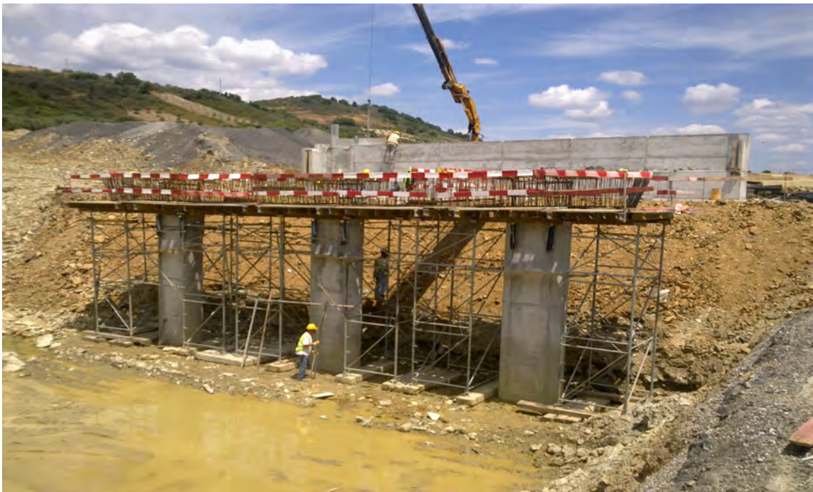
Figura 2.13 – Execução de vigas travessa
