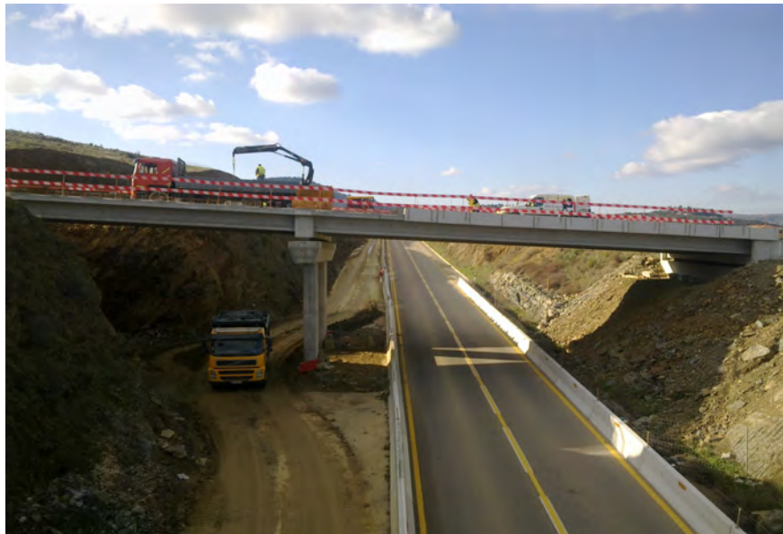
Figura 2.29 – Colocação de vigas de bordadura
