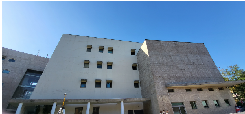
Figura 4.10: Edifício F do campus do ISEP.
