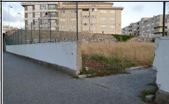
Fotografia 22 - Muro que limita o terreno visto da Avenida Sidónio Pais
