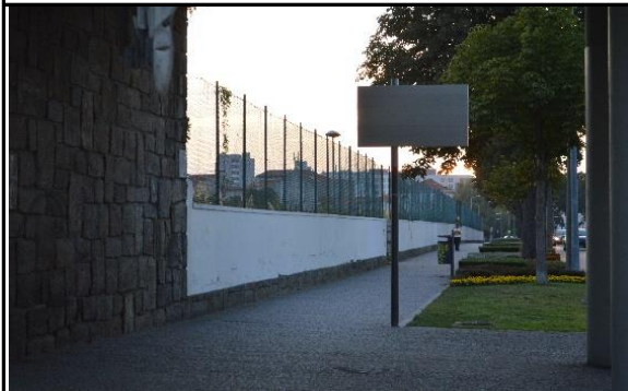
Fotografia 23 - Muro que limita o terreno visto da Avenida Sidónio Pais
