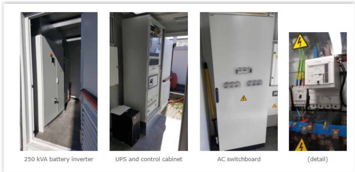
Figura 14- Componentes do PCS block, inversor de baterias, UPS, Quadro AC e cabine de controlo[13]
