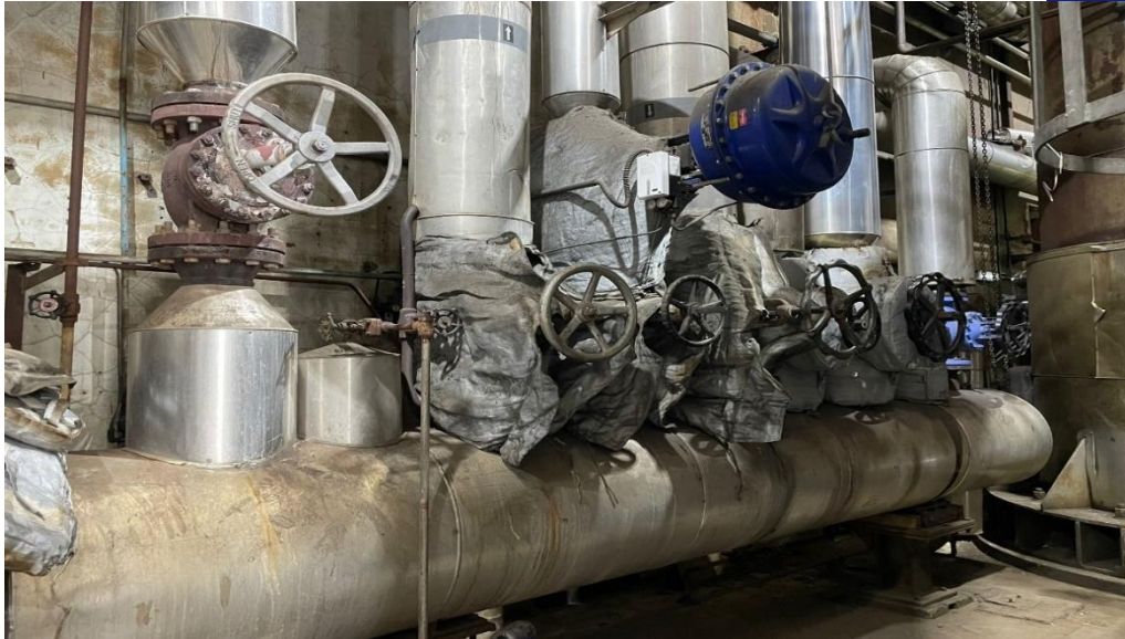
Figura 3.4 - Coletor de Alta Pressão
