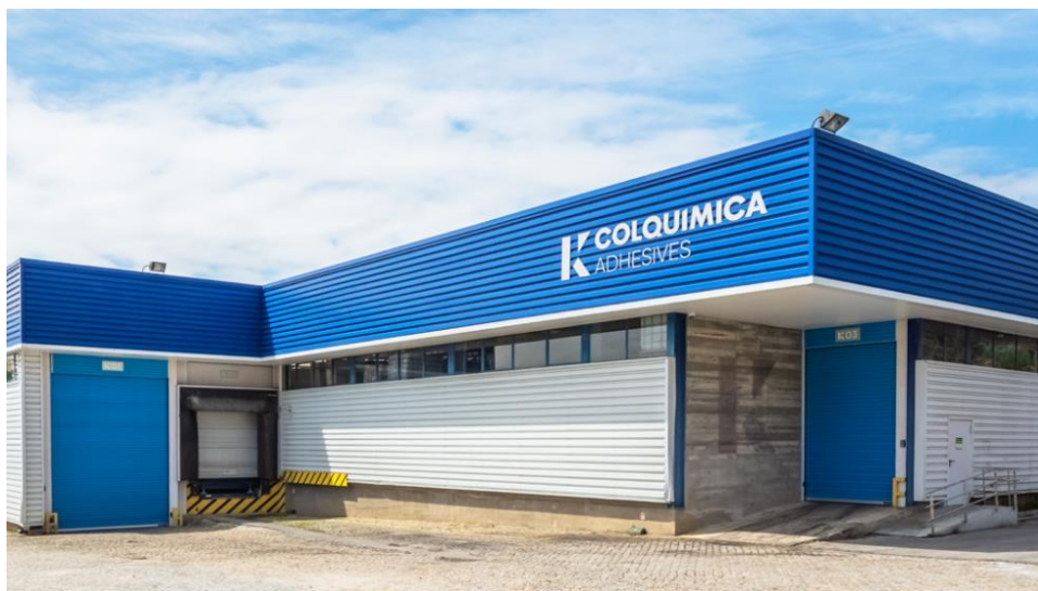
Figura 1 - Instalações da Colquímica, susão
