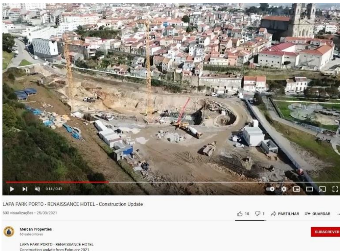
Figura 18 Recorte de ecrã retirado do vídeo do promotor, onde se pode verificar a cratera para as fundações da construção e a colina do monte da Lapa ao fundo, assim como a escala das construções ali existentes, voltadas a poente. Vídeo disponível em: https://www.youtube.com/watch?v=_NaZjK8mAHw
