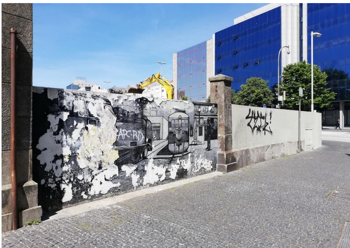
Figura 23 Imagem de registo da expedição ao lugar a 25 de Maio. A retroescavadora em operação, por trás do muro.
