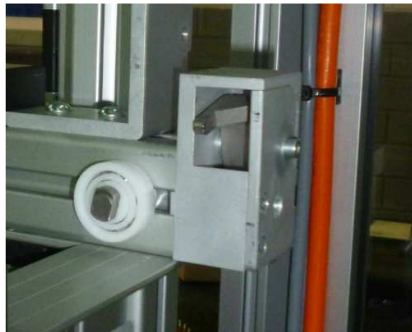
Figura 117 - Execução e aplicação de sistema de travamento das frames
