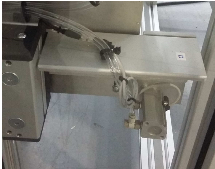
Figura 118 - Aplicação de atuadores RSQB20-20B da marca SMC no sistema de travamento das frames
