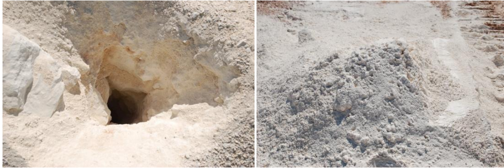
Figura 18 Furo e respectivo pó de furação onde foi realizada a análise.
