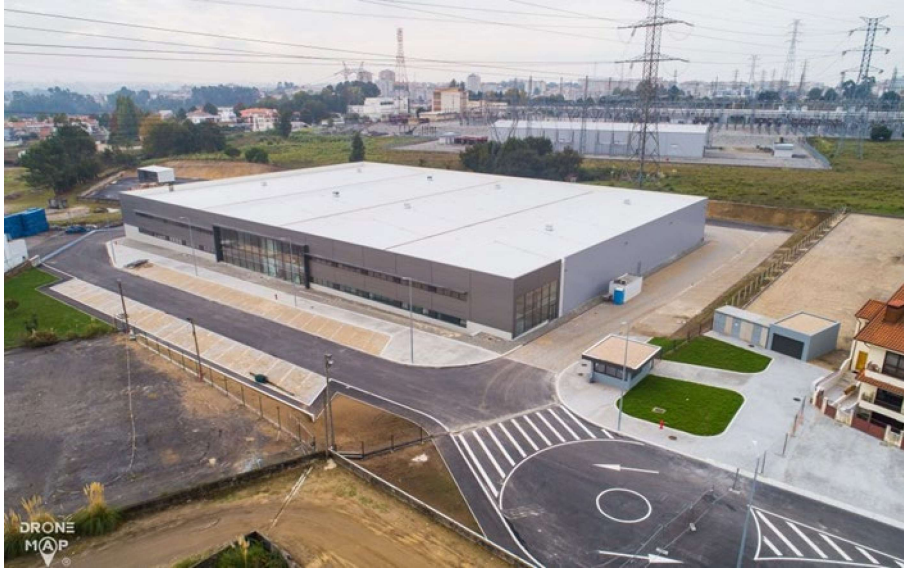
Figura 2 - Novas Instalações da Empresa FicoCables
