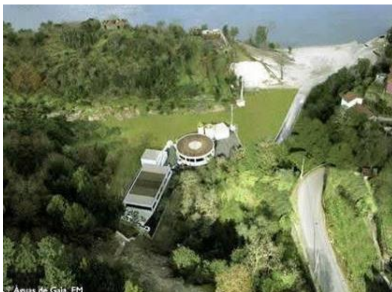
Figura 5.4 - ETAR de Crestuma (Águas de Gaia, 2016)
