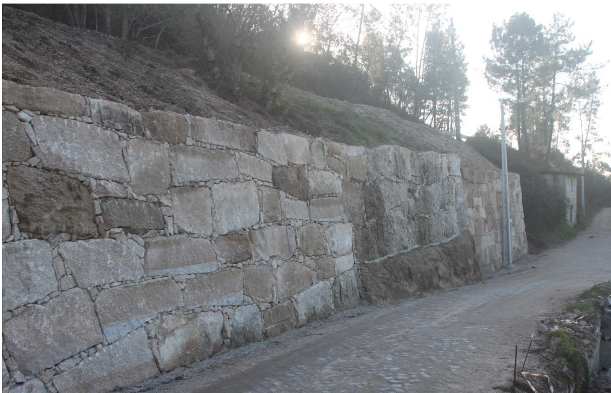
Figura 4-2 – Muro de contenção em alvenaria de pedra granítica. Rua de Gavim, Bustelo. (Caso 05.01)
