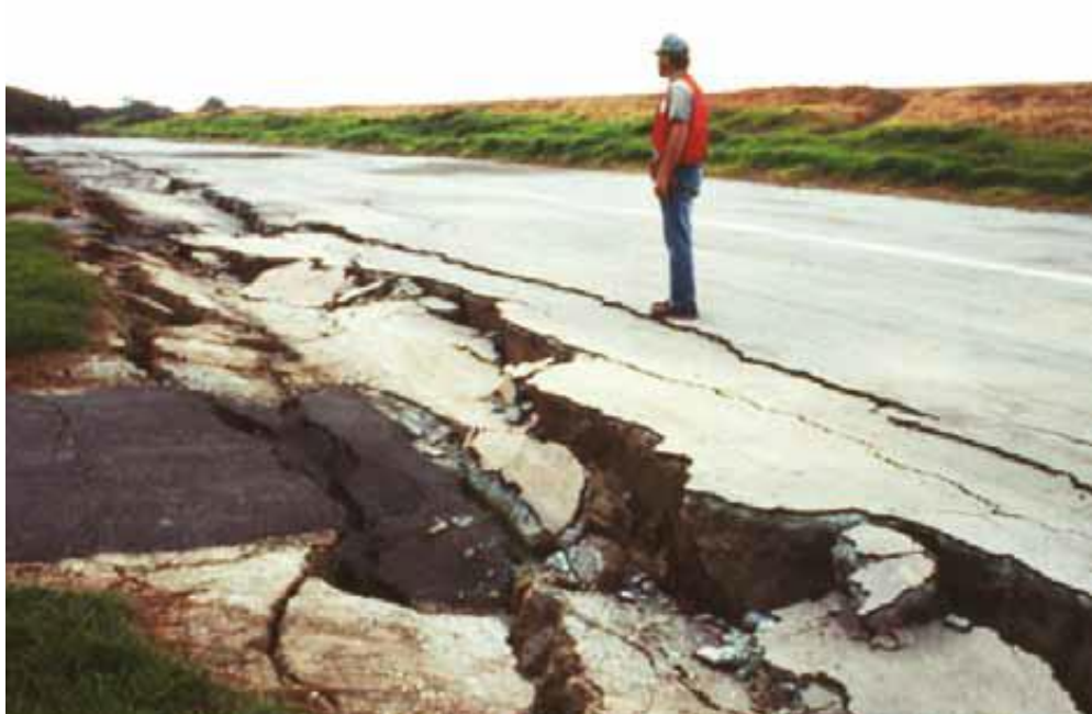
Figura 3-11 – Espalhamento lateral ocorrido em Loma Prieta, em 1989, na Califórnia, EUA. (Fotografia por Steve Ellen, U.S. Geological Survey). Em consequência de um terremoto. (Obtido a partir da referência 11)
