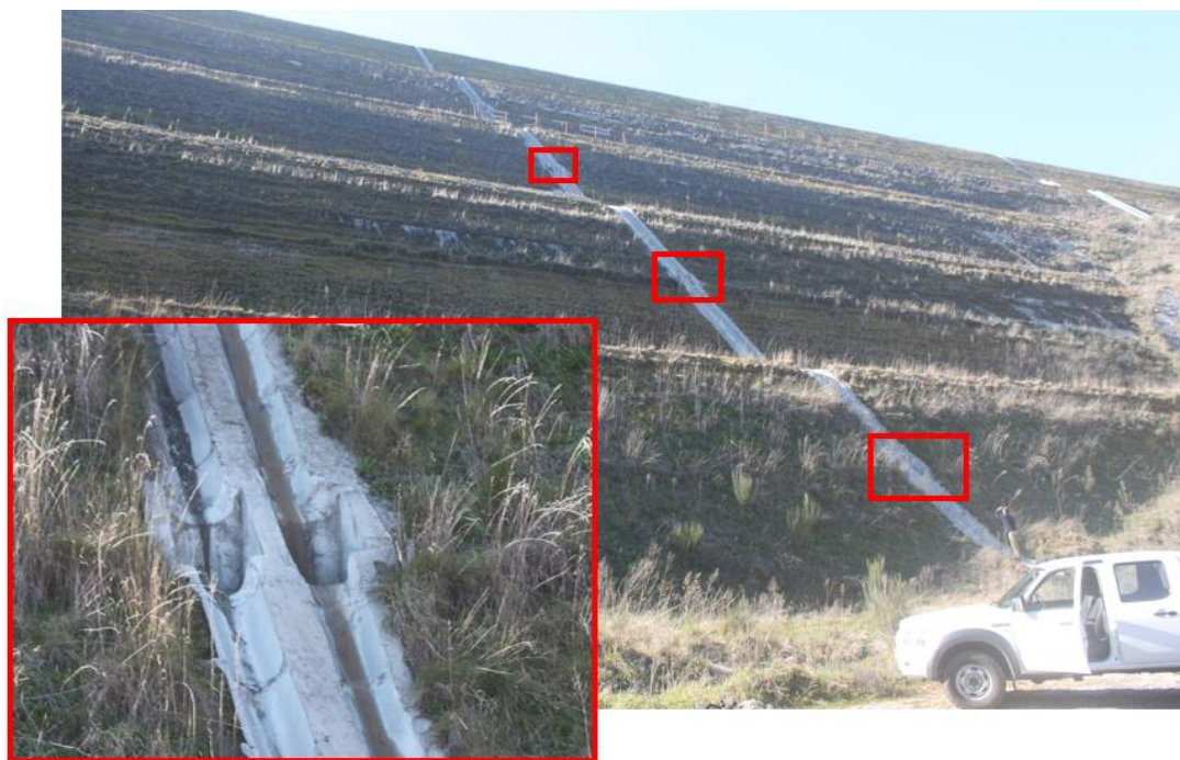
Figura 3-14 – Exemplo de um bom encaminhamento das águas pluviais, com dissipadores da velocidade das águas. Talude entre a A4 e a N15, Várzea – Amarante.
