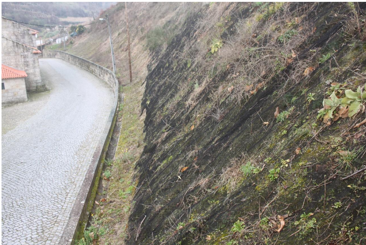
Figura 3-17 – Utilização de geocoleção para consolidação do talude. Rua do Mosteiro, Freixo de Baixo. (Caso 13.01)
