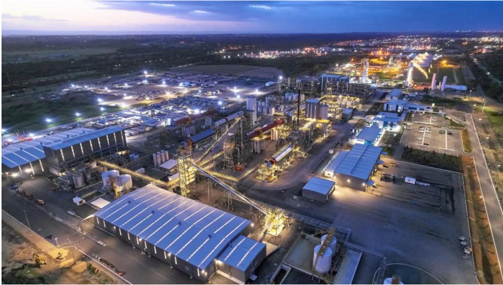
Figura 25 - Central de processamento de espodumena Tianqi em Kwinana, Austrália [69].
