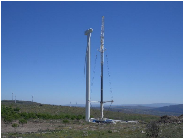
FIGURA 5.190 - MONTAGEM DAS PÁS, S. GENS (27.05.2015)
