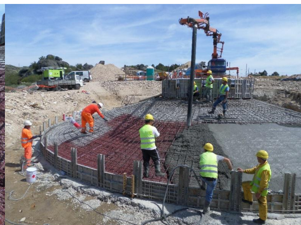
FIGURA 5.90 - BETONAGEM AG4, PISCO (21.04.2015)
