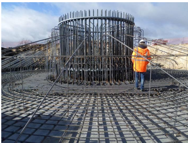
FIGURA 5.60 - MONTAGEM DE ARMADURAS AG24, S. GENS (24.02.2015)
