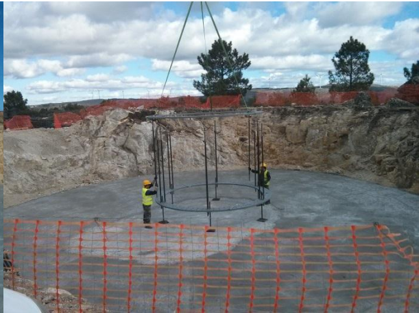
FIGURA 5.53 - MONTAGEM DO 2º ANEL DE ANCORAGEM AG21, S. GENS (03.03.2015)
