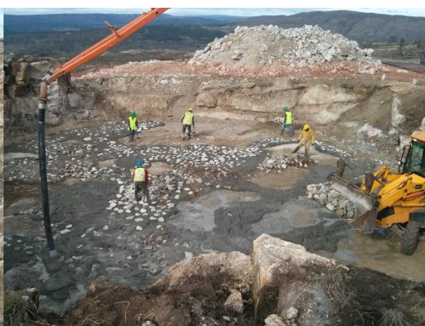
FIGURA 5.45 - COLOCAÇÃO DE BETÃO DE LIMPEZA CICLÓPICO AG22, S. GENS (16.02.2015)
