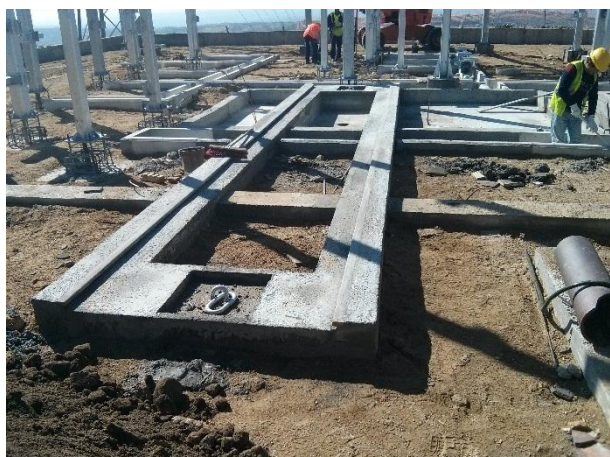
FIGURA 5.153 - CARRIS E MACIÇO DE TRACÇÃO PARA O POSICIONAMENTO DE TRANSFORMADORES SUBESTAÇÃO, PISCO (16.06.2015)
