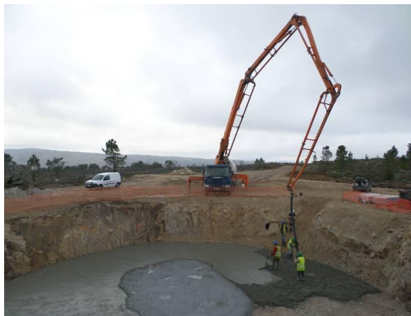
FIGURA 5.42 - COLOCAÇÃO DE BETÃO DE LIMPEZA AG21, S. GENS (02.03.2015)
