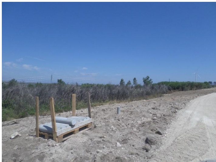
FIGURA 5.123 - SINALIZAÇÃO DA VALA DE CABOS, S. GENS (24.06.2015)
