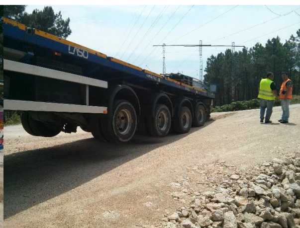
FIGURA 5.170 - PONTO A SER INTERVENCIONADO, PISCO (09.06.2015)
