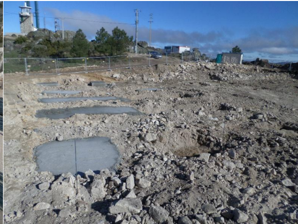
FIGURA 5.125 - COLOCAÇÃO DE BETÃO DE LIMPEZA NAS FUNDAÇÕES SUBESTAÇÃO, PISCO (27.03.2015)
