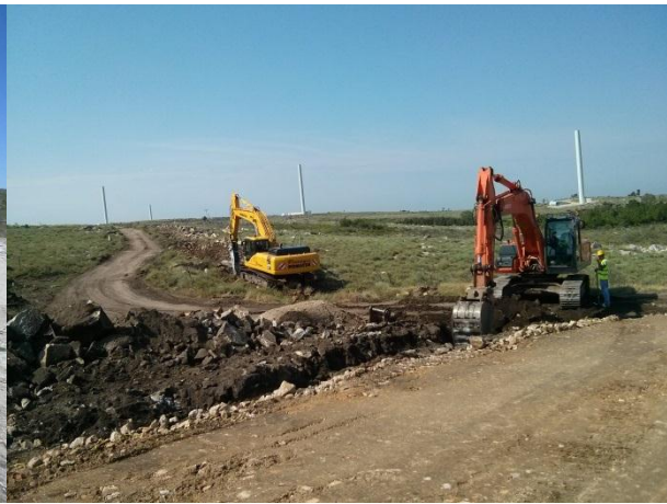
FIGURA 5.116 - ABERTURA DE VALAS PARA CABOS A1, S. GENS (09.06.2015)
