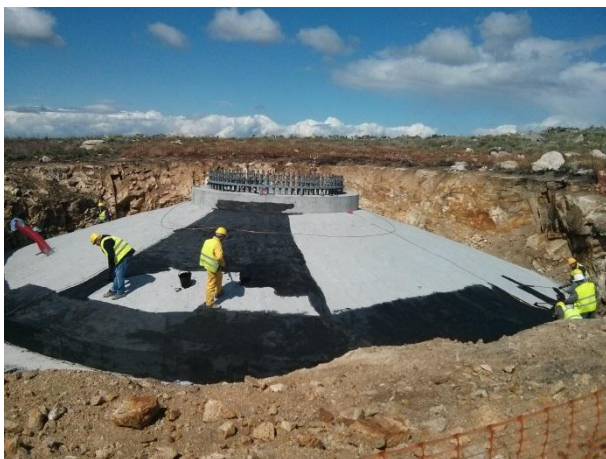
FIGURA 5.95 - IMPERMEABILIZAÇÃO DA FUNDAÇÃO AG14, S. GENS (21.04.2015)
