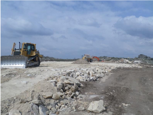
FIGURA 5.28 - EXECUÇÃO DE ATERRO P13, S. GENS (18.03.2015)
