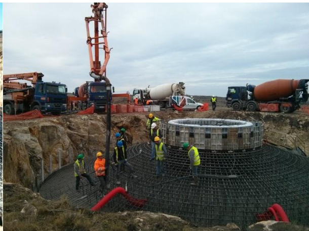
FIGURA 5.74 - BETONAGEM AG10, S. GENS (20.02.2015)
