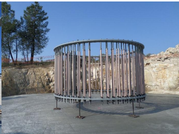
FIGURA 5.55 - SISTEMA DE FIXAÇÃO AG1, PISCO (18.03.2015)
