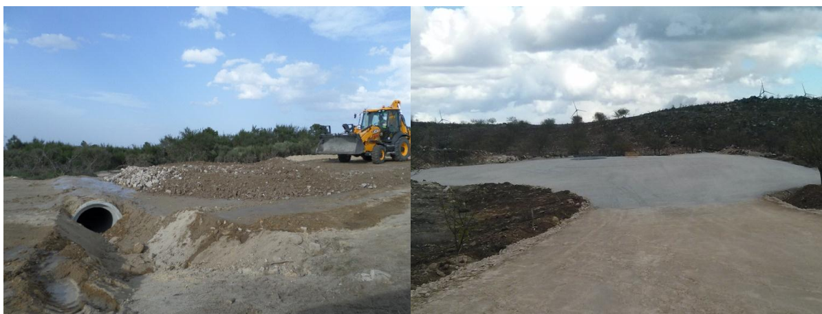
FIGURA 5.112 - EXECUÇÃO DE PH A1, S. GENS (13.04.2015)
