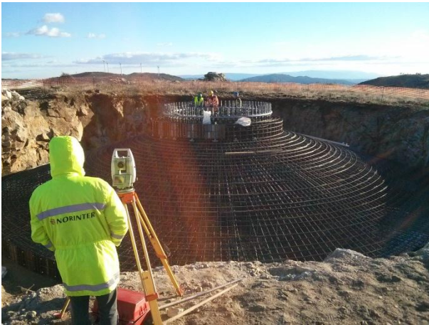
FIGURA 5.69 - NIVELAMENTO DO 3º ANEL DE ANCORAGEM AG9, S. GENS (17.02.2015)
