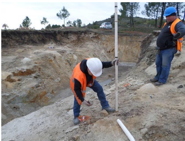
FIGURA 5.21 - CARREGAMENTO DE EXPLOSIVOS AG1, PISCO (12.02.2015)
