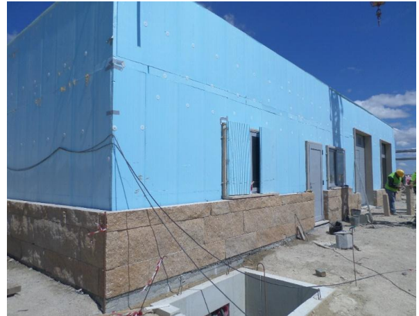
FIGURA 5.146 - EXECUÇÃO DA ALVENARIA EXTERIOR SUBESTAÇÃO. PISCO (24.07.2015)
