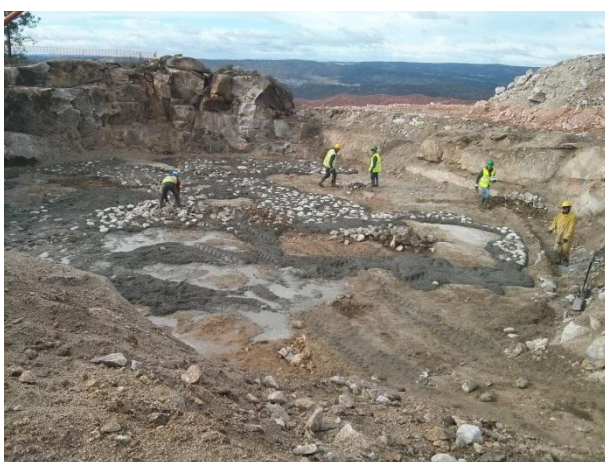
FIGURA 5.44 - COLOCAÇÃO DE BETÃO DE LIMPEZA CICLÓPICO AG22, S. GENS (16.02.2015)
