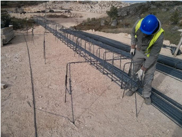
FIGURA 5.124 - MONTAGEM DE ARMADURAS DAS FUNDAÇÕES SUBESTAÇÃO, PISCO (20.03.2015)
