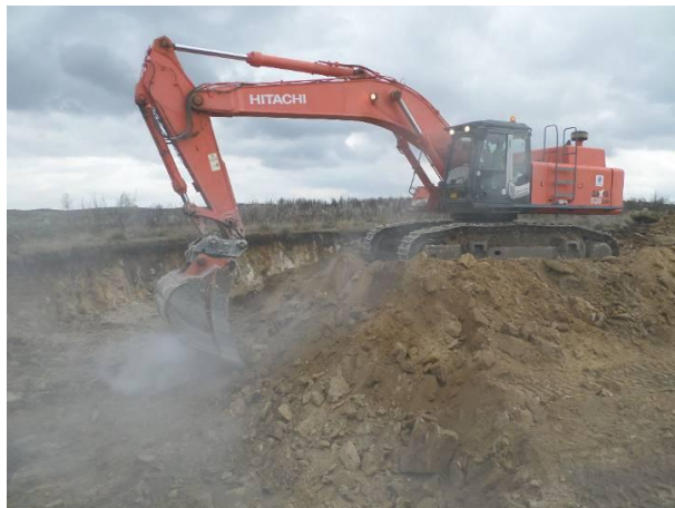
FIGURA 5.11 - ESCAVAÇÃO COM BALDE AG17, S. GENS (11.02.2015)
