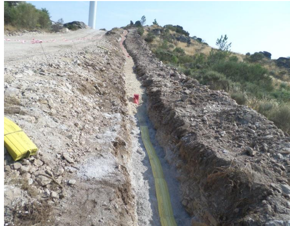
FIGURA 5.122 - ATERRO DA VALA DE CABOS A2, PISCO (14.07.2015)
