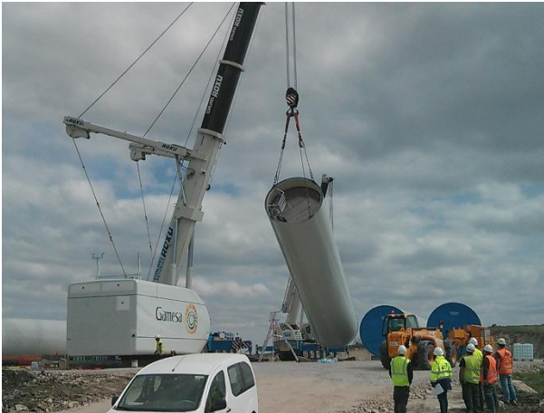
FIGURA 5.179 - LEVANTAMENTO DO 1º TRAMO DA TORRE DE SUSTENTAÇÃO, S. GENS (20.05.2015)
