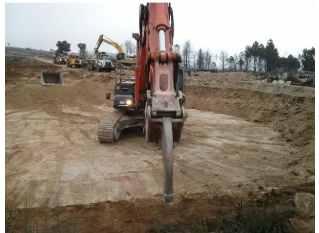
FIGURA 5.12 - ESCAVAÇÃO COM RIPER AG20, S. GENS (13.02.2015)
