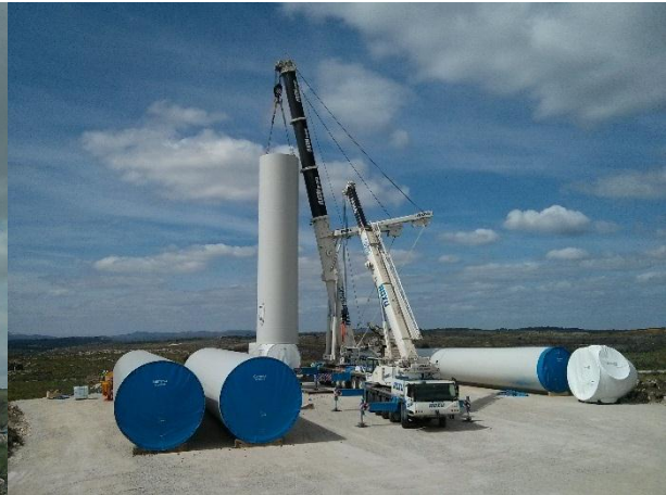
FIGURA 5.180 - POSICIONAMENTO DO 1º TRAMO DA TORRE DE SUSTENTAÇÃO, S. GENS (20.05.2015)
