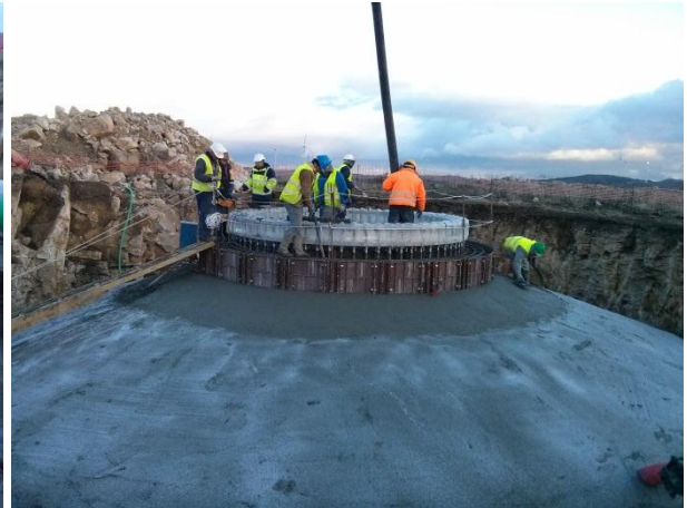
FIGURA 5.80 - BETONAGEM AG22, S. GENS (24.02.2015)
