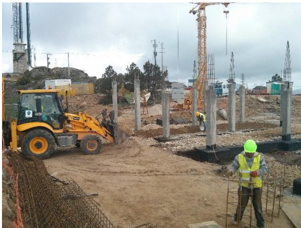
FIGURA 5.130 - ATERRO DAS FUNDAÇÕES SUBESTAÇÃO, PISCO (17.04.2015)
