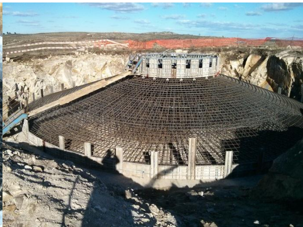
FIGURA 5.72 - COFRAGEM AG10, S. GENS (16.02.2015)
