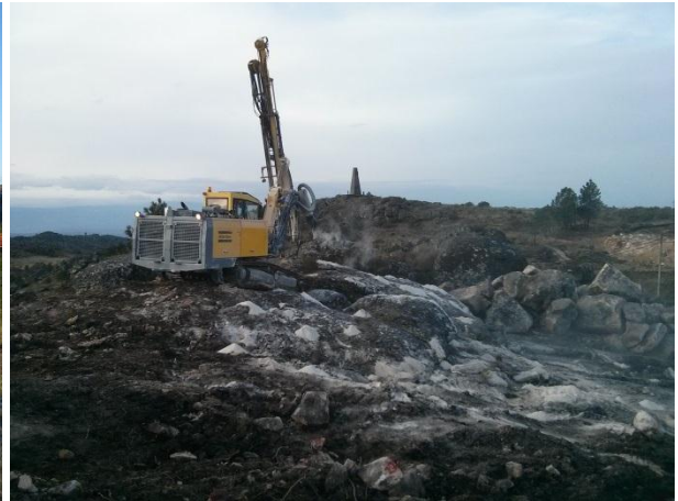
FIGURA 5.18 - FURAÇÃO PARA PEGA DE FOGO SUBESTAÇÃO, PISCO (11.02.2015)
