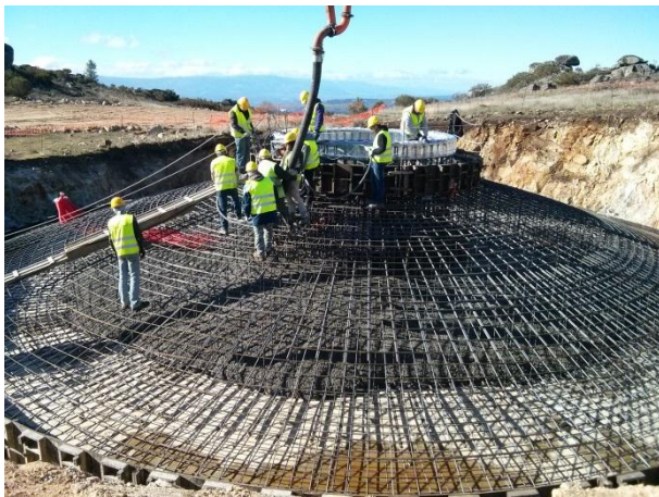
FIGURA 5.73 - BETONAGEM AG2, PISCO (25.03.2015)
