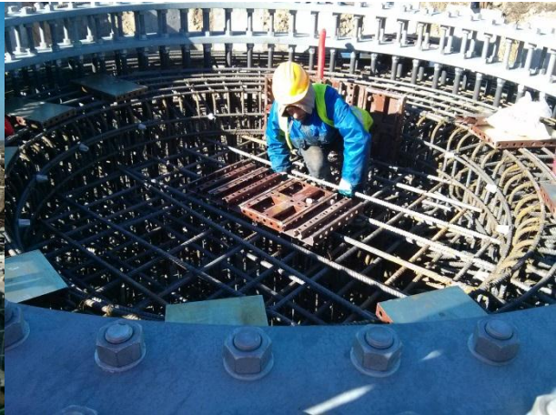
FIGURA 5.68 - MONTAGEM COFRAGEM AG9, S. GENS (17.02.2015)
