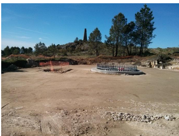
FIGURA 5.97 - ATERRO DA FUNDAÇÃO AG1, PISCO (23.04.2015)
