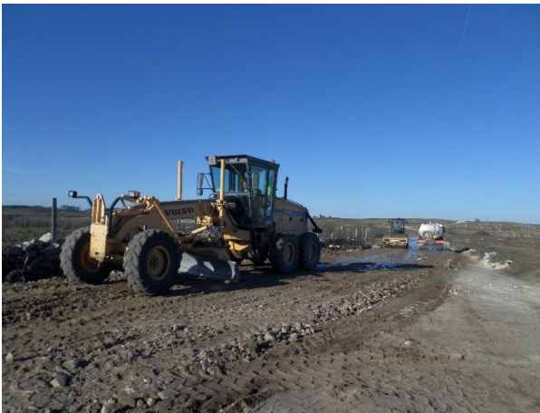
FIGURA 5.30 - EXECUÇÃO DE ATERRO A1, S. GENS (25.03.2015)
