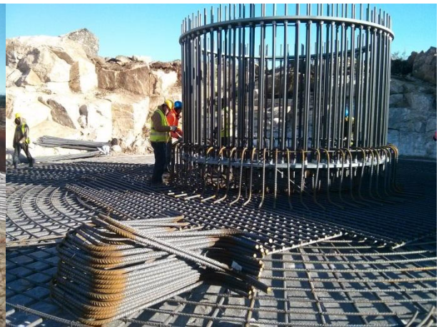
FIGURA 5.59 - MONTAGEM DE ARMADURAS AG22, S. GENS (18.02.2015)
