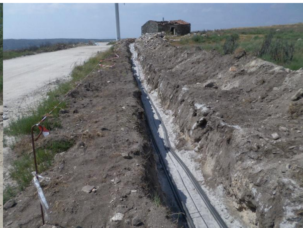
FIGURA 5.118 - COLOCAÇÃO DE CABOS EM VALA A6, S. GENS (23.06.2015)
