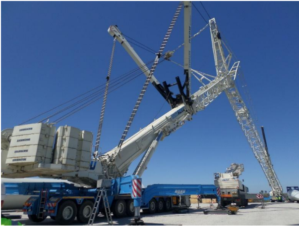
FIGURA 5.184 - MONTAGEM DA GRUA PRINCIPAL, S. GENS (15.05.2015)
