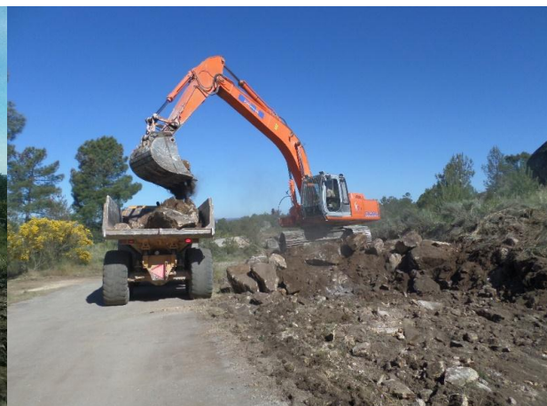
FIGURA 5.164 - ESCAVAÇÃO PARA ALARGAMENTO, PISCO (27.05.2015)
