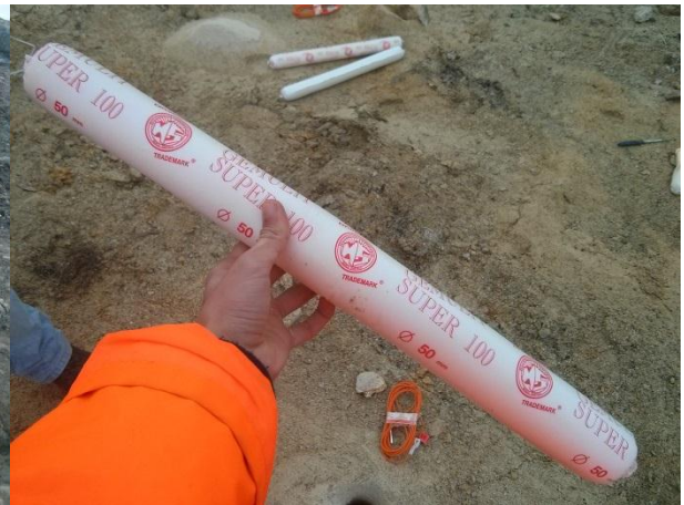
FIGURA 5.20 - CARGA EXPLOSIVA GEMULIT, PISCO (12.02.2015)
