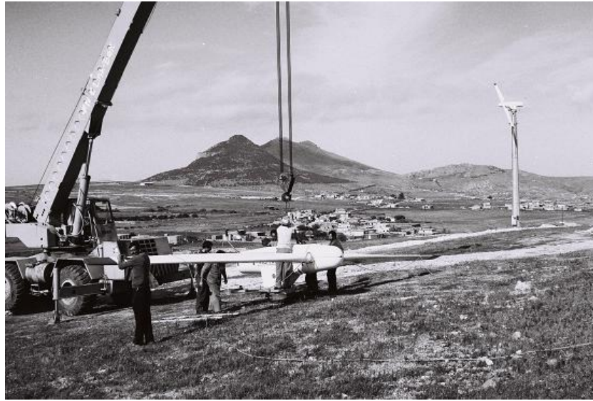
FIGURA 3.4 - CONSTRUÇÃO DO PARQUE EÓLICO DO CABEÇO DO CARVALHO, 1986 (FONTE: VISTADASERRA.BLOGSPOT.COM)
