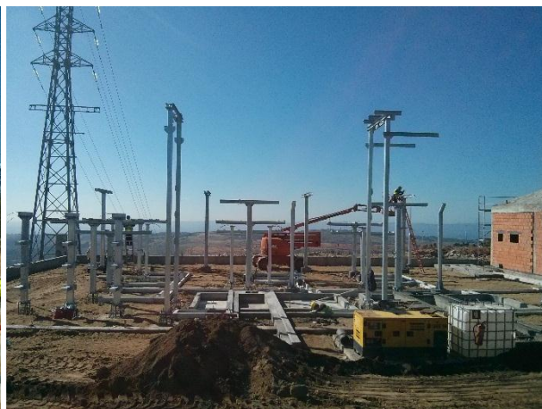
FIGURA 5.152 - MONTAGEM DE PERFIS METÁLICOS SUBESTAÇÃO, PISCO (16.06.2015)
