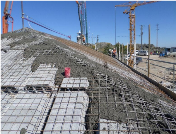
FIGURA 5.139 - BETONAGEM DAS LAJES DE COBERTURA SUBESTAÇÃO, PISCO (28.05.2015)
