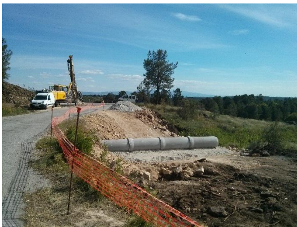
FIGURA 5.163 - EXECUÇÃO DE DRENAGEM TRANSVERSAL, PISCO (25.05.2015)
