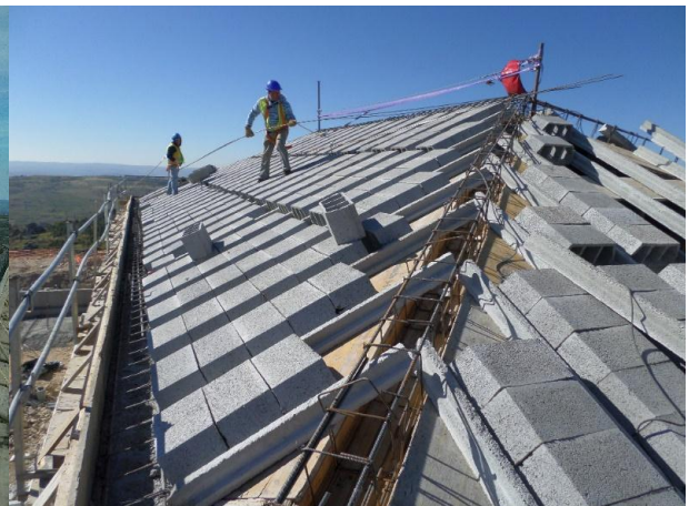
FIGURA 5.138 - MONTAGEM DAS LAJES DE COBERTURA SUBESTAÇÃO, PISCO (27.05.2015)
