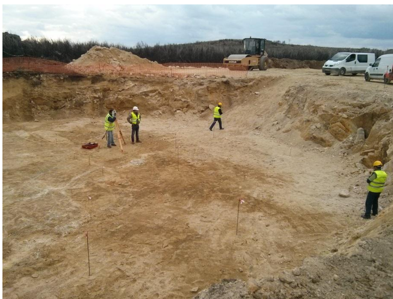
FIGURA 5.41 - FUNDO DE ESCAVAÇÃO E IMPLANTAÇÃO PARA BETÃO DE LIMPEZA DA FUNDAÇÃO AG23, S. GENS (11.02.2015)
