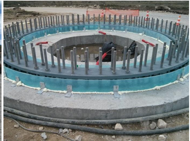
FIGURA 5.100 - COFRAGEM PARA APLICAÇÃO DO GROUT AG9, S. GENS (17.04.2015)
