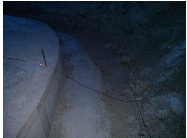
FIGURA 5.94 - EXECUÇÃO DA REDE DE TERRAS AG22, S. GENS (05.03.2015)
