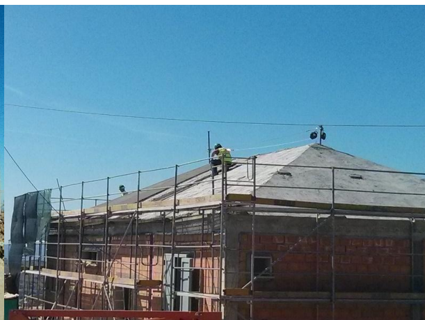
FIGURA 5.144 - REGULARIZAÇÃO DA COBERTURA SUBESTAÇÃO, PISCO (03.07.2015)
