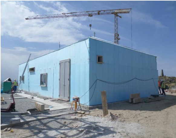
FIGURA 5.157 - EDIFÍCIO DE COMANDO SUBESTAÇÃO, PISCO (18.07.2015)
