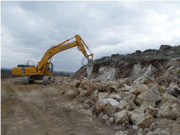
FIGURA 5.23 - TAQUEAMENTO DE PEDRA A6, S. GENS (06.02.2015)
