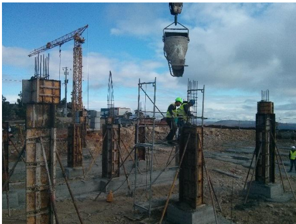
FIGURA 5.128 - COFRAGEM DOS PILARES SUBESTAÇÃO, PISCO (08.04.2015)
