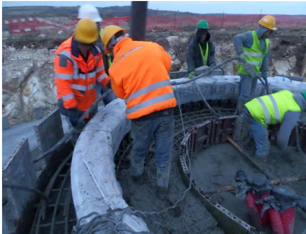
FIGURA 5.79 - BETONAGEM DO PEDESTAL AG10, S. GENS (20.02.2015)
