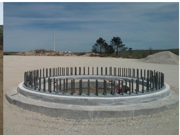
FIGURA 5.104 - ASPECTO FINAL DO PEDESTAL AG25, S. GENS (18.05.2015)
