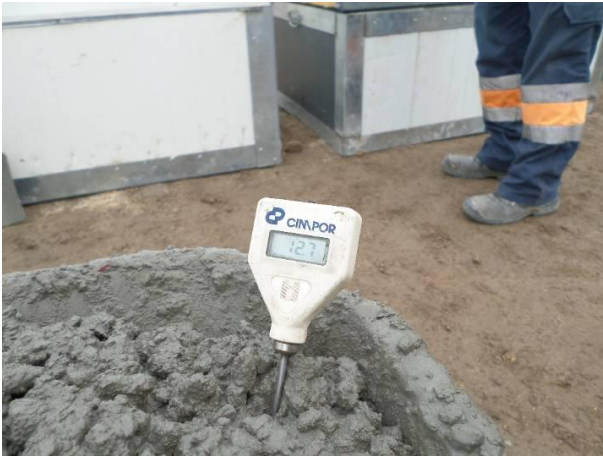
FIGURA 5.81 - VERIFICAÇÃO DA TEMPERATURA DO BETÃO AG10, S. GENS (20.02.2015)
