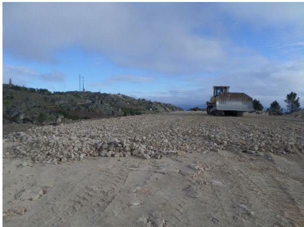
FIGURA 5.31 - EXECUÇÃO DE ATERRO P3, PISCO (19.03.2015)
