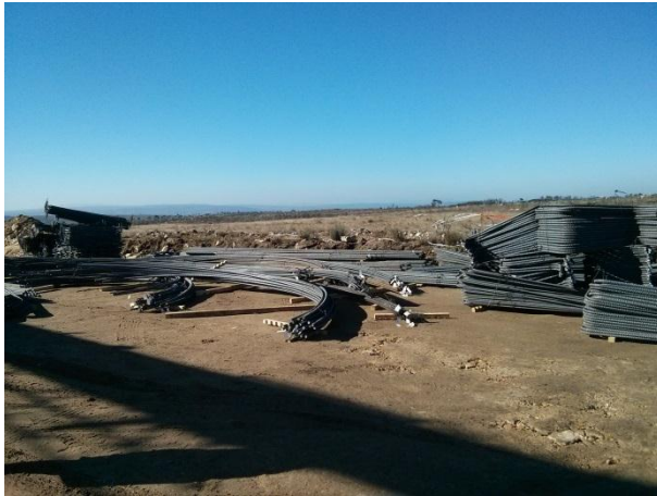
FIGURA 5.56 - ARMADURAS PARA MONTAGEM AG10, S. GENS (09.02.2015)
