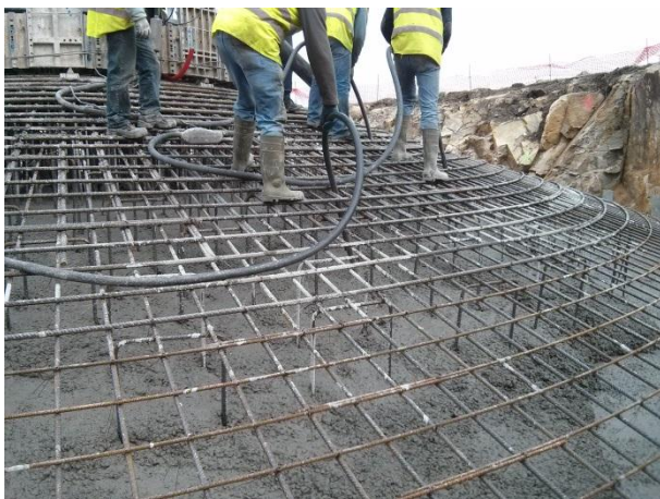
FIGURA 5.75 - BETONAGEM AG10, S. GENS (20.02.2015)
