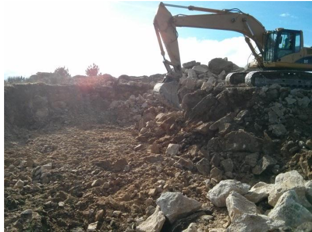
FIGURA 5.16 - ESCAVAÇÃO COM BALDE AG5, PISCO (27.02.2015)
