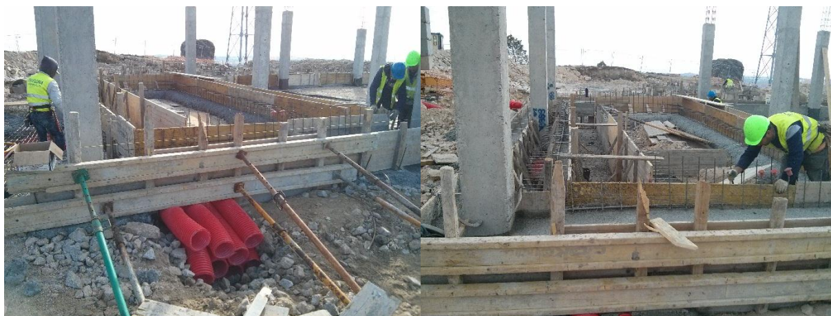
FIGURA 5.132 - COFRAGEM DA VALA DE ENTRADA DE CABOS SUBESTAÇÃO, PISCO (23.04.2015)
