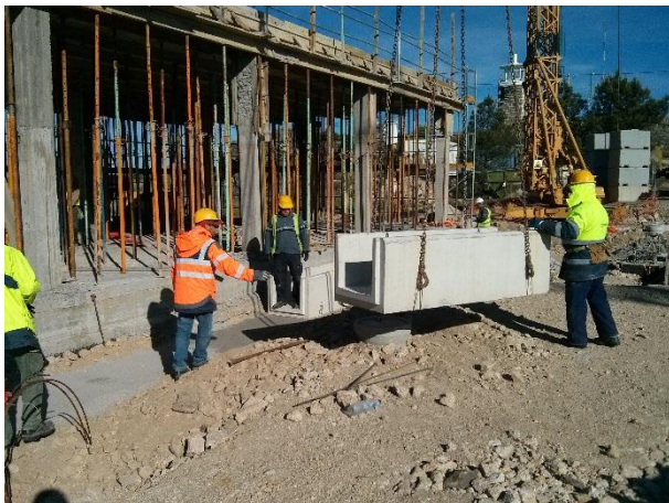
FIGURA 5.149 - COLOCAÇÃO DE CALEIRAS PARA CABOS SUBESTAÇÃO, PISCO (21.05.2015)
