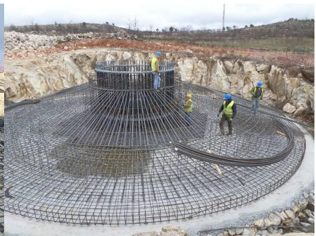
FIGURA 5.61 - MONTAGEM DE ARMADURAS AG24, S. GENS (26.02.2015)
