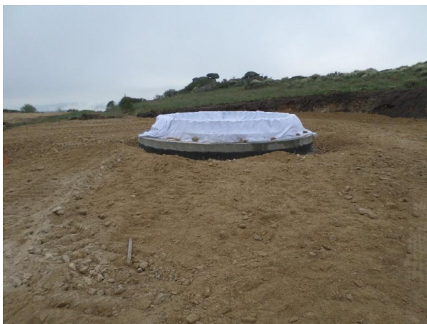
FIGURA 5.103 - PROTECÇÃO DO PEDESTAL PARA CURA AG2, PISCO (28.04.2015)
