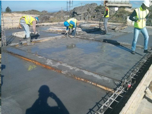
FIGURA 5.135 - BETONAGEM DA LAJE DE ESTEIRA SUBESTAÇÃO, PISCO (19.05.2015)
