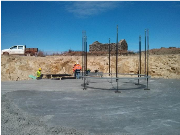
FIGURA 5.52 - MONTAGEM DE PERNOS NO SISTEMA DE FIXAÇÃO AG23, S. GENS (27.02.2015)
