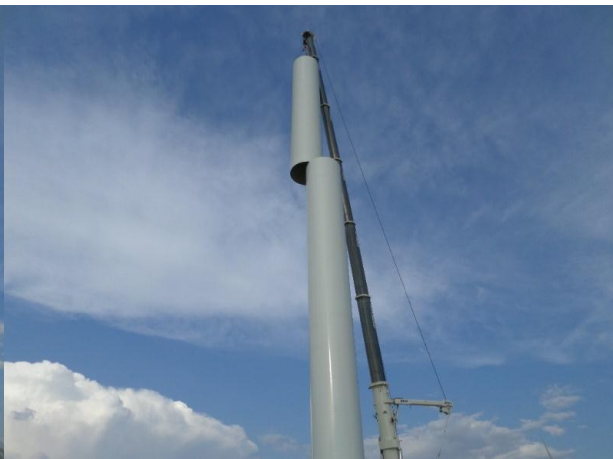
FIGURA 5.182 - MONTAGEM DO 3º TRAMO DA TORRE DE SUSTENTAÇÃO, S GENS (04.06.2015)
