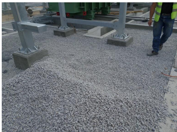
FIGURA 5.155 - ESPALHAMENTO DE GRAVILHA SUBESTAÇÃO, PISCO (25.06.2015)
