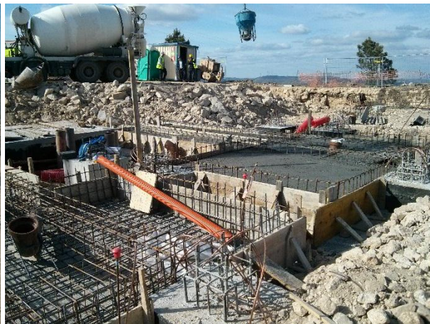
FIGURA 5.148 - BETONAGEM DE MACIÇOS NO P. EXTERIOR SUBESTAÇÃO, PISCO (20.05.2015)
