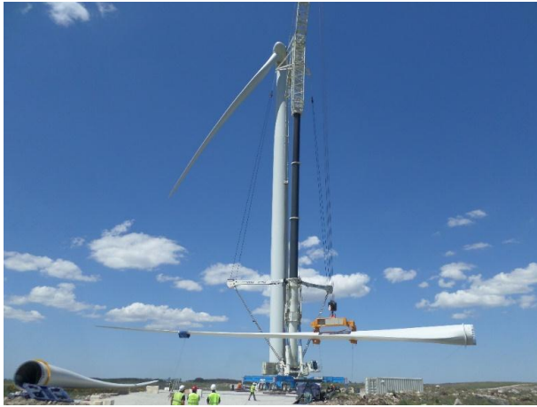
FIGURA 5.188 - MONTAGEM DAS PÁS, S. GENS (02.06.2015)
