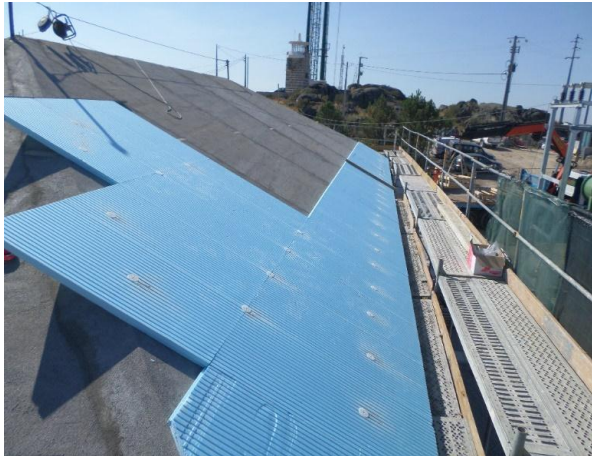
FIGURA 5.145 - COLOCAÇÃO DE ISOLAMENTO SUBESTAÇÃO, PISCO (08.07.2015)
