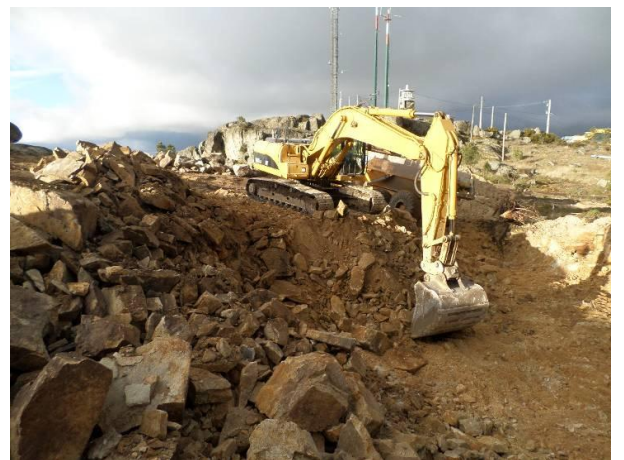
FIGURA 5.14 - ESCAVAÇÃO COM BALDE AG1, PISCO (16.02.2015)
