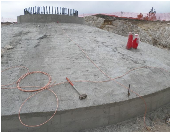
FIGURA 5.93 - EXECUÇÃO DA REDE DE TERRAS AG19, S. GENS (17.03.2015)
