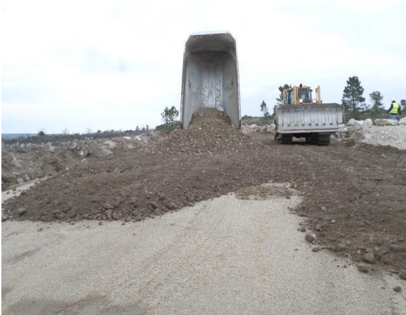
FIGURA 5.34 - EXECUÇÃO DE ATERRO EXPERIMENTAL, S. GENS (17.03.2015)
