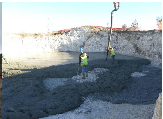
FIGURA 5.43 - COLOCAÇÃO DE BETÃO DE LIMPEZA AG19, S. GENS (04.03.2015)
