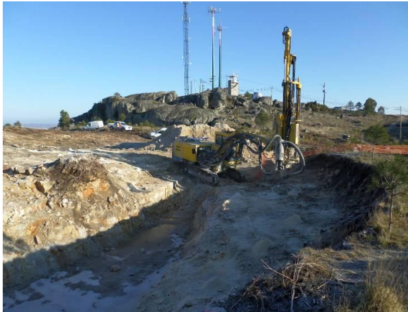
FIGURA 5.17 - FURAÇÃO PARA PEGA DE FOGO AG1, PISCO (10.02.2015)
