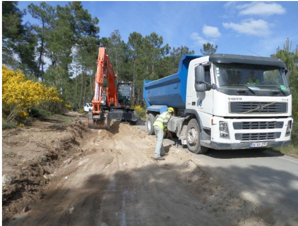
FIGURA 5.159 - TRABALHOS DE ALARGAMENTO NA VARIANTE, PISCO (20.05.2015)
