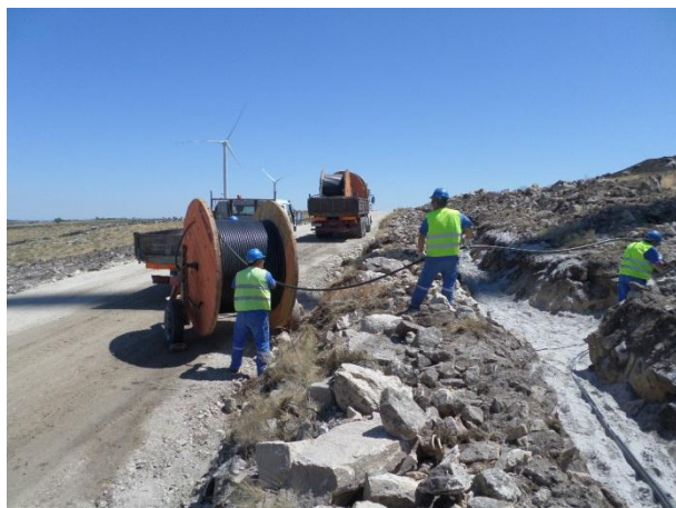
FIGURA 5.119 - COLOCAÇÃO DE CABOS EM VALA A10, S. GENS (09.07.2015)
