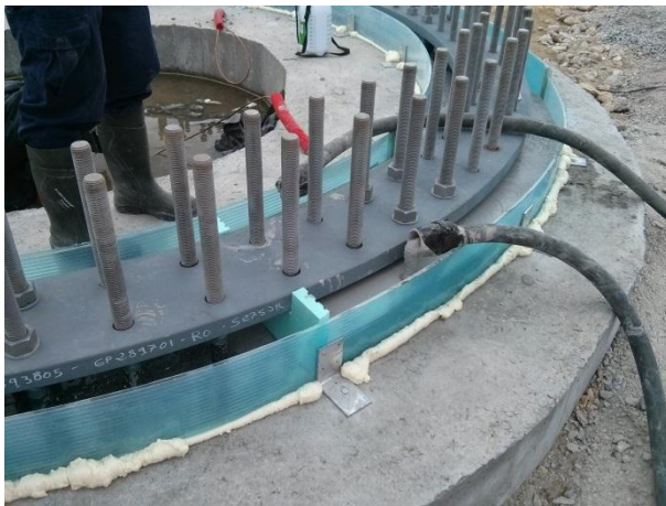
FIGURA 5.101 - BETONAGEM COM GROUT AG9, S. GENS (17.04.2015)
