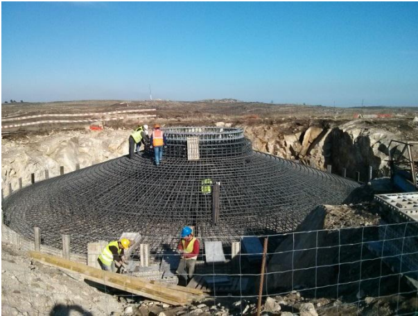
FIGURA 5.67 - MONTAGEM DA COFRAGEM AG10, S. GENS (10.02.2015)
