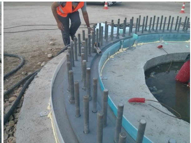
FIGURA 5.102 - BETONAGEM COM GROUT AG9, S. GENS (17.04.2015)
