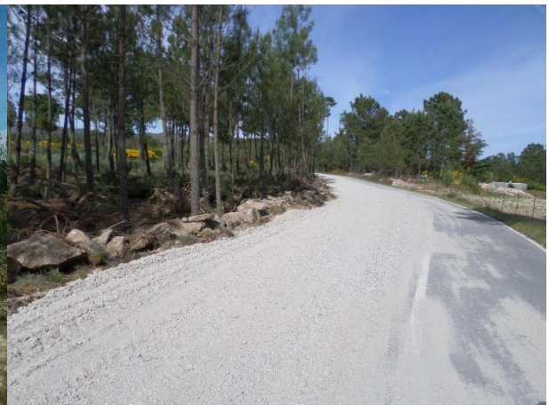
FIGURA 5.162 - PAVIMENTAÇÃO DO ALARGAMENTO COM ABGE, PISCO (22.05.2015)
