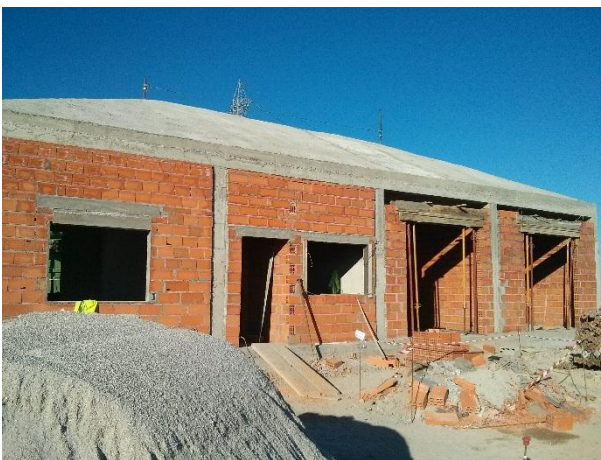
FIGURA 5.143 - EXECUÇÃO DE PAREDES EXTERIORES SUBESTAÇÃO, PISCO (18.06.2015)
