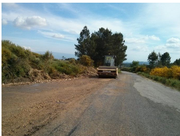
FIGURA 5.165 - COMPACTAÇÃO DO ATERRO, PISCO (01.06.2015)
