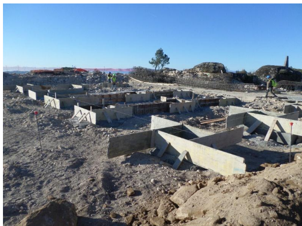
FIGURA 5.126 - COFRAGEM DE FUNDAÇÕES, PISCO (01.04.2015)
