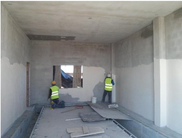
FIGURA 5.141 - ACABAMENTO DE PAREDES SUBESTAÇÃO, PISCO (16.06.2015)
