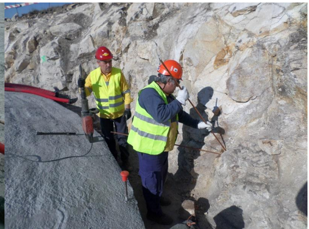
FIGURA 5.92 - EXECUÇÃO DA REDE DE TERRAS AG10, S. GENS (16.03.2015)
