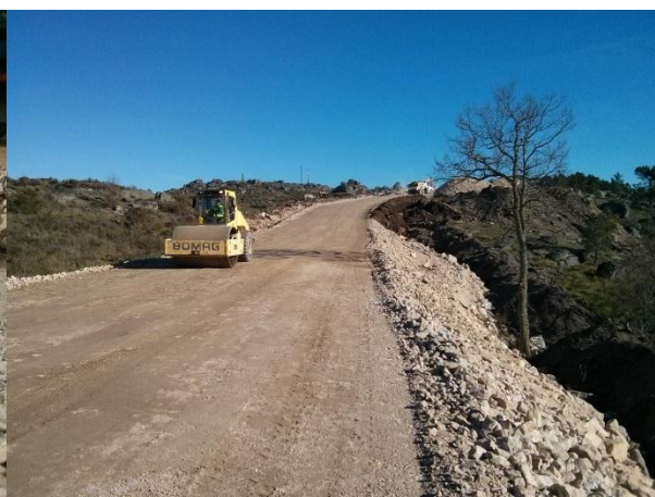
FIGURA 5.33 - COMPACTAÇÃO DE ATERRO A2, PISCO (01.04.2015)
