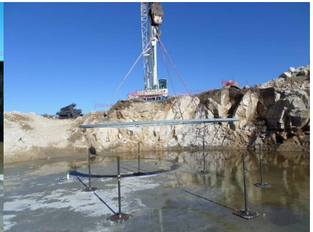
FIGURA 5.49 - MONTAGEM DO 1º ANEL DE ANCORAGEM AG9, S. GENS (09.02.2015)
