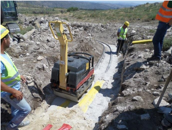
FIGURA 5.121 - ATERRO DA VALA DE CABOS AG18, S. GENS (06.07.2015)
