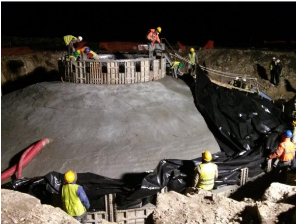
FIGURA 5.83 - COLOCAÇÃO DE COBERTURA AG10, S. GENS (20.02.2015)
