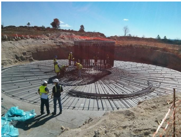
FIGURA 5.58 - MONTAGEM DE ARMADURAS AG20, S. GENS (27.03.2015)
