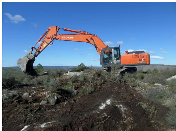
FIGURA 5.7 - DESMATAÇÃO E DECAPAGEM TORRE MET., S. GENS (17.02.2015)
