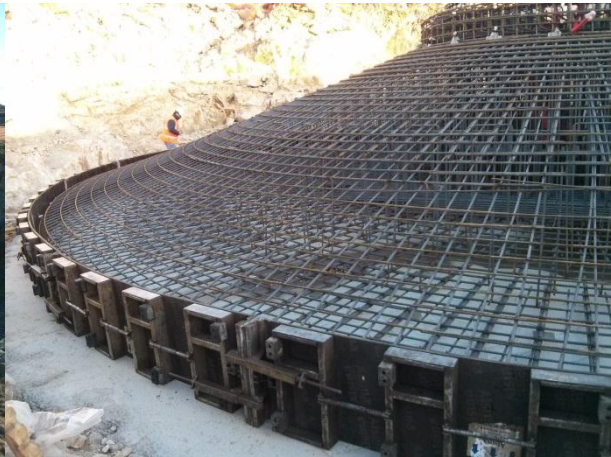
FIGURA 5.70 - MONTAGEM DA COFRAGEM AG25, S. GENS (25.02.2015)
