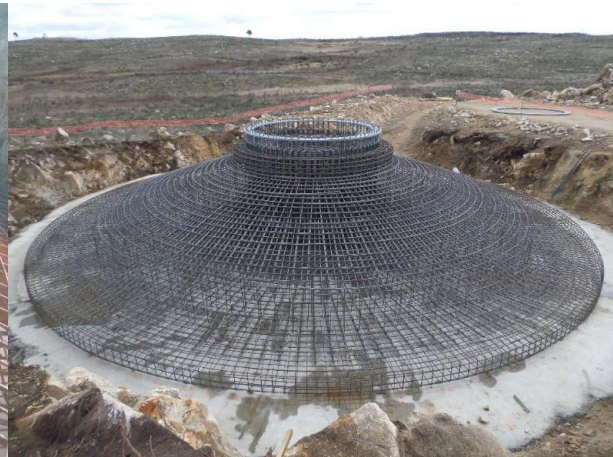
FIGURA 5.65 - ASPECTO FINAL DA ARMADURA DE FUNDAÇÃO AG16, S. GENS (24.03.2015)
