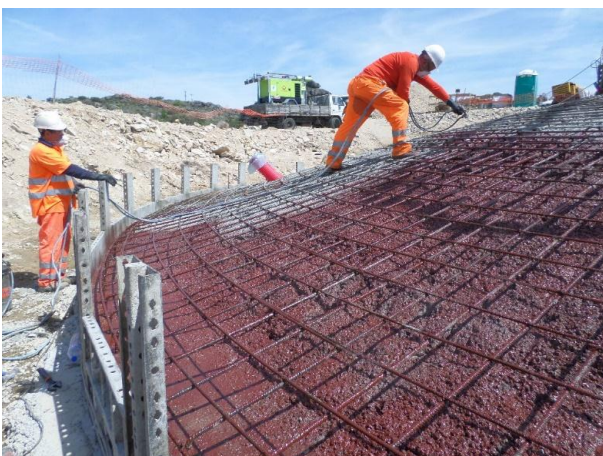
FIGURA 5.89 - APLICAÇÃO DE RESINA EPÓXI PARA LIGAÇÃO DE BETÕES AG4, PISCO (21.04.2015)
