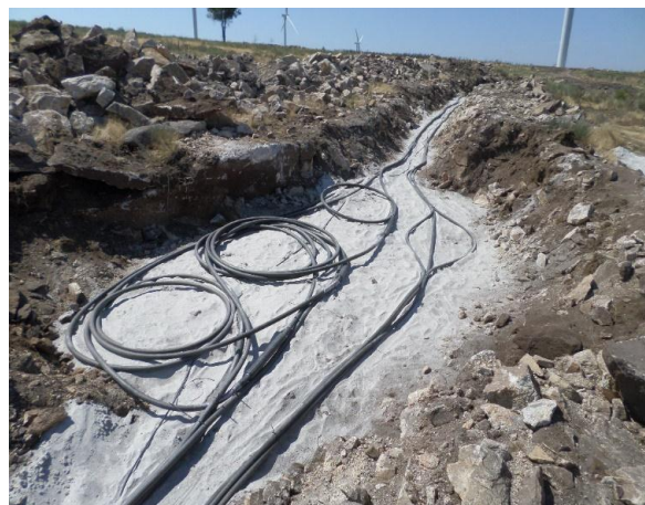
FIGURA 5.120 - UNIÃO DE CABOS MT, S. GENS (14.07.2015)
