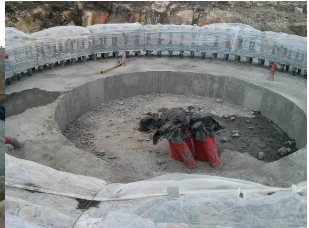
FIGURA 5.86 - ASPECTO FINAL DE UMA FUNDAÇÃO - PEDESTAL, S. GENS (20.03.2015)
