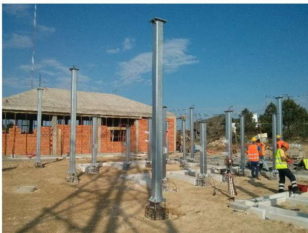
FIGURA 5.151 - MONTAGEM DE PERFIS METÁLICOS SUBESTAÇÃO, PISCO (09.06.2015)
