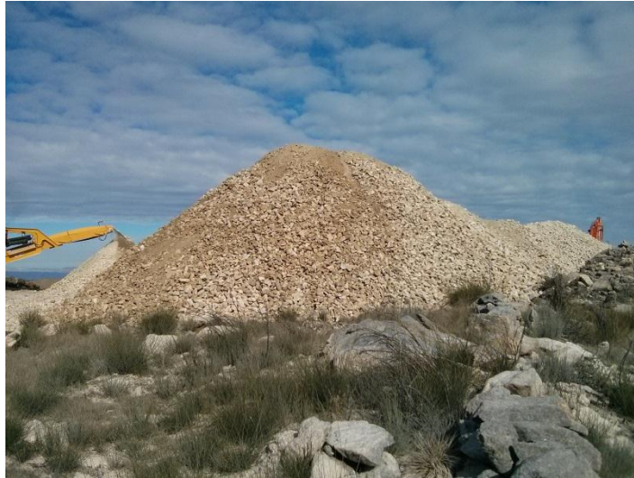
FIGURA 5.27 - LOCAL DE DEPÓSITO, S. GENS (27.02.2015)
