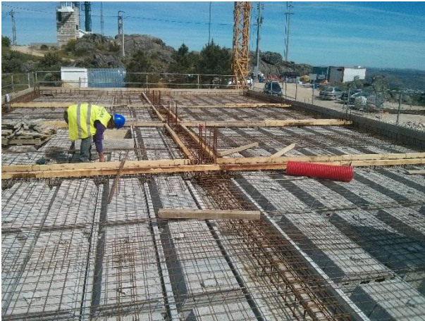
FIGURA 5.134 - COFRAGEM DA LAJE DE ESTEIRA SUBESTAÇÃO, PISCO (18.05.2015)
