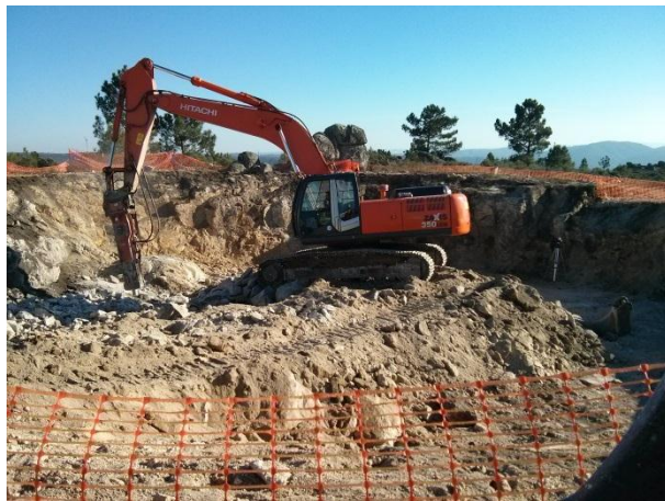
FIGURA 5.9 - ESCAVAÇÃO COM MARTELO AG21, S. GENS (09.02.2015)
