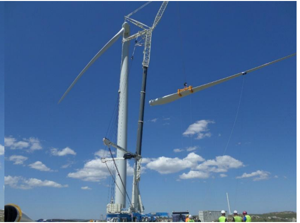
FIGURA 5.189 - MONTAGEM DAS PÁS, S. GENS (02.06.2015)
