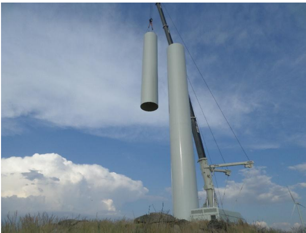
FIGURA 5.181 - LEVANTAMENTO DO 3º TRAMO DA TORRE DE SUSTENTAÇÃO, S. GENS (04.06.2015)
