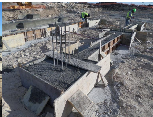
FIGURA 5.127 - BETONAGEM DE FUNDAÇÕES SUBESTAÇÃO, PISCO (02.04.2015)
