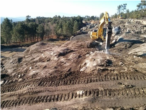
FIGURA 5.15 - ESCAVAÇÃO COM MARTELO P6, PISCO (19.02.2015)
