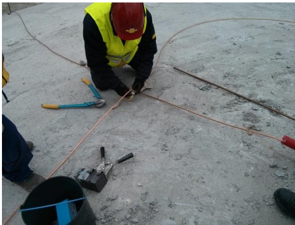
FIGURA 5.91 - EXECUÇÃO DA REDE DE TERRAS AG19, S. GENS (17.03.2015)
