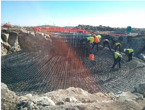
FIGURA 5.62 - MONTAGEM DE ARMADURAS AG10, S. GENS (09.02.2015)
