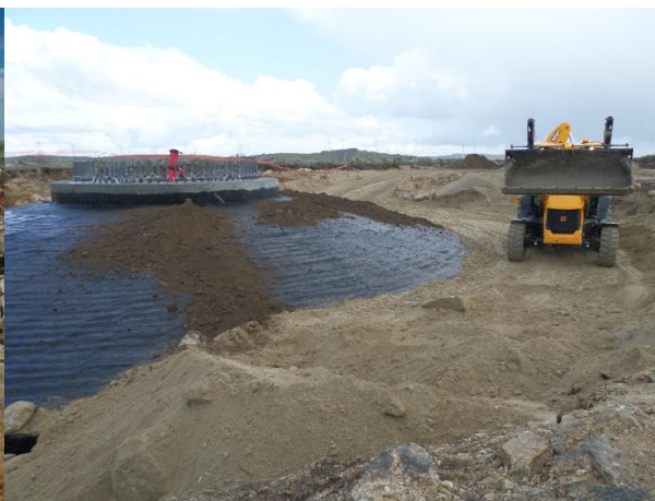
FIGURA 5.96 - ATERRO DA FUNDAÇÃO AG18, S. GENS (27.04.2015)
