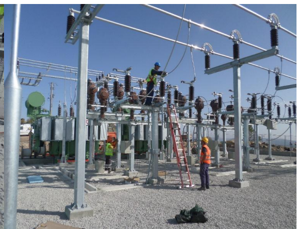
FIGURA 5.156 - EXECUÇÃO DE LIGAÇÕES SUBESTAÇÃO, PISCO (16.07.2015)
