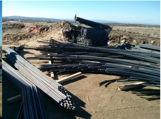
FIGURA 5.57 - ARMADURAS PARA MONTAGEM AG10, S. GENS (09.02.2015)
