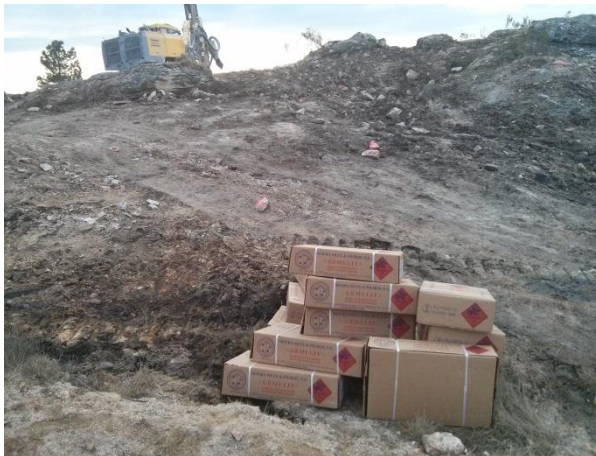
FIGURA 5.19 - CARREGAMENTO DE EXPLOSIVOS SUBESTAÇÃO, PISCO (12.02.2015)
