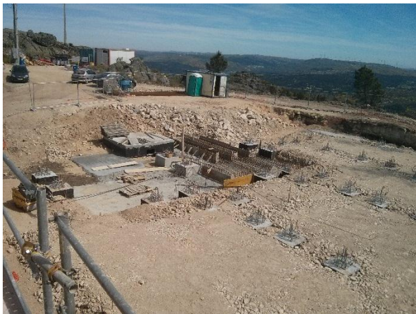
FIGURA 5.147 - EXECUÇÃO DE MACIÇOS NO P. EXTERIOR SUBESTAÇÃO, PISCO (18.05.2015)
