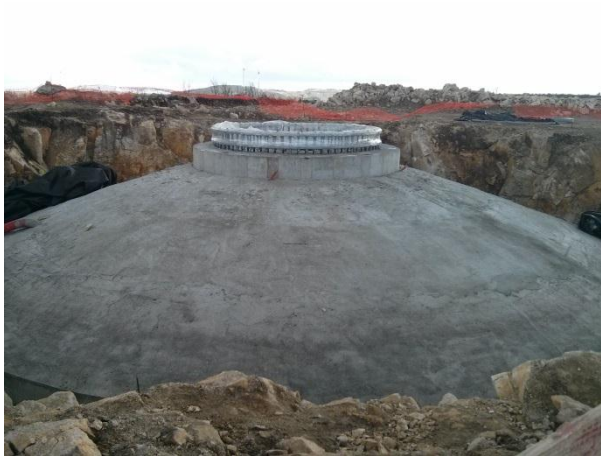
FIGURA 5.85 - ASPECTO FINAL DE UMA FUNDAÇÃO, S. GENS (23.02.2015)
