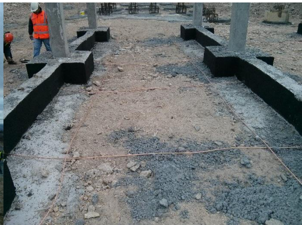
FIGURA 5.129 – MONTAGEM DA REDE DE TERRAS E IMPERMEABILIZAÇÃO DAS FUNDAÇÕES, PISCO (15.04.2015)
