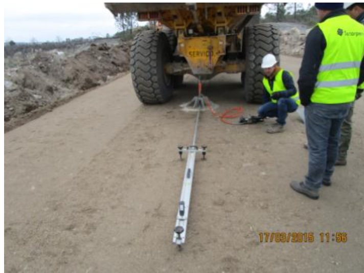
FIGURA 5.38 - ENSAIO DE CARGA EM PLACA NO ATERRO EXPERIMENTAL, S. GENS (17.03.2015)
