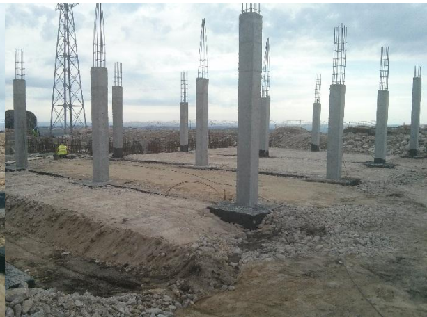
FIGURA 5.131 - FUNDAÇÕES ATERRADAS SUBESTAÇÃO, PISCO (21.04.2015)
