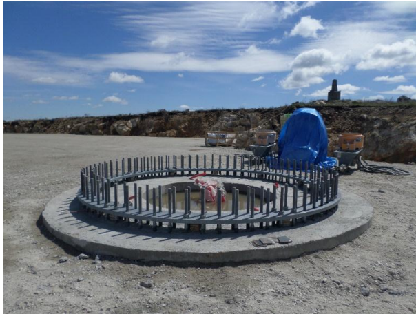
FIGURA 5.99 - EXECUÇÃO DO NIVELAMENTO NO PEDESTAL AG25, S. GENS (29.04.2015)
