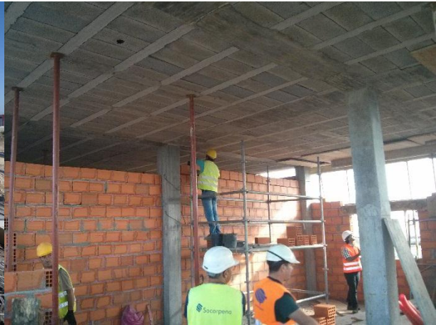
FIGURA 5.140 - EXECUÇÃO DAS PAREDES INTERIORES SUBESTAÇÃO, PISCO (09.06.2015)
