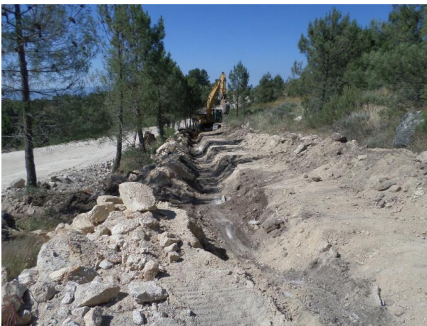
FIGURA 5.117 - ABERTURA DE VALAS PARA CABOS A2, PISCO (19.06.2015)
