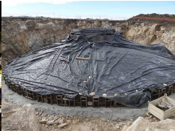
FIGURA 5.84 - PROTECÇÃO DA FUNDAÇÃO AG25, S. GENS (27.02.2015)
