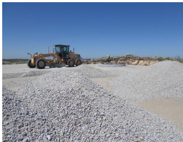
FIGURA 5.109 - PAVIMENTAÇÃO COM ABGE P12, S. GENS (22.05.2015)
