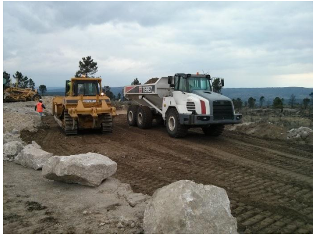
FIGURA 5.35 - EXECUÇÃO DE ATERRO EXPERIMENTAL, S. GENS (17.03.2015)
