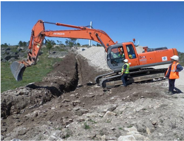
FIGURA 5.115 - ABERTURA DE VALAS PARA CABOS A6, S. GENS (26.05.2015)
