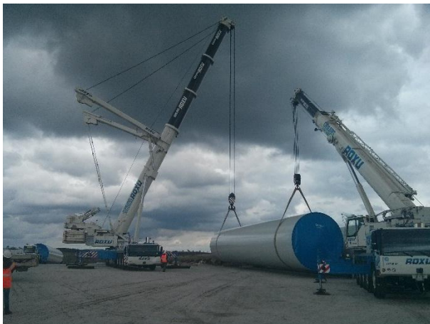
FIGURA 5.173 - DESCARGA DE UM TRAMO DA TORRE DE SUSTENTAÇÃO, S. GENS (28.04.2015)
