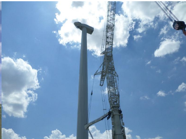
FIGURA 5.187 - MONTAGEM DO ROTOR, S. GENS (29.05.2015)
