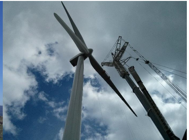
FIGURA 5.191 - MONTAGEM DAS PÁS, S. GENS (20.05.2015)
