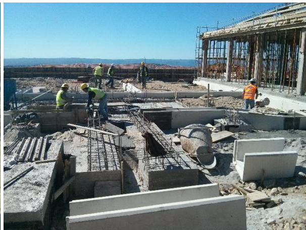
FIGURA 5.150 - TRABALHOS NO PARQUE EXTERIOR SUBESTAÇÃO, PISCO (26.05.2015)
