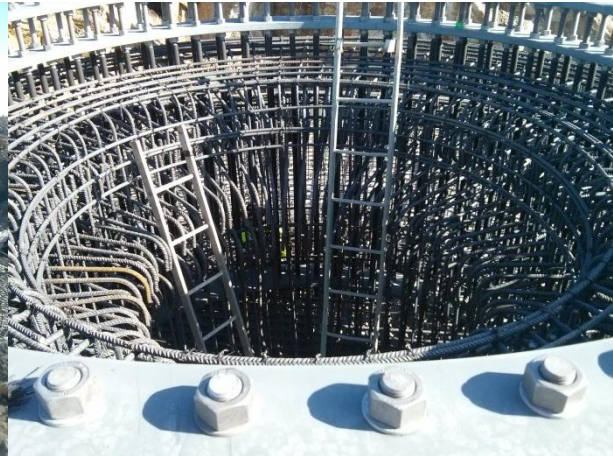
FIGURA 5.63 - MONTAGEM DE ARMADURAS AG10, S. GENS (10.02.2015)
