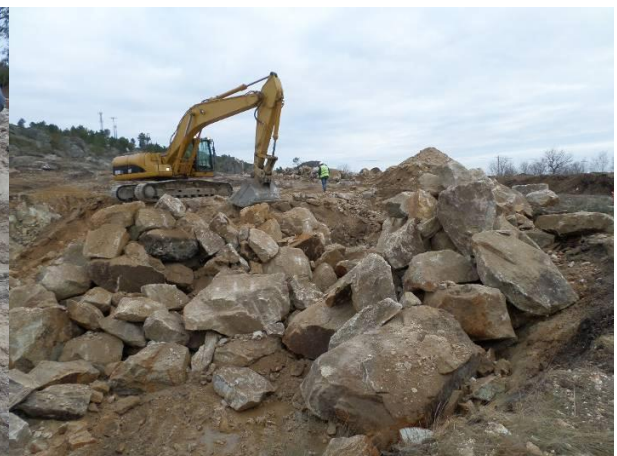
FIGURA 5.22 - MACIÇO DESMONTADO AG2, PISCO (12.02.2015)
