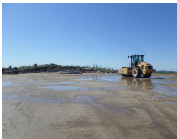
FIGURA 5.107 - COMPACTAÇÃO DO ATERRO P12, S. GENS (19.05.2015)
