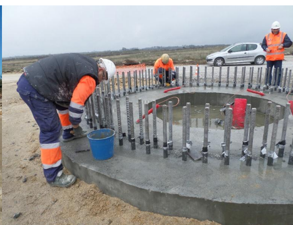
FIGURA 5.98 - EXECUÇÃO DO NIVELAMENTO NO PEDESTAL AG9, S. GENS (16.04.2015)
