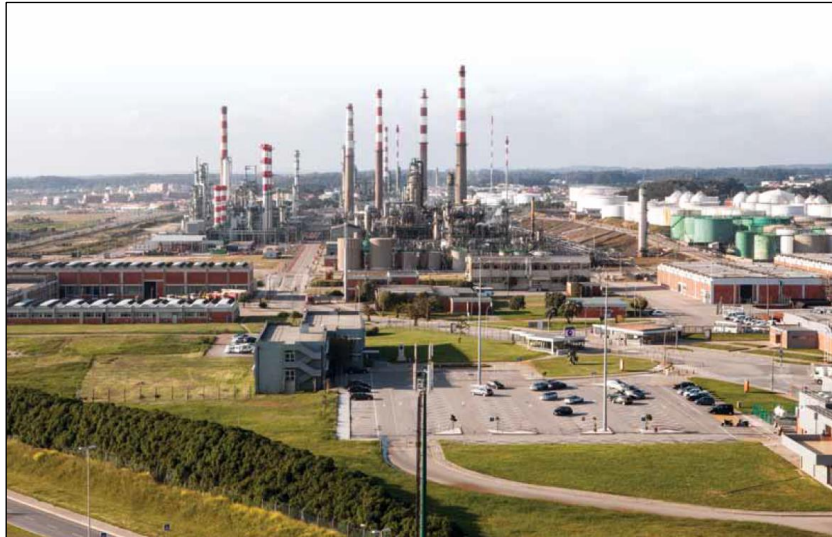
Figura 1.1 - Vista Parcial da Refinaria de Matosinhos (Galp Energia, 2012).
