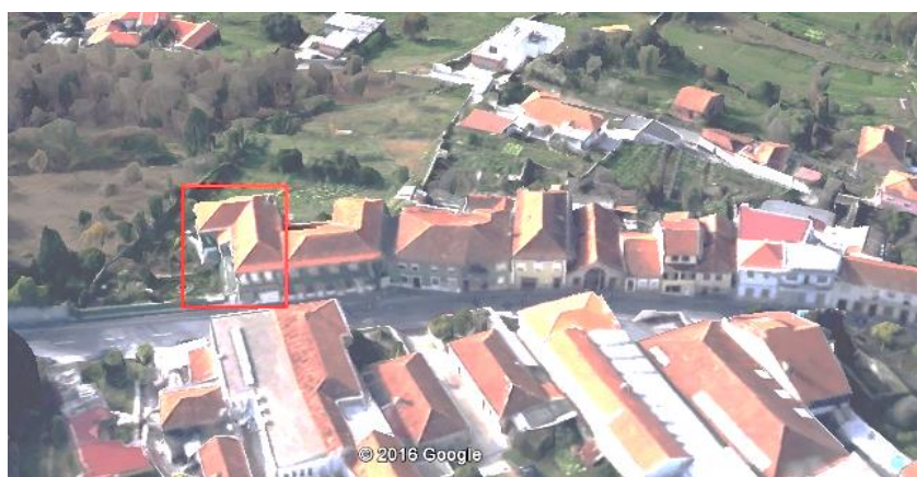
Figura 3.1 — Localização do edifício.
