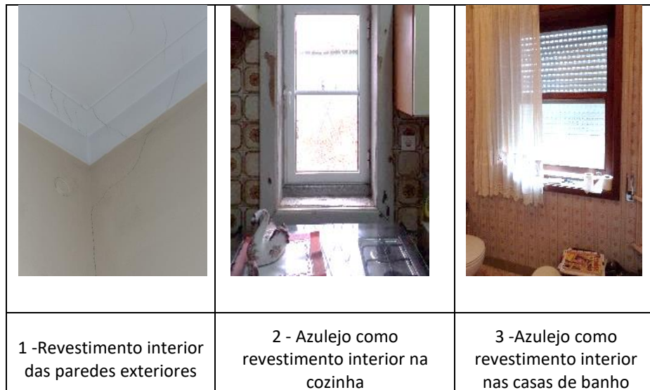
Figura 3.13 — Revestimentos interiores das paredes exteriores do piso 1,
