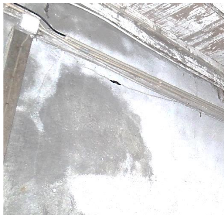
Figura 3.14 — Revestimento interior das paredes exteriores no piso 0,
