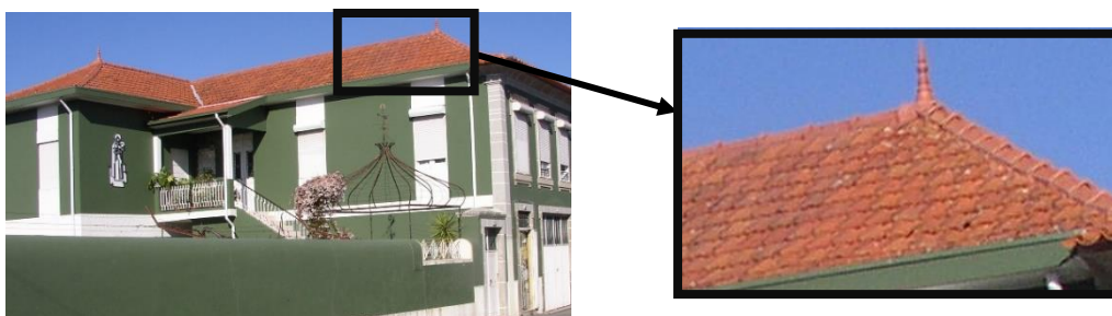
Figura 3.15 — Telha MARSELHA presente na cobertura do edifício em estudo.
