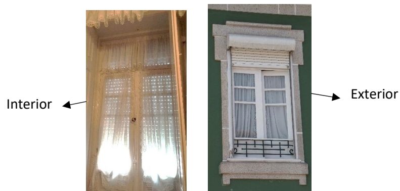
Figura 3.16 — Vãos envidraçados do edifício inicial.
