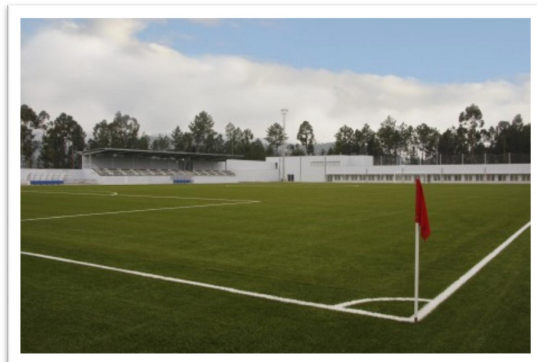
Figura 35 □ Edifício do grande campo de jogos
