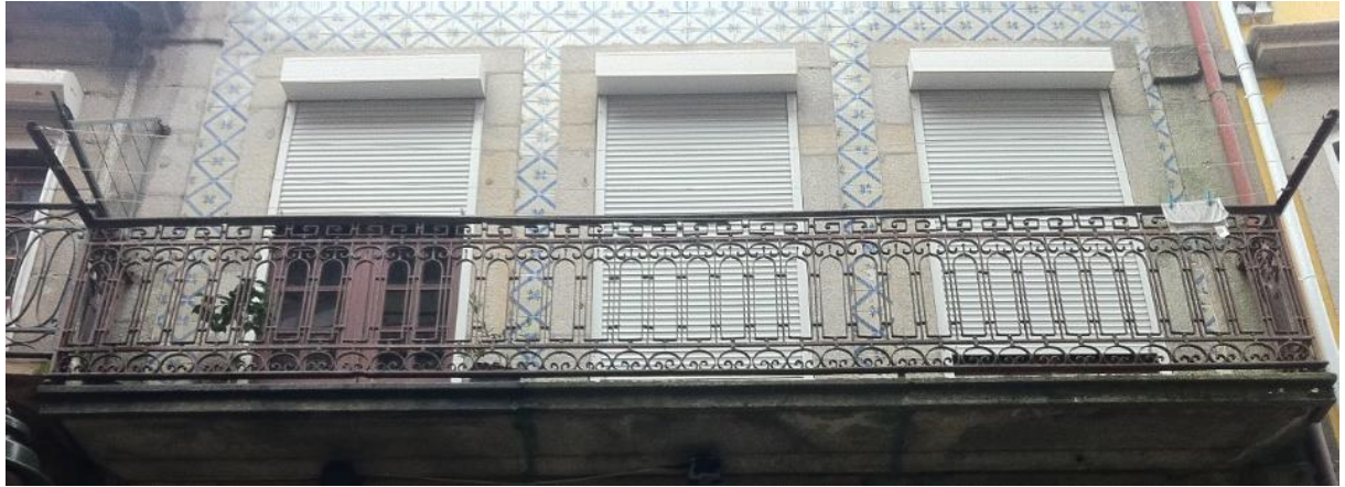
Figura 4.8 – Persianas exteriores em edifício situado na Rua do Comércio do Porto (foto do autor)
