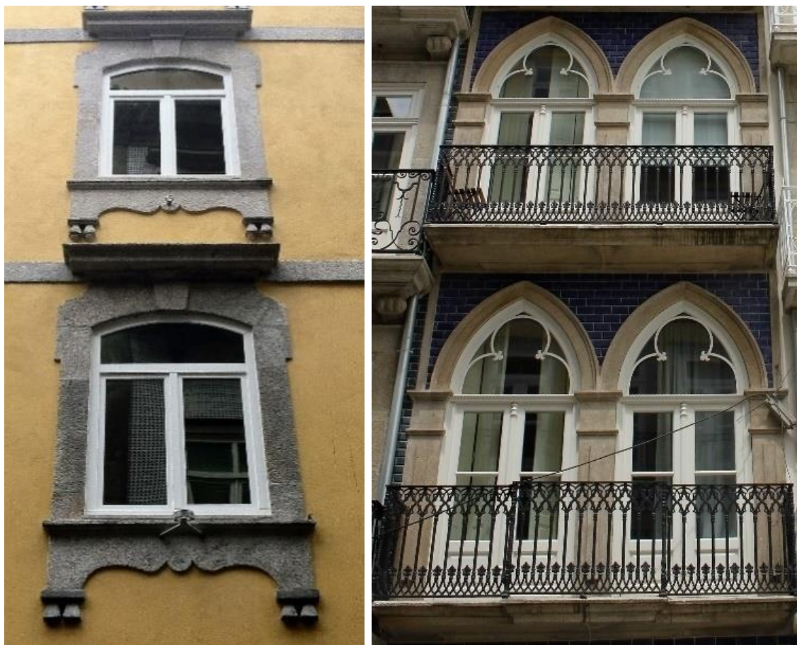
Figura 2.16 – Janelas de peito de batente na esquerda e janelas de sacada de batente em forma de ogiva na direita, situadas no Porto (fotos do autor)
