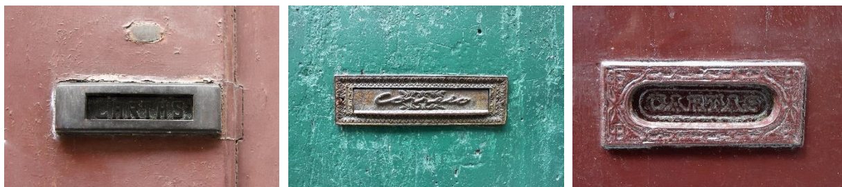
Figura 2.13 – Abertura de caixas de correio em portas (fotos do autor)
