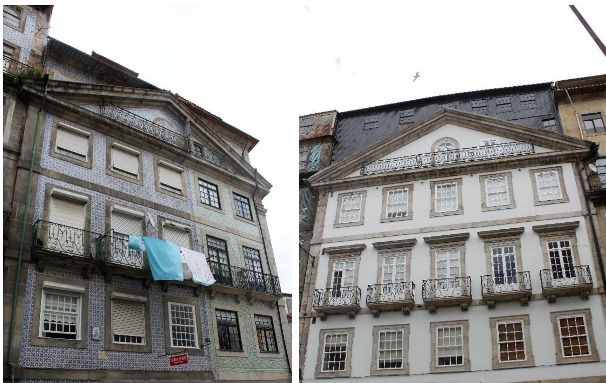
Figura 4.3 – Fachadas com revestimentos variados na Rua de S. João (fotos do autor)
