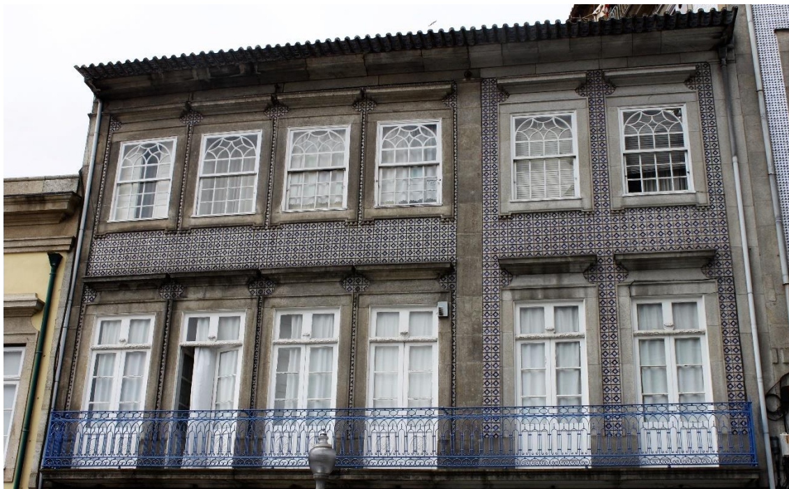
Figura 2.17 – Janelas de peito de guilhotina rehabilitadas na Rua Ferreira Borges (foto do autor)
