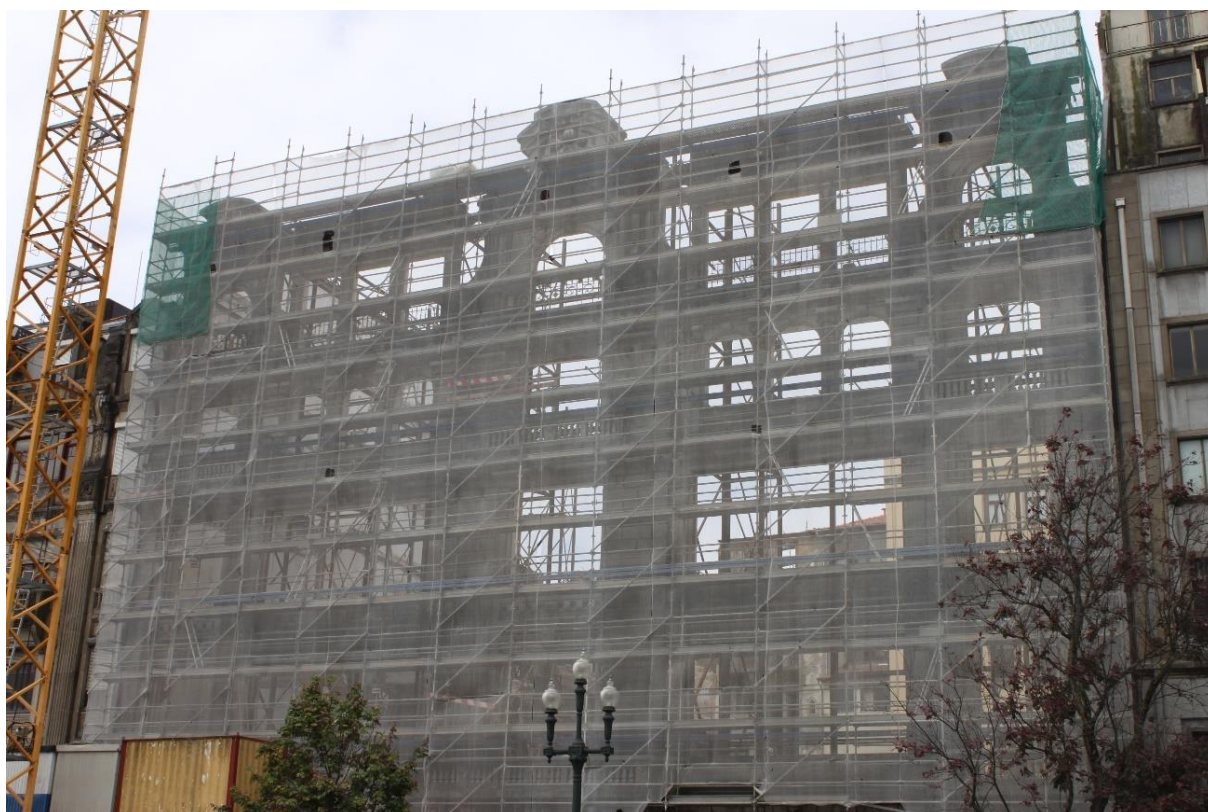
Figura 1.4 –Obra em execução na Praça da Liberdade (foto do autor)
