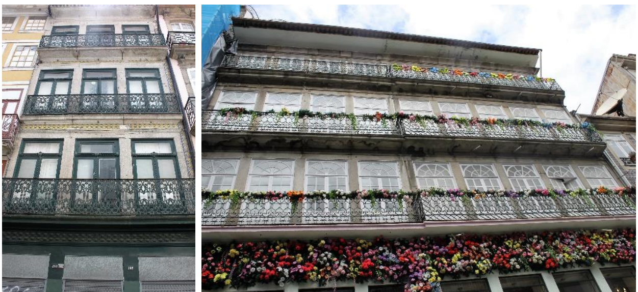
Figura 4.9 – Fachadas com guardas reabilitadas na Rua das Flores (fotos do autor)
