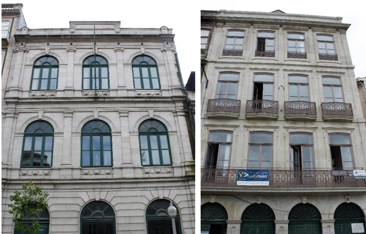
Figura 4.2 – Edifícios antigos com elementos estruturais de pedra (fotos do autor)
