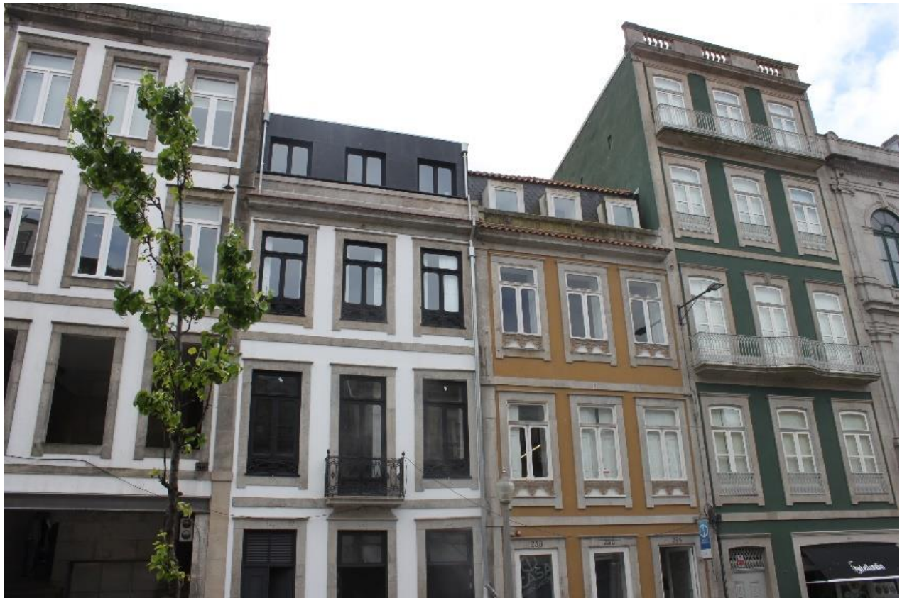
Figura 4.5 – Fachadas com revestimento a pintura na Rua Mouzinho da Silveira (foto do autor)
