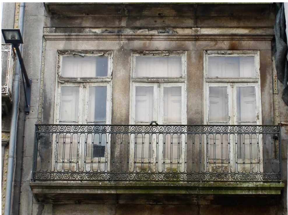
Figura 3.16 – Cantarias com sujidade na Rua Mouzinho da Silveira (foto do autor)
