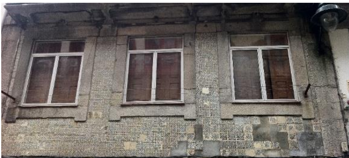
Figura 3.12 – Fachada com anomalias em azulejo na Rua do Comércio do Porto (foto do autor)
