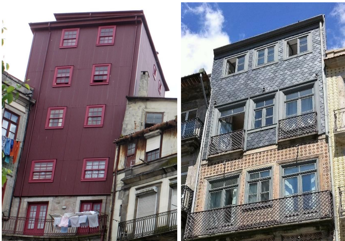
Figura 4.4 – Soletos de ardósia em fachadas de edifícios antigos no Porto (fotos do autor)
