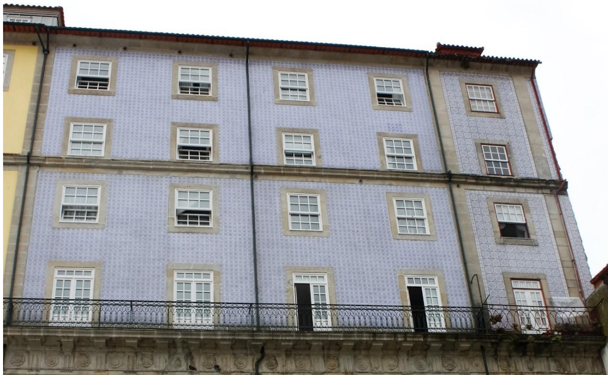
Figura 4.6 – Caixilharias de madeira de janelas de peito de guilhotina e janelas de sacada de batente reabilitadas em edifício situado na Praça da Ribeira (foto do autor)
