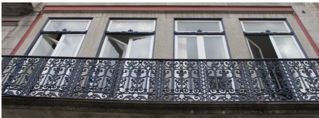
Figura 2.21 – Guarda reabilitada na Rua Mouzinho da Silveira (foto do autor)
