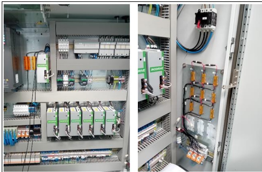
Figura 63 - Sistema de Inodrives (à esquerda) vs Sistema de Resistências (à direita)
