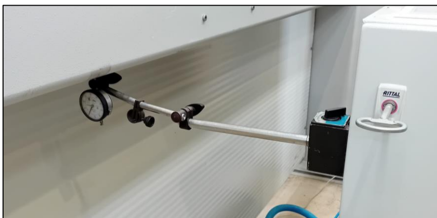
Figura 40 - Relógio Comparador Instalado no Montante Direito
