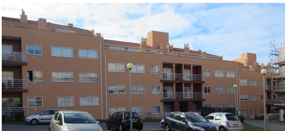
Figura 1.6- Edifício recente (Exemplo C)
