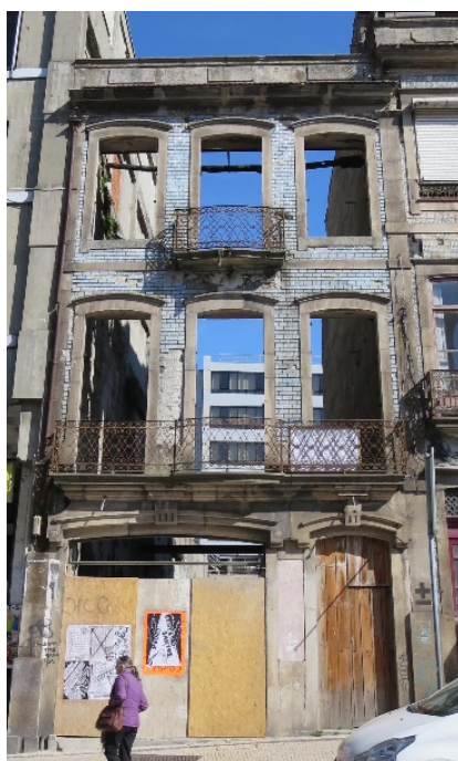
Figura 1.2- Edifício antigo (Exemplo B)
