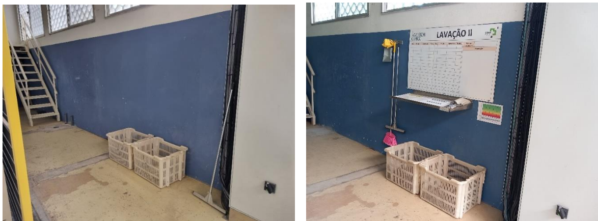
Figura 30 – Antes e depois no setor dos revestimentos.
