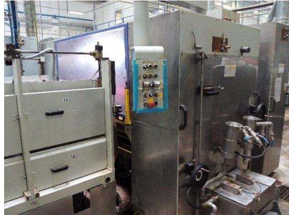
Figura 21 - Cabine de aplicação do endurecedor
