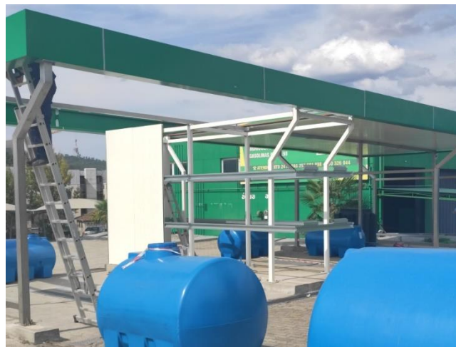
Figura 10 - Estrutura de suporte e cobertura
