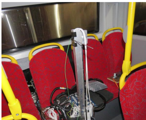
Figura 82 Sensor de temperatura interno na zona traseira do autocarro
