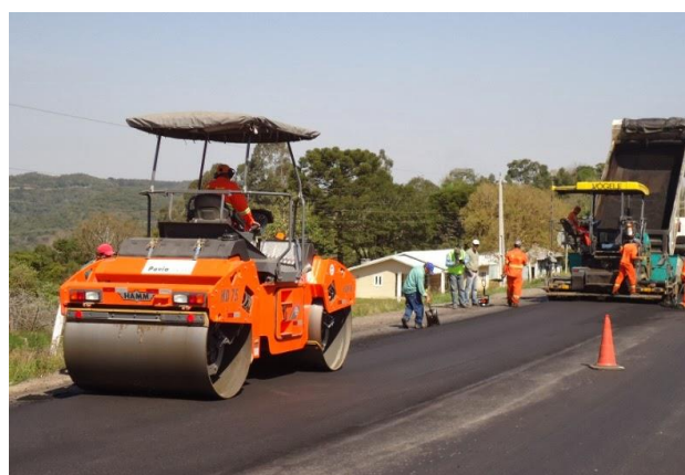
Figura 3.9 – Colocação em obra da mistura betuminosa (apresentando as três fases de aplicação) (asfaltodequalidade.pt, 2017)
