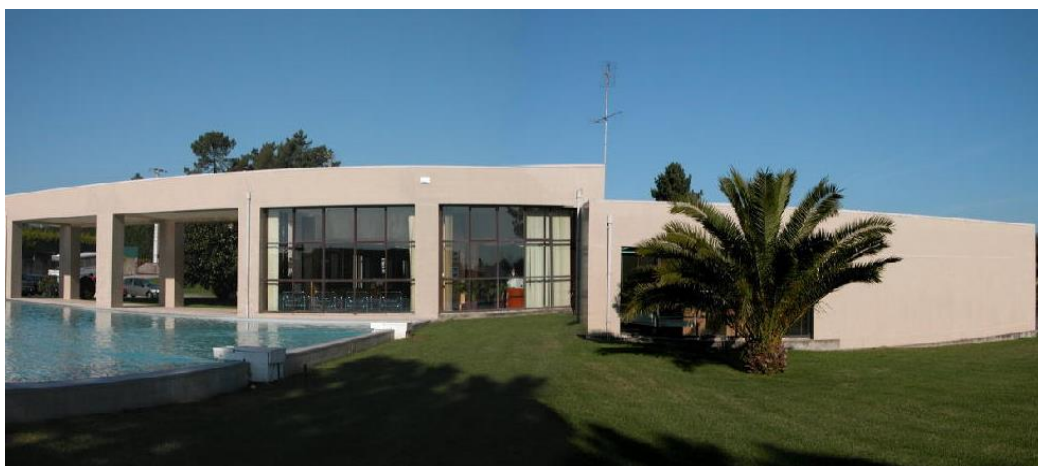
Figura 1.1 – Instalações do Ciccopn na Maia
