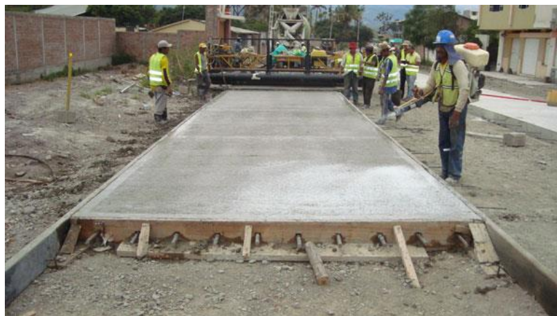
Figura 2.3 – Execução de um pavimento rígido (Oliveira,2000)
