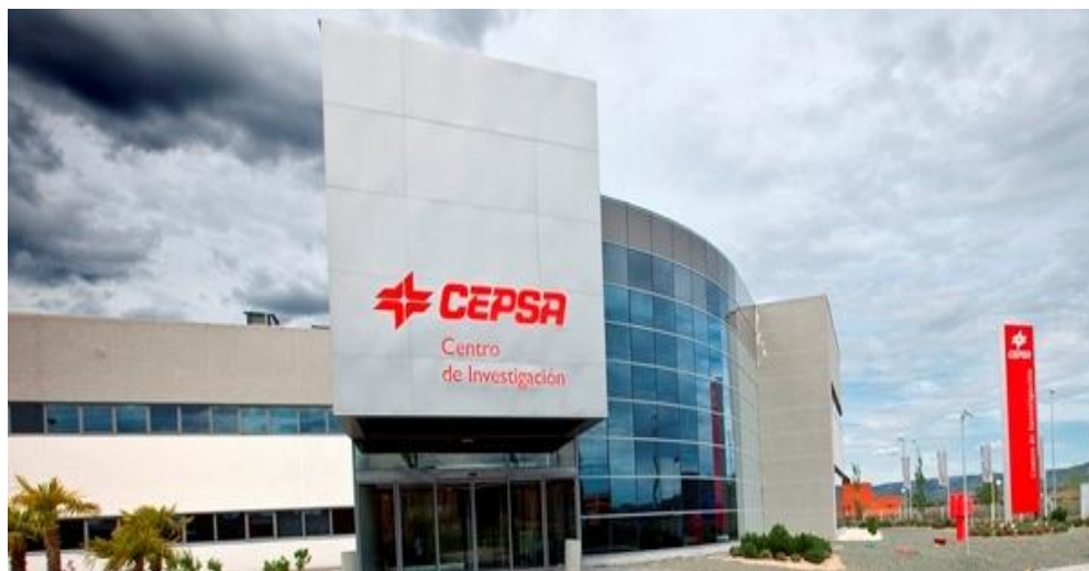
Figura 3.10 – Centro de investigação da CEPSA em Madrid (Cepsa, 2017)
