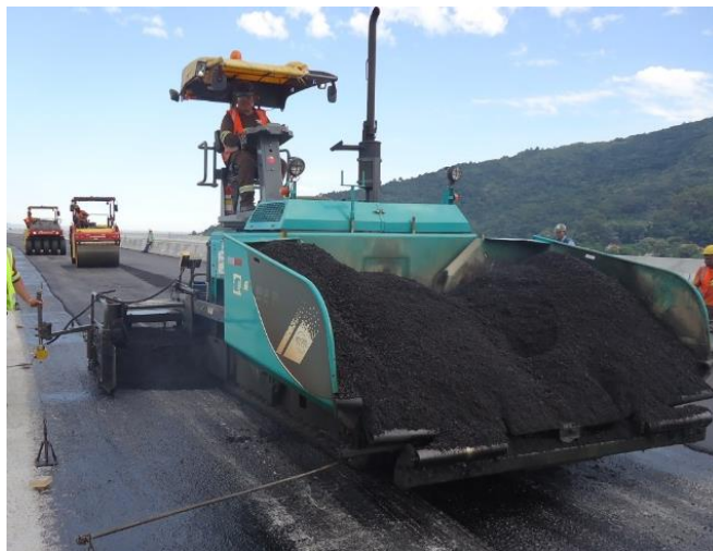
Figura 2.9 – Aplicação de mistura betuminosa a quente (asfaltodequalidade.pt, 2017)
