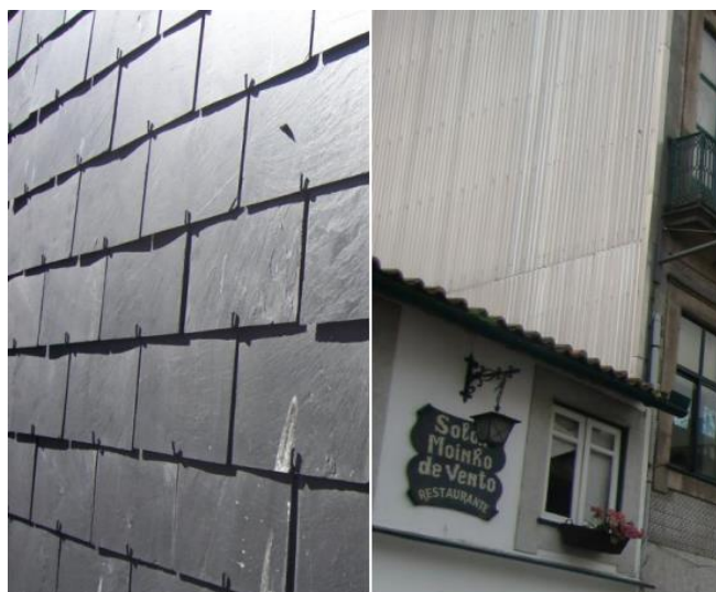
Figura 117 - Paredes de empena revestidas com soletos de ardósia e chapa zincada respetivamente
