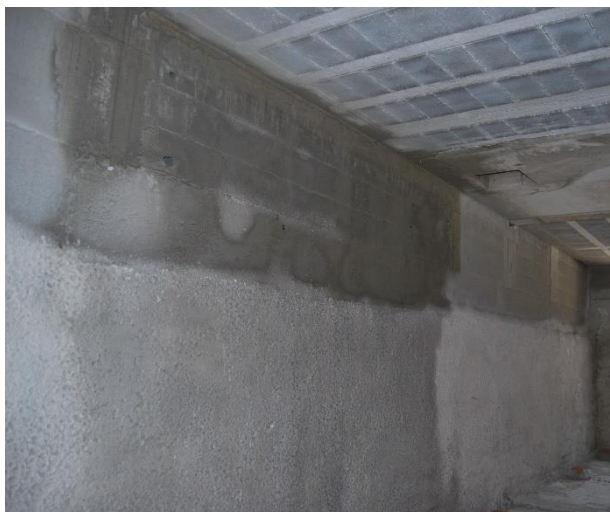
Figura 43 – Aplicação de betão projetado
