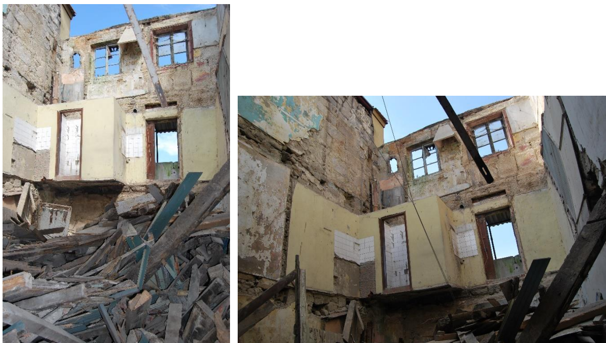
Figura 81 - Escoramento da fachada (vista do interior do edifício)
