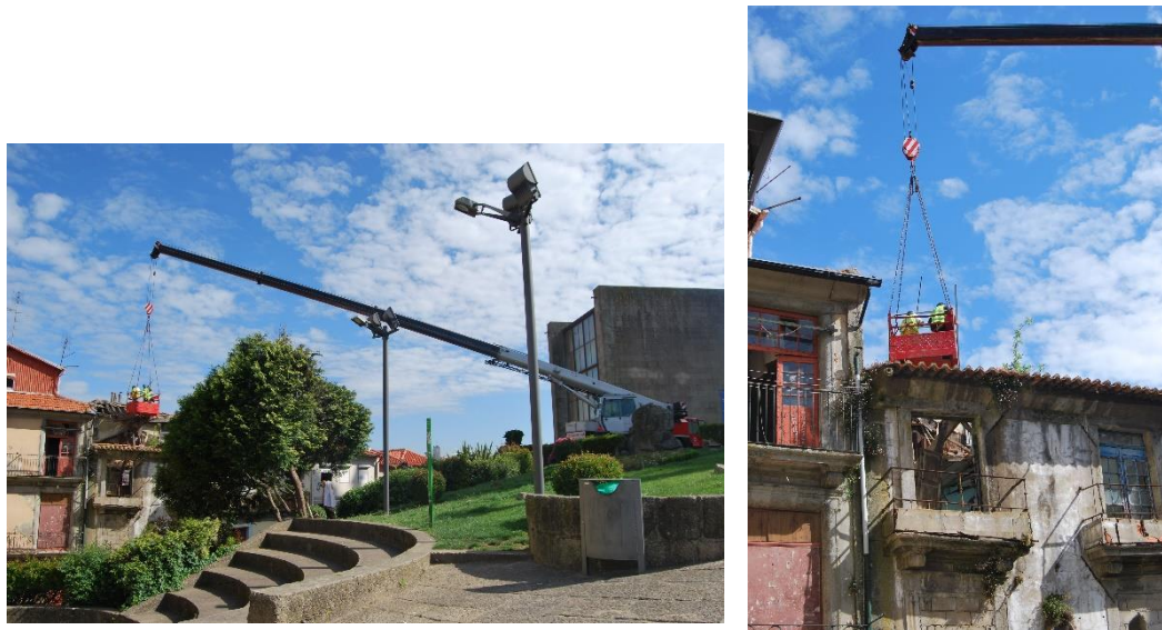
Figura 82 - Realização dos trabalhos com acesso a grua móvel
