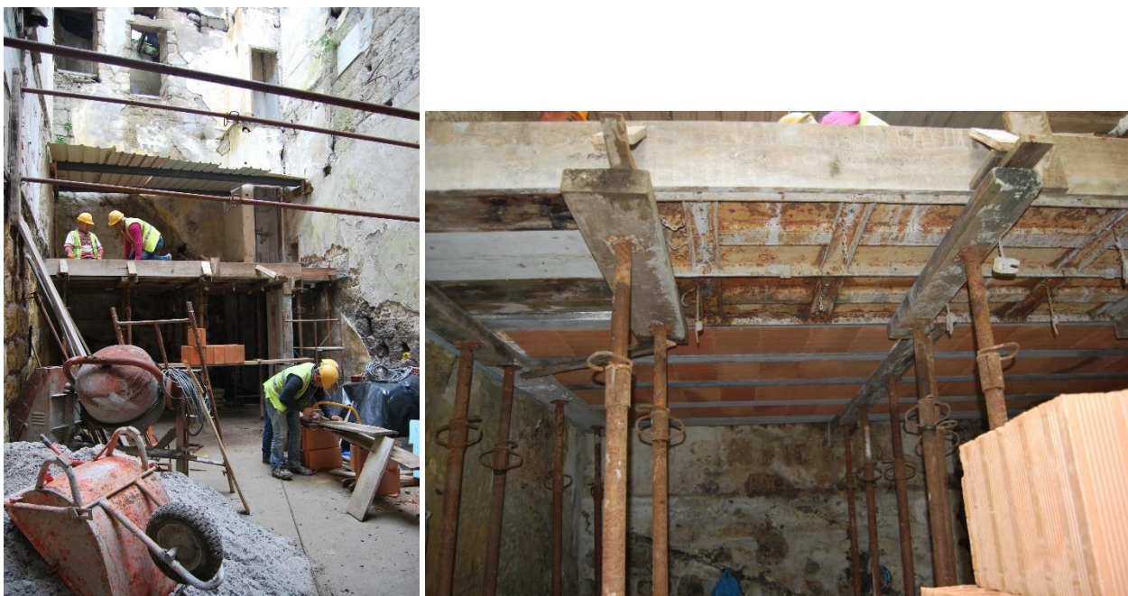
Figura 17 - Execução da laje do piso 1
