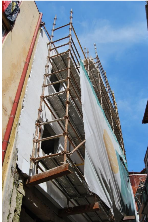
Figura 48 - Aplicação do sistema ETICS na fachada do edifício
