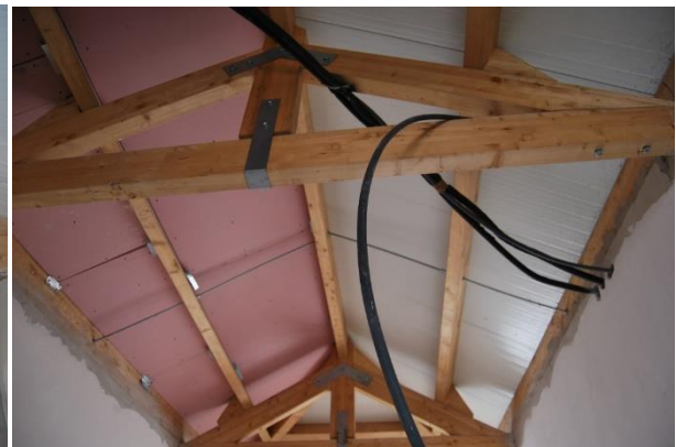
Figura 66 – Colocação das placas de gesso cartonado de proteção ao fogo
