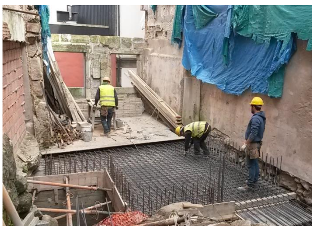
Figura 53 - Colocação de armaduras
