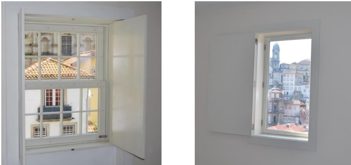
Figura 102 - Vista real das caixilharias da sala e quarto, respetivamente
