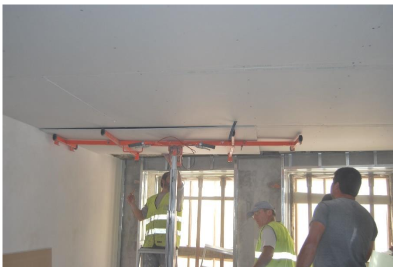
Figura 73 - Colocação das placas de gesso cartonado
