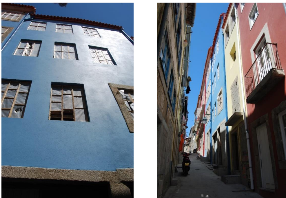
Figura 74 - Fachada da Operação H após pintura
