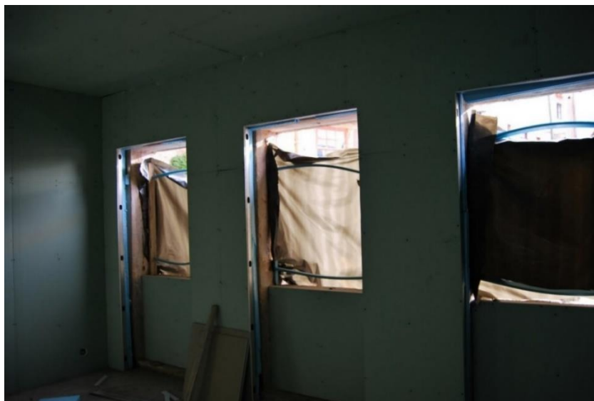
Figura 99 - Paredes em placas de gesso cartonado com XPS no seu interior (sala)
