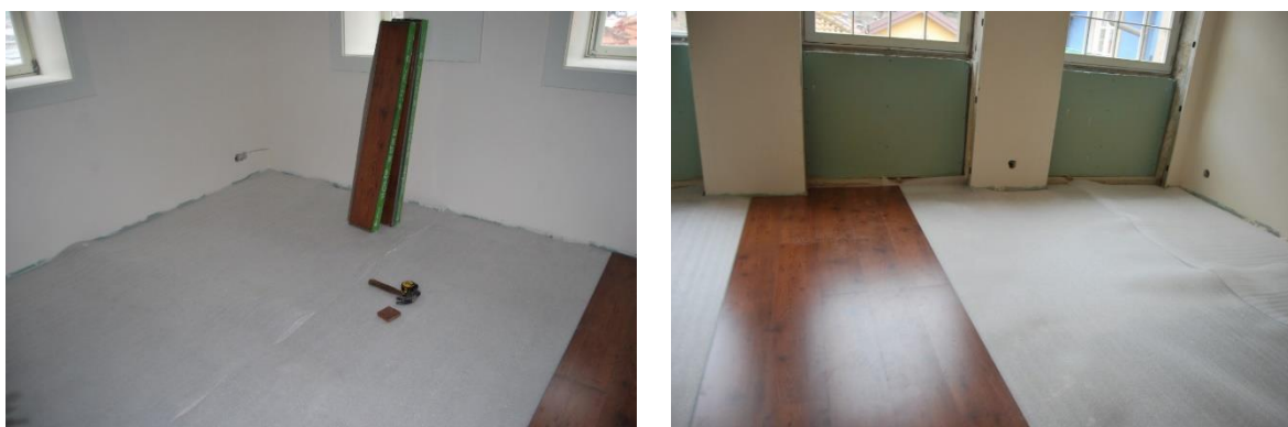
Figura 109 - Colocação do soalho flutuante sobre a espuma de polietileno
