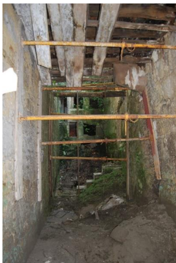
Figura 77 – Escoramento de uma das parcelas do Quarteirão da Bainharia
