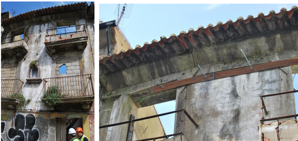
Figura 80 - Escoramento da fachada do edifício
