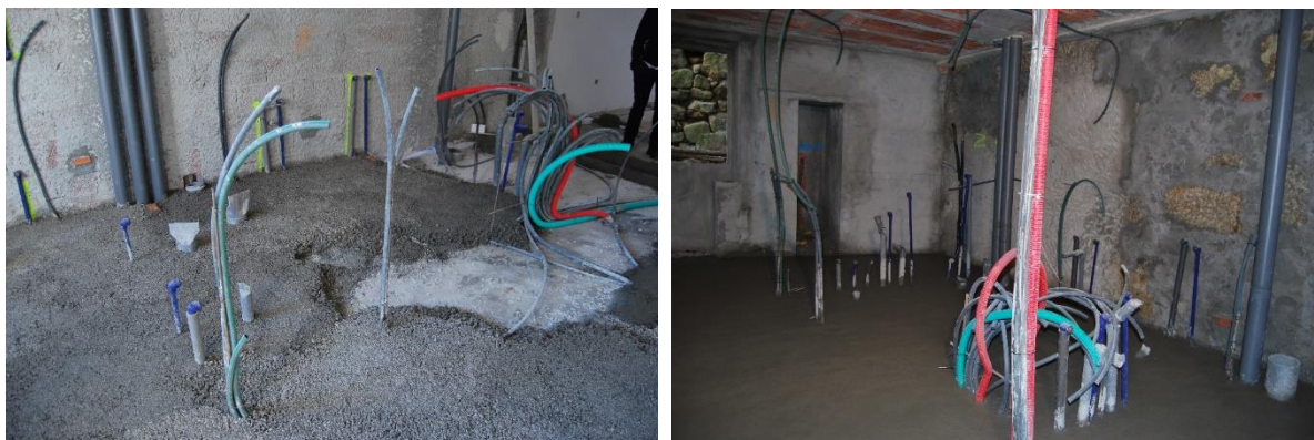
Figura 62 - Aplicação da camada de regularização
