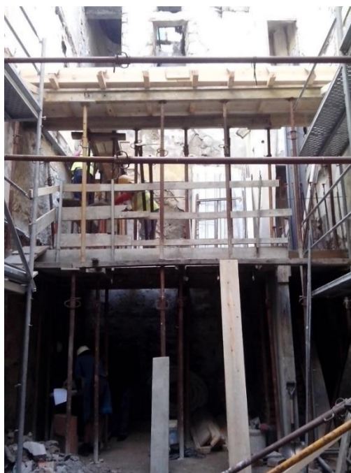
Figura 18 – Execução da laje do piso 2
