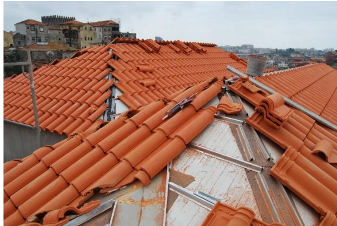
Figura 64 - Colocação da telha cerâmica
