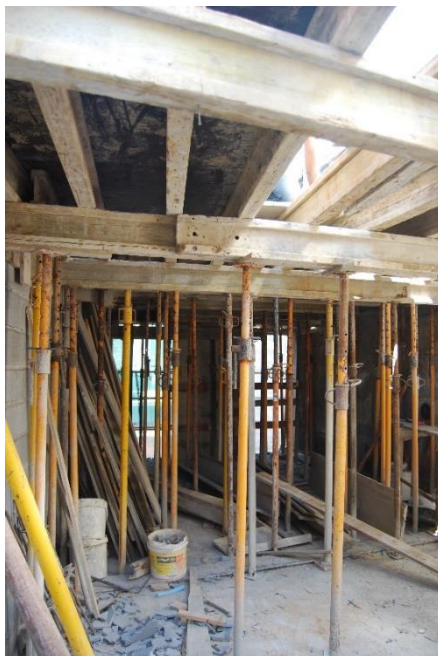
Figura 55 - Execução da laje do piso 2
