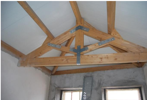
Figura 65 - Pormenor da asna de madeira
