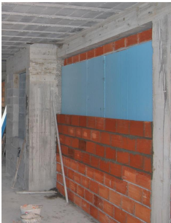
Figura 45 - Aplicação do isolamento (XPS) na parede interior
