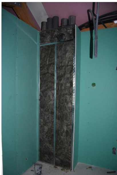
Figura 69 - Preenchimento da courette com lã de rocha
