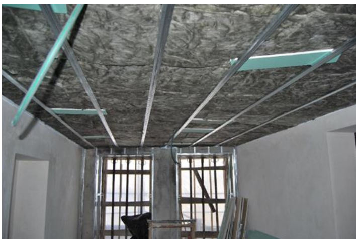
Figura 71 – Isolamento do teto em lã de rocha
