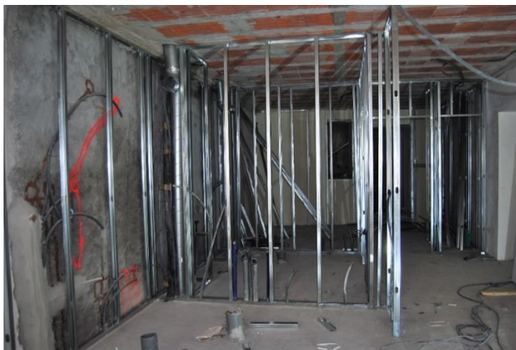
Figura 67 – Colocação das estruturas portantes para a construção de paredes interiores
