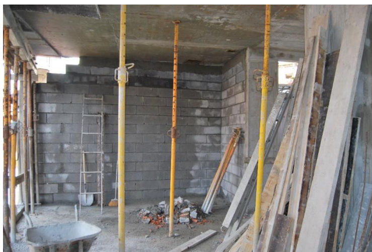
Figura 46 - Parede em bloco de betão
