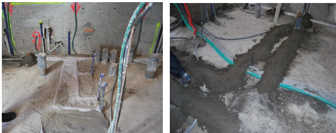
Figura 61 - Proteção das tubagens da rede de abastecimento de água
