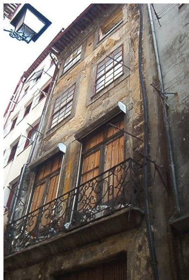
Figura 19 - Fachada da Operação C – Projeto 4 antes de intervenção
