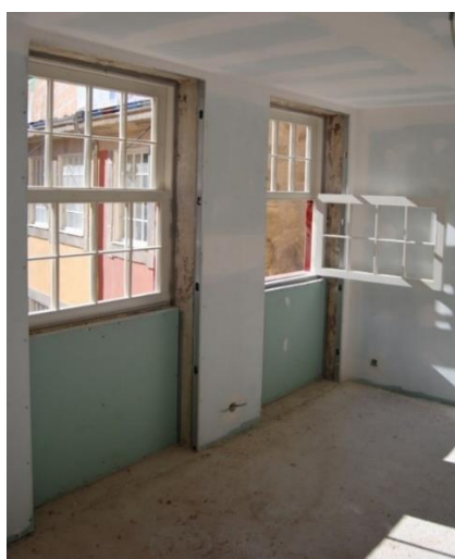
Figura 100 - Paredes em placas de gesso cartonado (sala)
