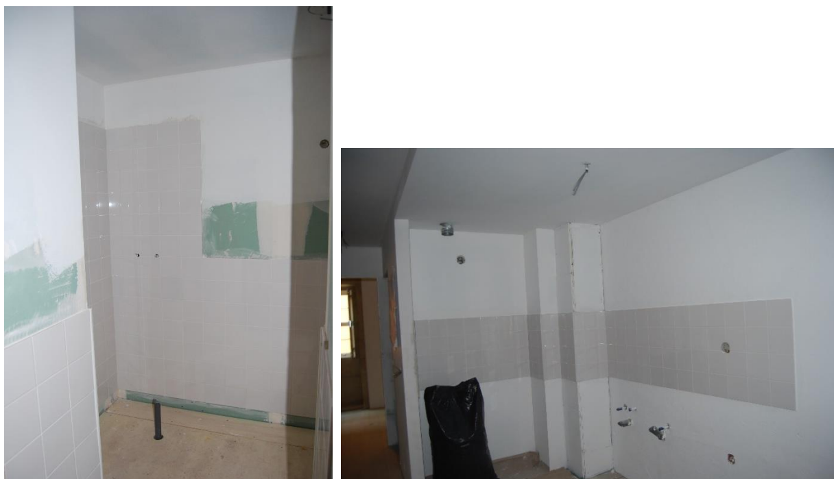
Figura 27 - Aplicação de azulejos no WC e cozinha, respetivamente
