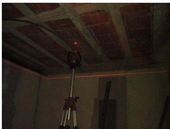
Figura 70 - Nivelamento do teto falso
