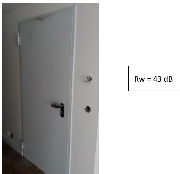
Figura 105 - Porta de entrada para a habitação
