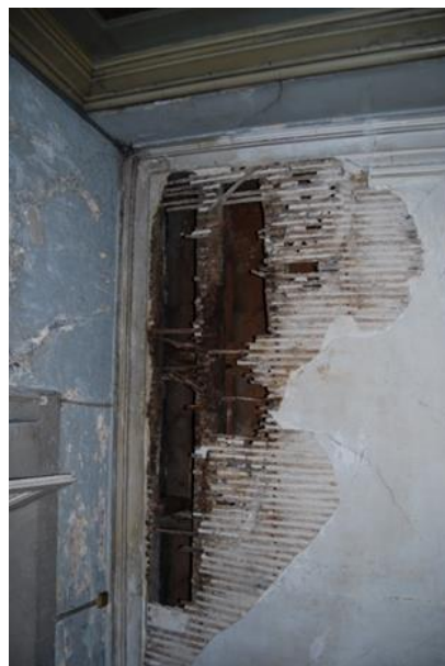
Figura 10 – Pormenor do teto do edifício
