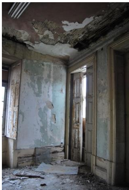
Figura 9 – Interior do edifício
