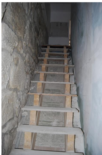
Figura 28 - Caixa horizontal comum de acesso aos pisos
