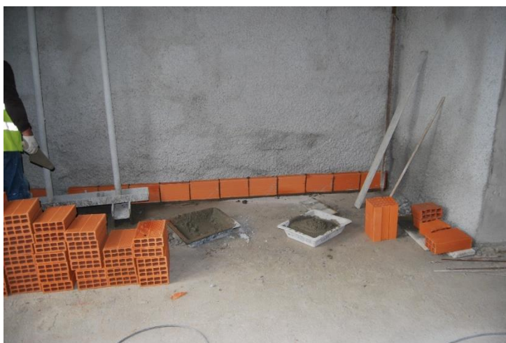
Figura 44 - Execução da parede de alvenaria de tijolo
