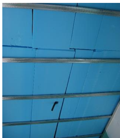
Figura 72 – Isolamento do teto da lavandaria em placas XPS
