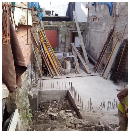
Figura 54 - Laje de piso após betonagem
