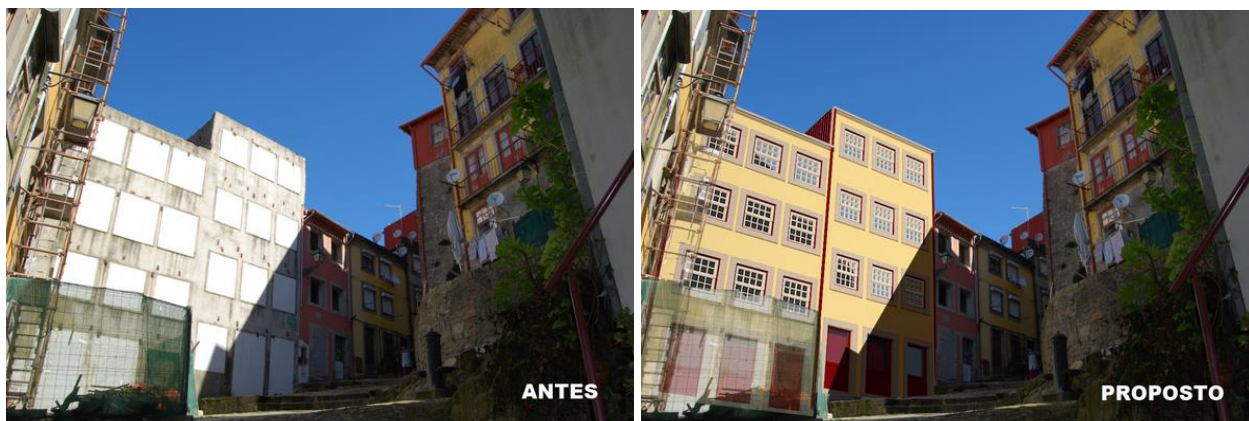
Figura 29 - Fachada Principal da Operação E2 antes das obras e o proposto (Fonte: Porto Vivo, SRU)
