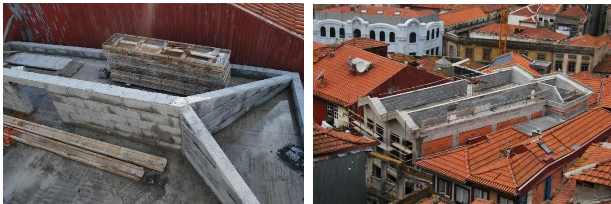
Figura 50 - Execução da cobertura
