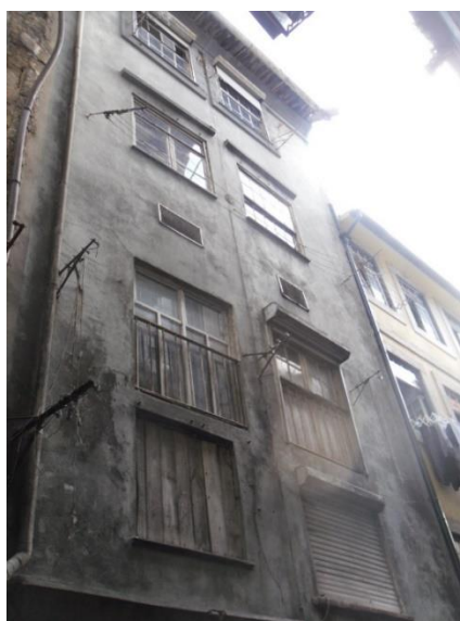
Figura 16 - Fachada da Operação C – Projeto 3 antes de intervenção (Fonte: Porto Vivo, SRU)
