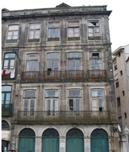
Figura 8 - Fachada Principal do edifício da Rua Mouzinho da Silveira
