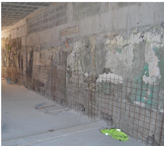
Figura 42 – Colocação da armadura para posterior aplicação de betão projetado
