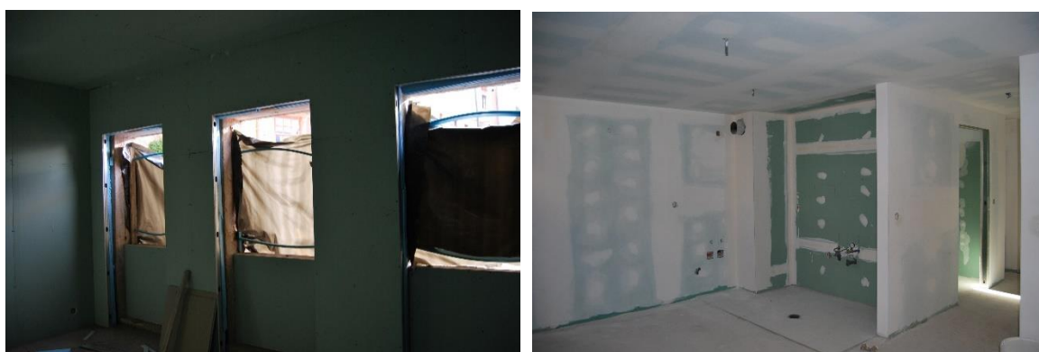
Figura 31 - Paredes interiores em placas de gesso cartonado
