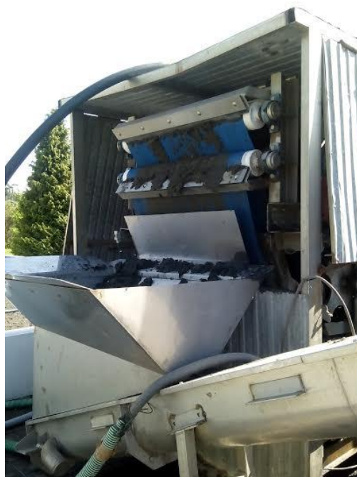
Figura 4.11 – Filtro de banda da ETAR das Termas de S.Vicente
