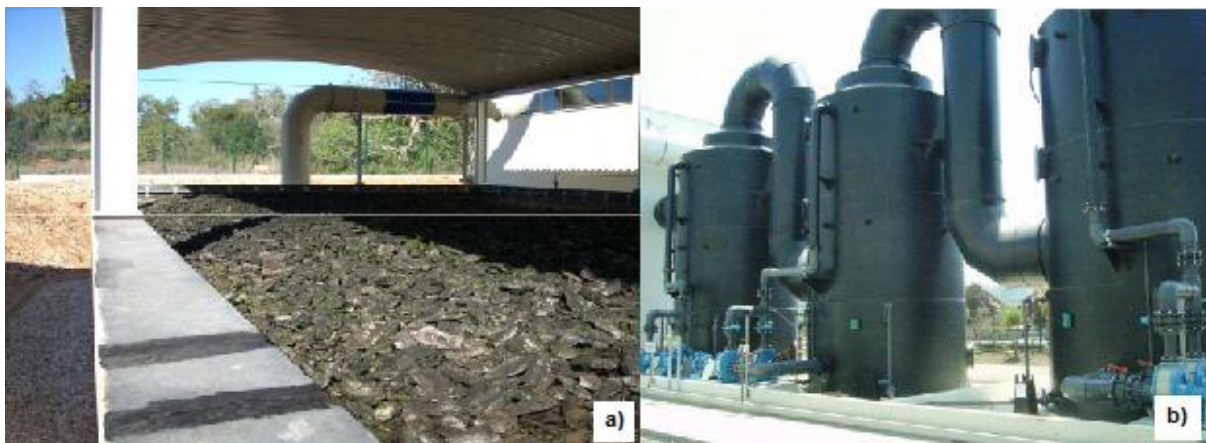
Figura 3.3 – Tratamentos de odores: a) Desodorização por biofiltração; b) Desodorização por lavagem química [29]
