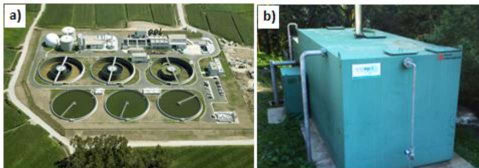
Figura 2.1 – Tipos de ETAR: a) convencional; b) compacta - adaptada [8] [9]
