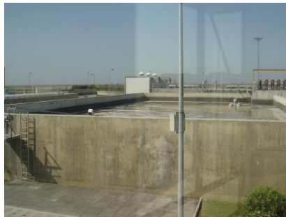
Figura 2.2 – Tanque de equalização
