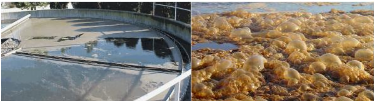
Figura 3.1 – “Bulking” filamentoso e Espumas castanhas, respetivamente [9]
