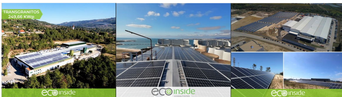
Figura 8 - Instalação de painéis fotovoltaicos pela Ecoinside
