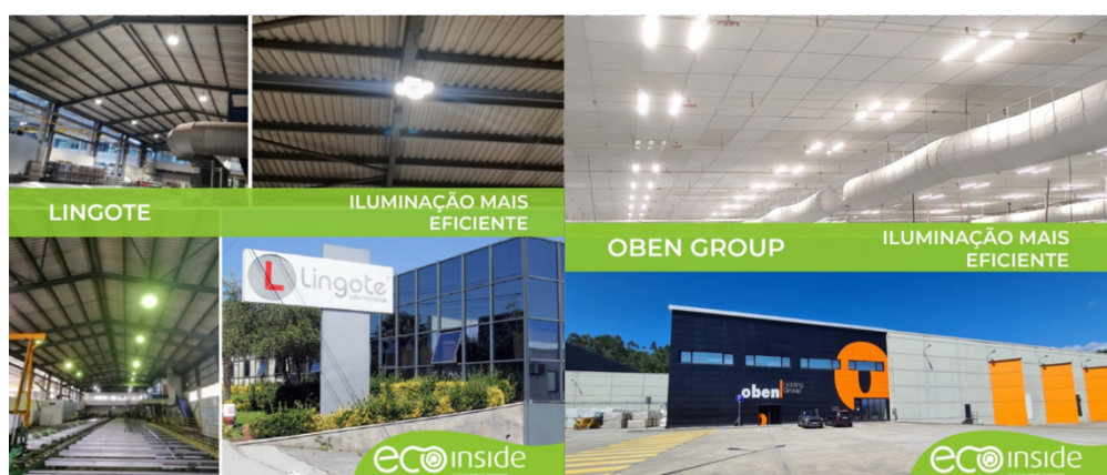
Figura 9 - Instalação de iluminação LED pela Ecoinside
