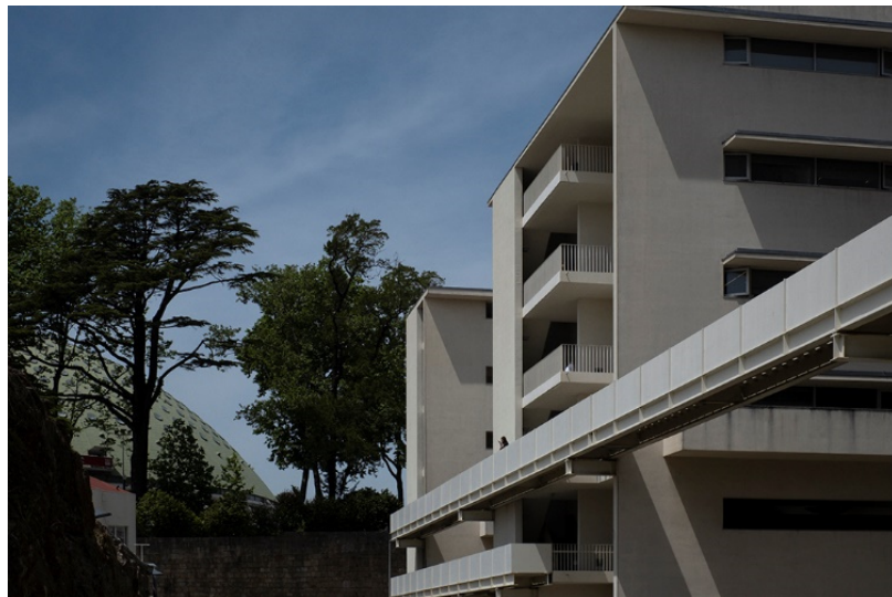
Figura 5 – Edifício do ICBAS Créditos: Luís Barbosa para ICBAS
