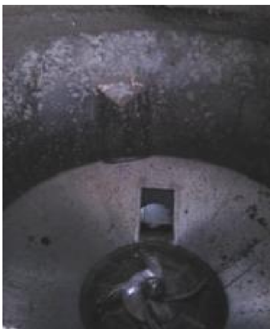
Figura 4.2 – Pulper da Ponte Redonda
