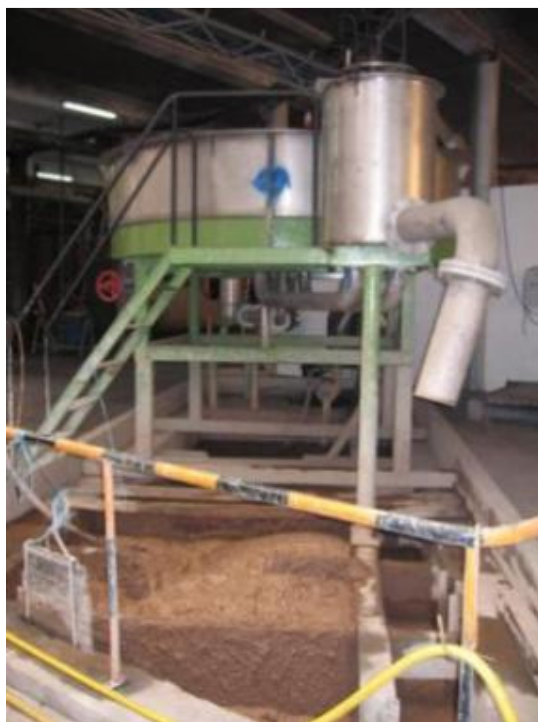
Figura 6.4 - Instalação do Flutuador na Ponte Redonda
