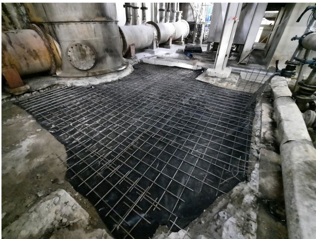
Figura 4.39 – Colocação da armadura inferior do pavimento térreo da refinaria
