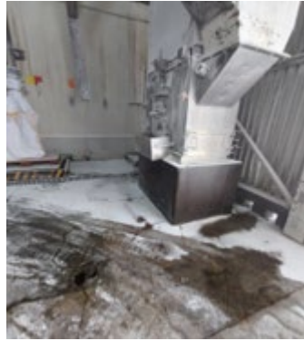
b) Fissuração do pavimento
