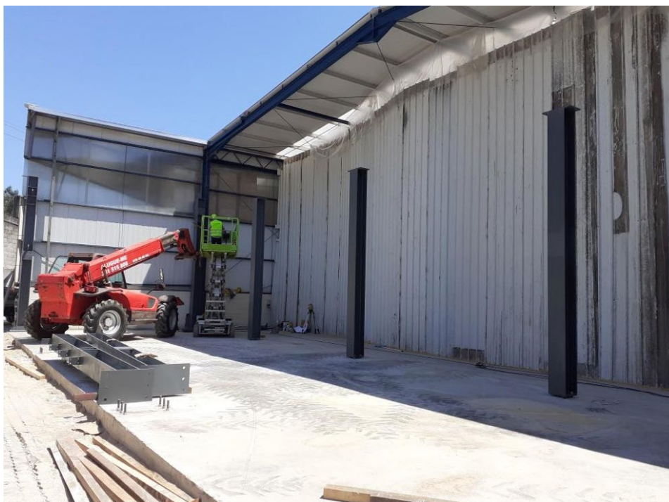
Figura 3.41 – Ensoleiramento betonado e primeiros troços dos pilares
