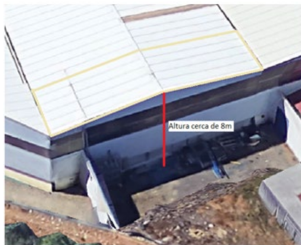
b) Vista das traseiras do armazém a reconstruir com zona a refazer assinalada a amarelo
