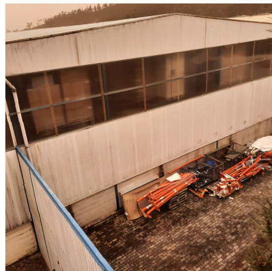
b) Vista frontal do armazém
