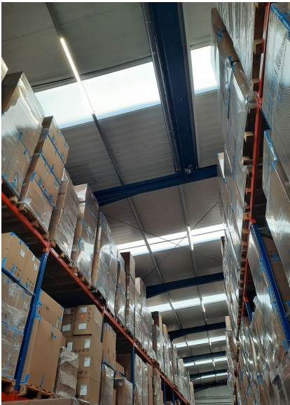
a) Vista da cobertura existente
