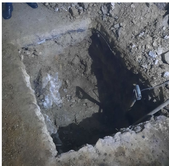
Figura 4.20 – Poço de reconhecimento executado no pavimento da refinaria
