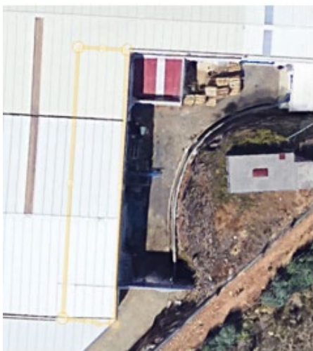
a) Vista aérea do armazém com zona a refazer assinalada a amarelo
