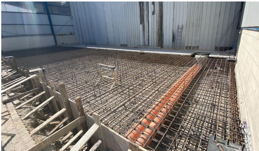
Figura 3.40 – Posicionamento das armaduras do ensoleiramento geral em obra
