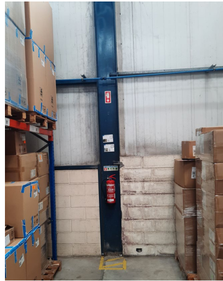
b) Vista junto ao pilar existente da fachada
