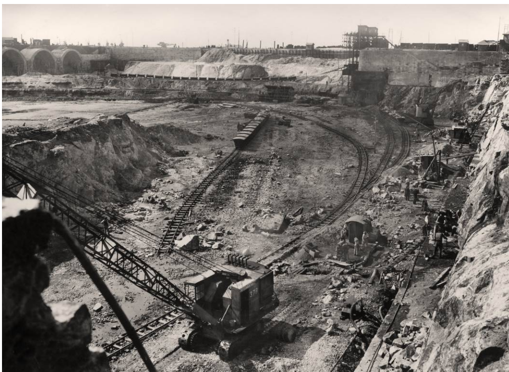
Figura 19 - Imagem da construção da Doca N.º1 Norte _ Arquivo da APDL
