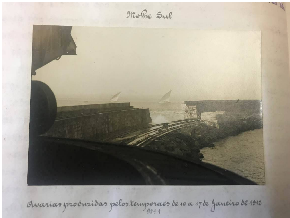
Figura 13 – Avarias Produzidas pelos temporais de 10 a 17 de Janeiro de 1912_SUL _ Imagem de Autor
