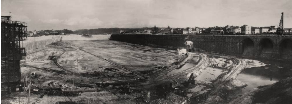
Figura 21 - Doca 1 Norte _ Execução Obra _ Arquivo da APDL
