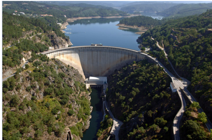
Figura 4.4: Vista superior da Barragem do Cabril [1]
