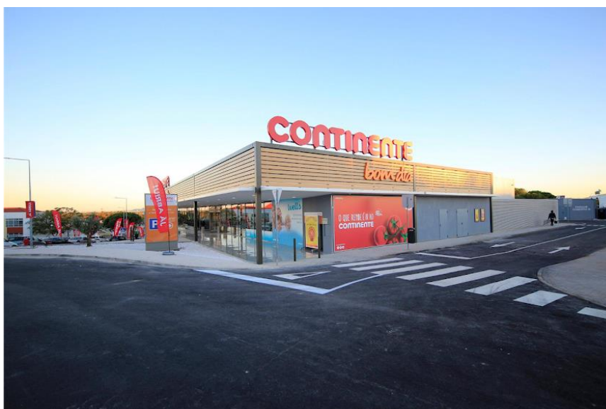
Figura 2.2 - Exemplo de um edifício de retalho alimentar
