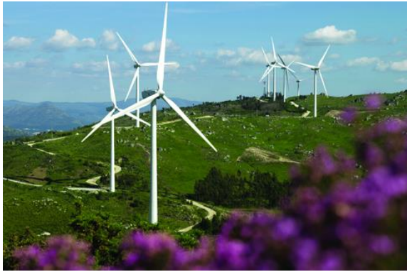
Figura 4 Parque eólico de Fafe [71]
