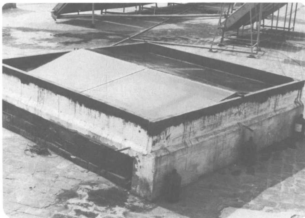
Figura 17 – Exemplo de construção para solução 1. [61]
