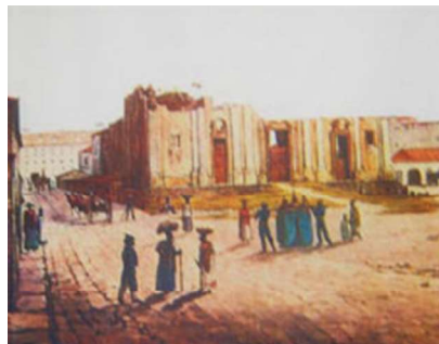
Figura 2 - Construção da Academia Real Militar em 1810
