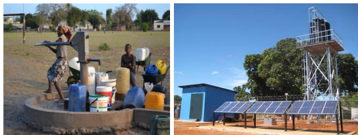
Figura 46 – Sistemas de bombeamento de água (manual e solar, respetivamente) (Fonte: Estratégia de Desenvolvimento do Sector de Águas de Moçambique)
