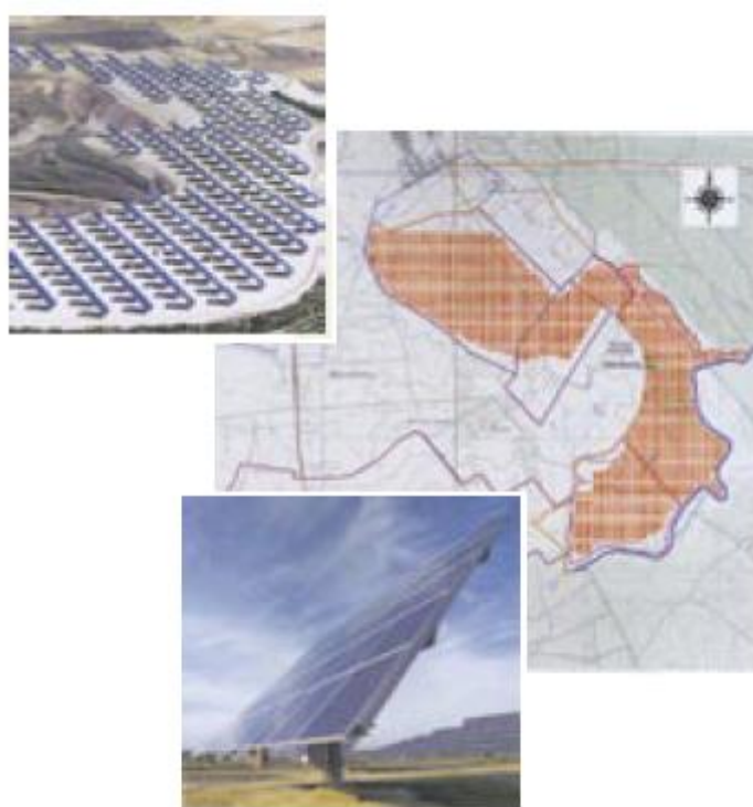
Figura 1.2. Central fotovoltaica (Moura) [7]
